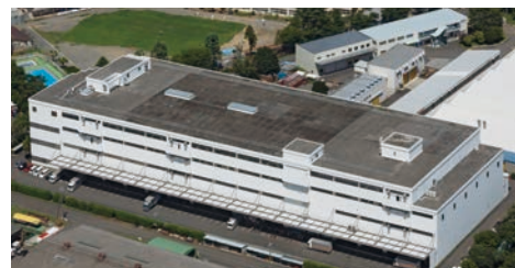
IIF昭島ロジスティクスセンター
