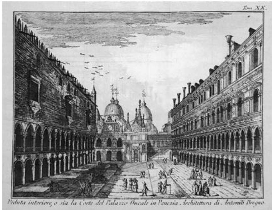
_ Figura 190. Giambattista Albrizzi, Veduta interiore, o sia la Corte del Palazzo Ducale in Venezia . Architettura di Antonio Bregno (da S. Thomas, Lo stato presente di tutti i paesi e popoli del mondo naturale, politico, morale... , Venezia 1754; collezione privata).
