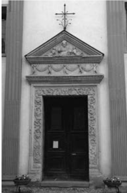
Figura 57. Ditte Solari di Carona, portale maggiore, Castiglione Olona, Chiesa del Corpo di Cristo (foto Comune Castiglione Olona).
