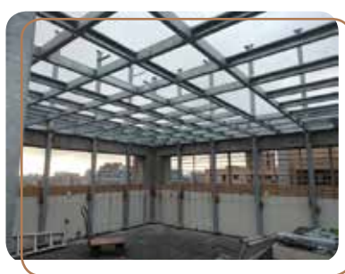
2020.10.28 施工作業照片
