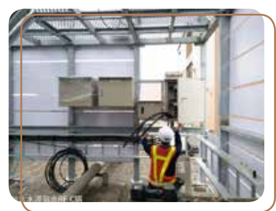
2020.11.12 施工作業照片
