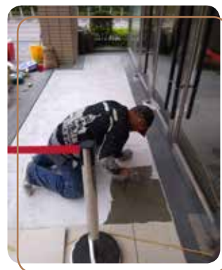
修齊大門門廳地磚修補工程
