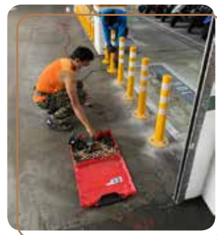
水源停車場設施防撞桿更新
