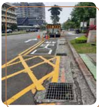
水源停車場車道導引標示劃設
