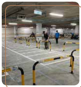
水源停車場設施口型護欄更新
