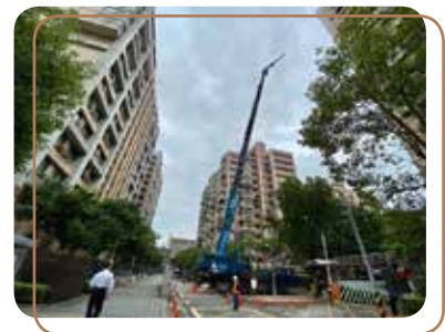
2020.10.5 開工，10.6 以吊車吊料進場
