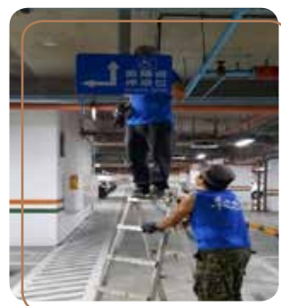
水源無障礙導引標示牌固定按裝施
