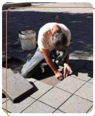
修齊中庭地磚鬆動修補
