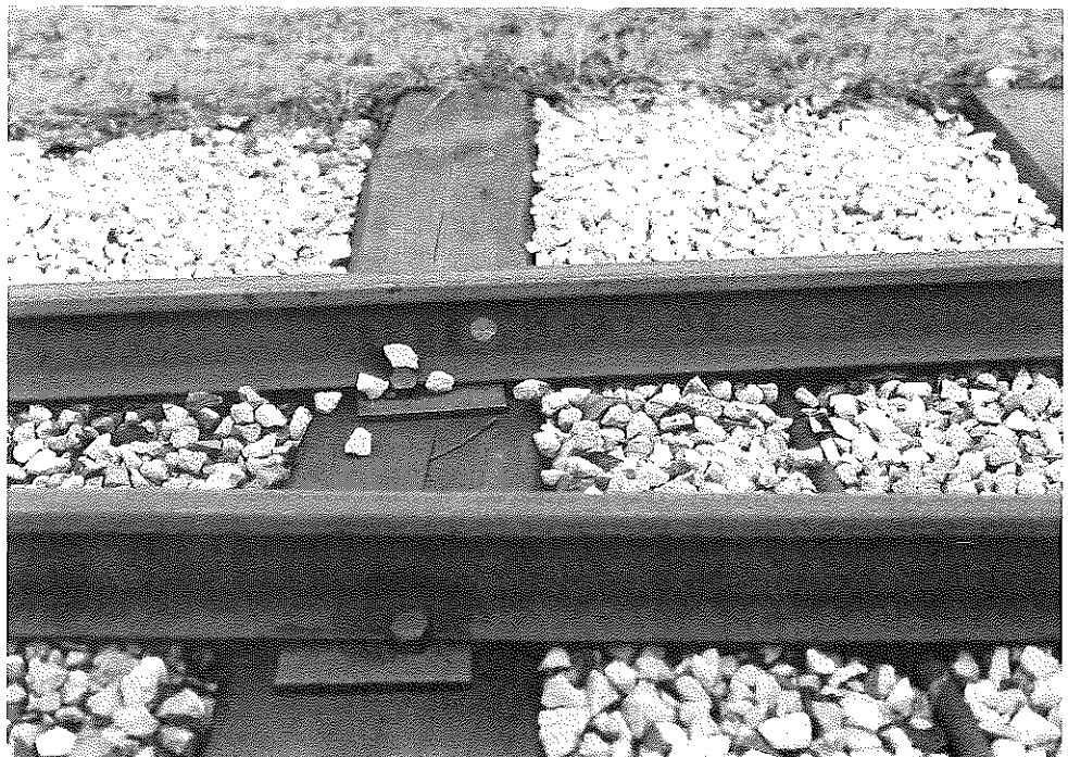
„Stahlschienen bester Qualität“ forderte der Bauvertrag. Die Tatsache, daß diese Schienen z. T. noch heute liegen, beweist, daß dieser Forderung genügt wurde. Foto: Rother
