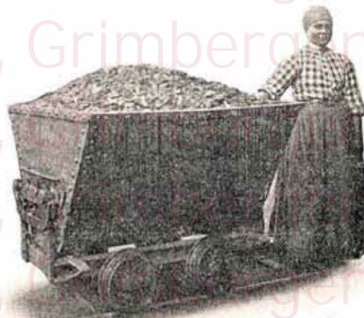
BASCULEURS ÉTROITS avec châssis intérieur, pour service de mines
