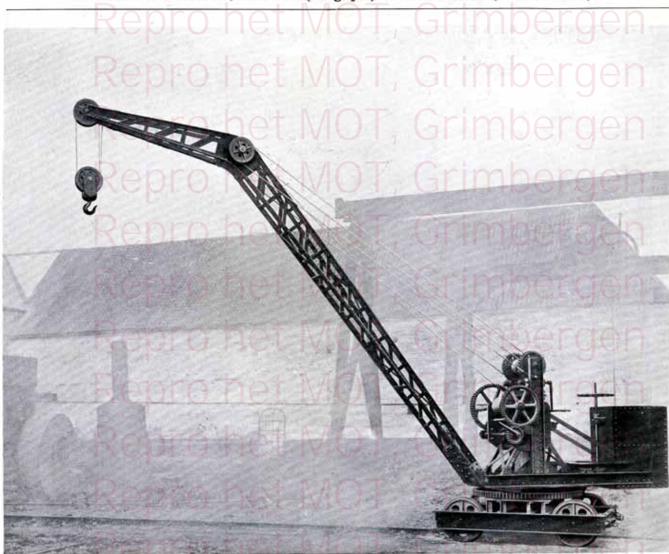
Grue à main à flèche relevable.
