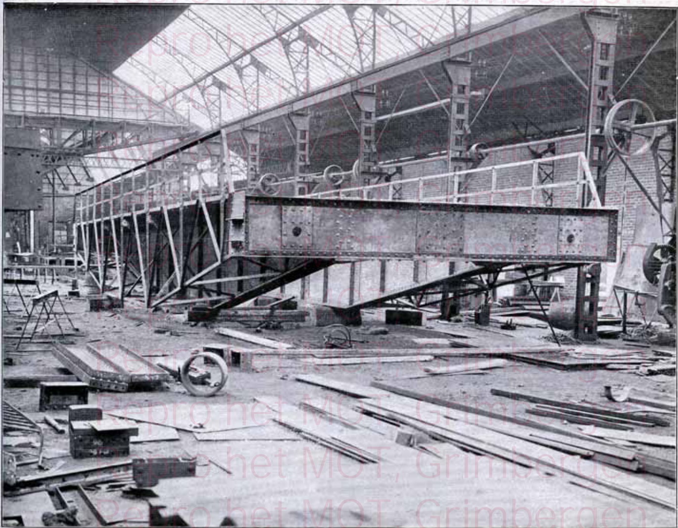
Pont roulant en construction en mes usines.
