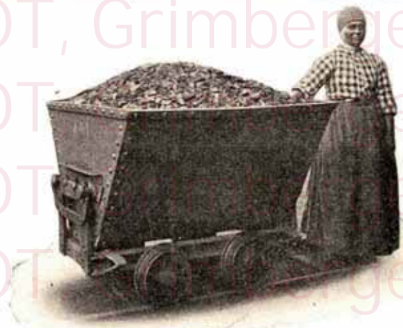
Volquete angosto con bastidor inferior para el uso en las minas
