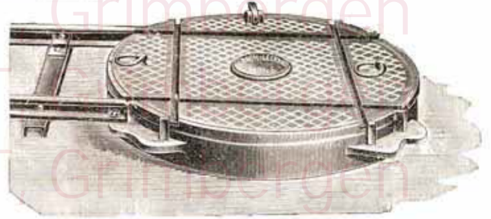
Drehscheibe auf Rollenlager
