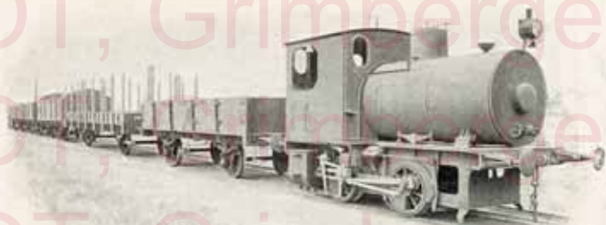
Locomotive sans foyer remorquant un train de marchandises.
