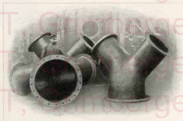
Pièces intermédiaires de la tuyauterie d'aspiration des pompes de la distribution d'eau de Cologne-Hochkirchen
