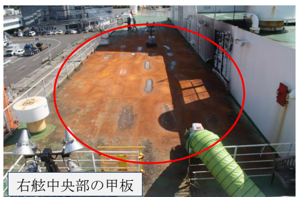
写真3 第4甲板右舷中央部の損傷状況
