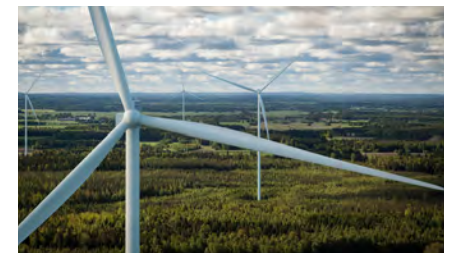
Vestas wind turbines
