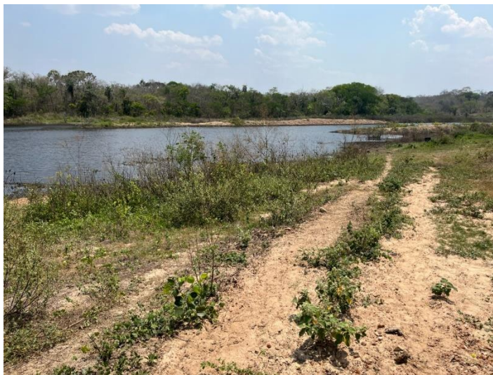
Imagen 4: Un atajado en San Fermín, San Rafael, donde la comunidad afirma que el Contratista dejó dos grandes cúmulos de sedimentos (uno de los cuales está rodeado por un círculo).
