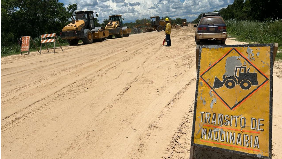
Foto 3. Mejora de la gestión del tránsito con señalización y un banderillero
