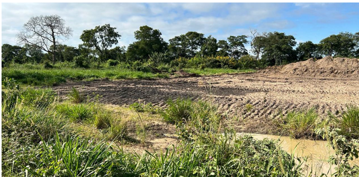
Foto 1. Banco de préstamo en proceso de cierre, pendiente de revegetación
