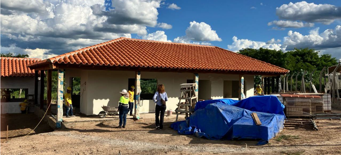
Foto 5. Construcción de un centro comunitario financiado por el PPI
