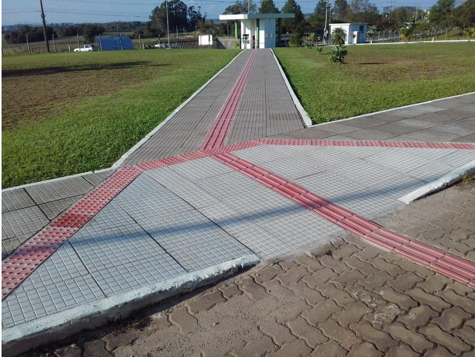
Figura 2 – Rampa para acesso a cadeirantes.
