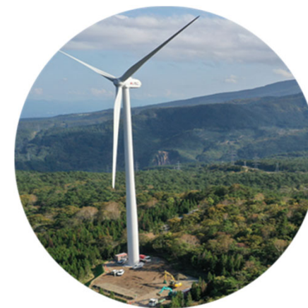
いちご米沢板谷ECO発電所
