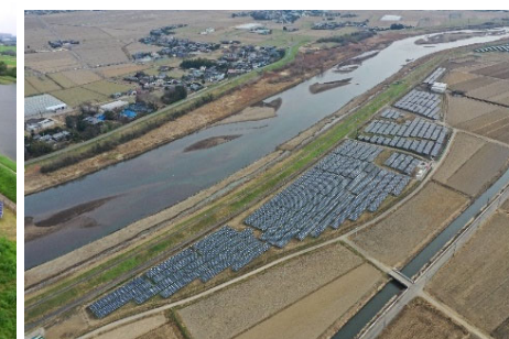
いちご取手下高井西ECO発電所
