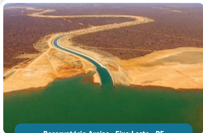
Reservatório Areias - Eixo Leste - PE
