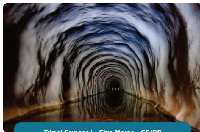
Túnel Cuncas I - Eixo Norte - CE/PB
