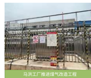
马洪工厂推进煤气改造工程
