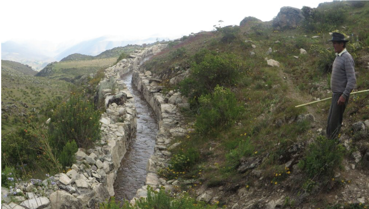
Fotografía 1: Canal de mamanteo restaurada en la comunidad, se cree que el canal 'siembra' agua durante la estación lluviosa para suministrarla durante la estación seca. Foto: Leah Bremer
