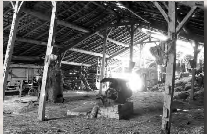
24. Le versement des fermes est visible.
