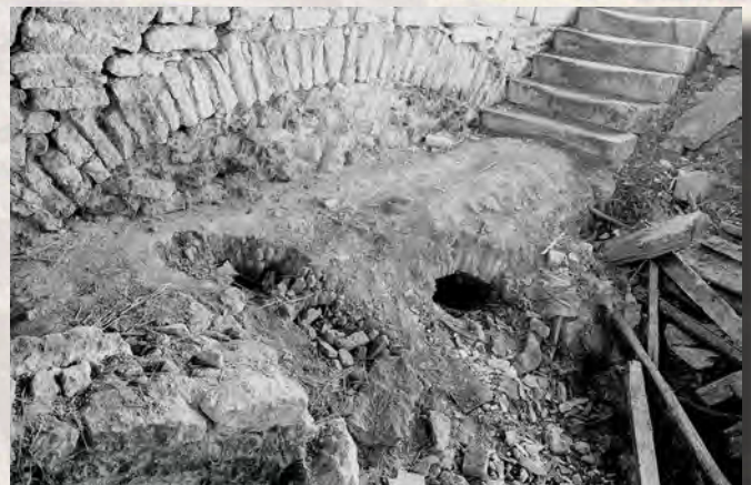
13. Ruptures de la voûte du four.
