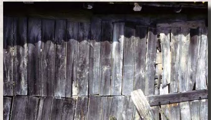
18. Le voligeage a suivi le mouvement général du bâtiment.
