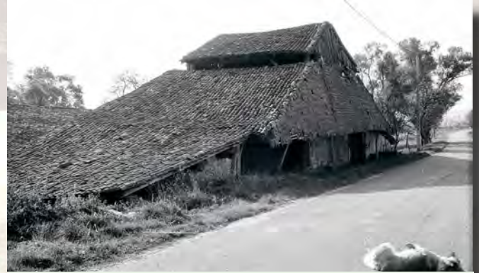
3. Le four, accessible de la route, avec sa croupe formant auvent, prolongée par deux grandes ailes.
