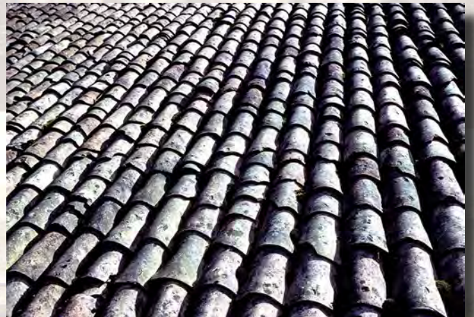
8. Les pureaux (partie de la tuile non recouverte), sont d'environ les deux tiers de la tuile.
