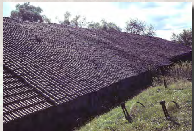
15. Un séchoir d'une grande longueur, encore couvert de tuiles creuses.
