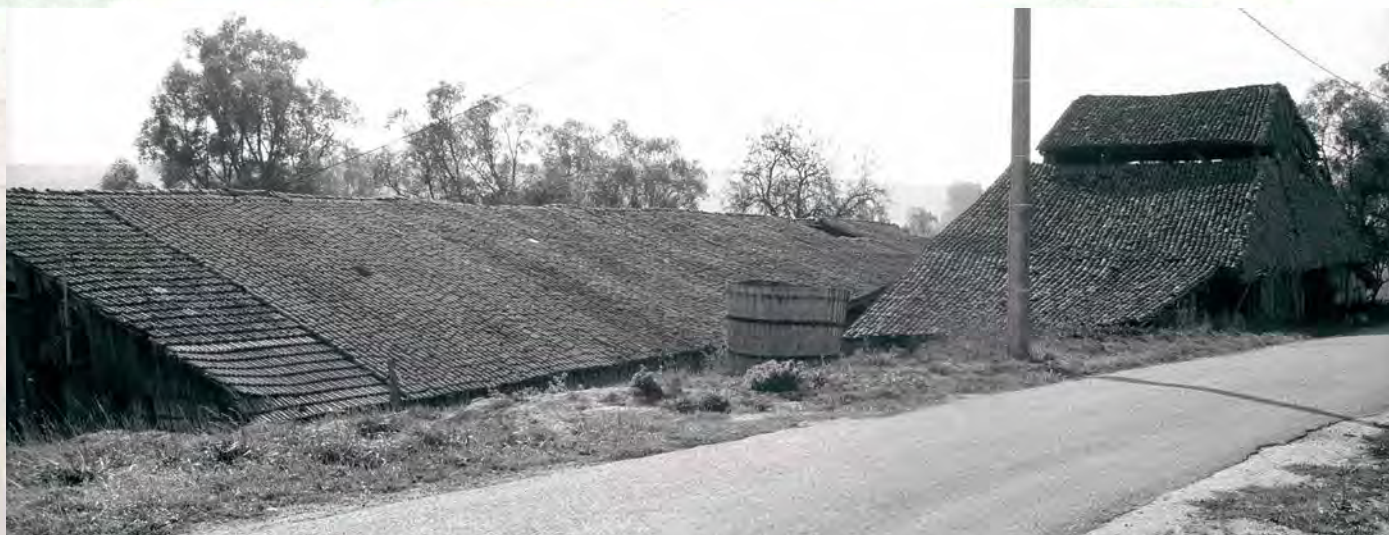
1. La tuilerie dans son ensemble, séchoir et four, en contrebas de la route de Trondes.
