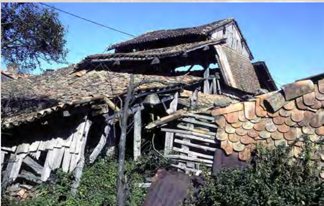
5. Le four, vu par l'arrière, du côté du séchoir. On aperçoit, sur la gauche, une petite partie de la toiture de la maison de tuilier, située de l'autre côté de la route.
