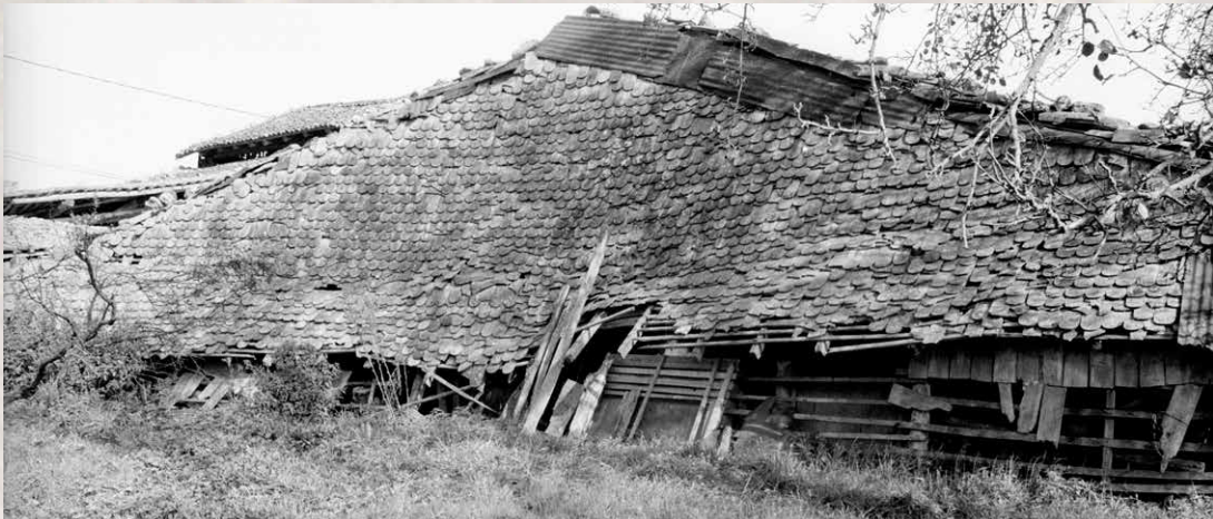
9. La croupe arrière du séchoir, couverte de tuiles plates écailles, fortement délabrée.
