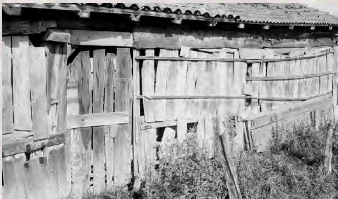
17. L'intérêt de ces planches disjointes était de contribuer à la ventilation du bâtiment.
