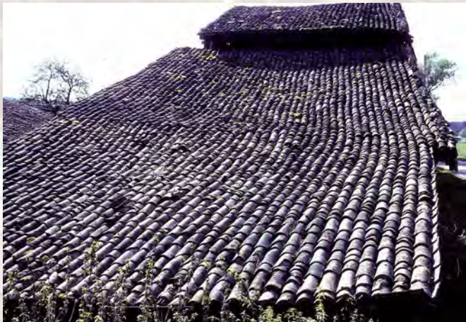
7. Des tuiles faites « maison » ; on observera, à droite, qu'en Lorraine, les rives sont constituées de tuiles de coulant.
