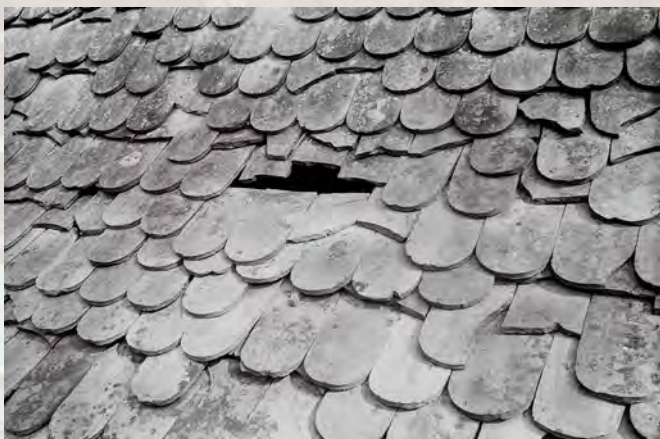
10. Désordres dus au cisaillement de certaines tuiles.
