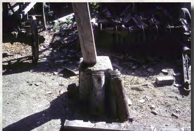
26. Les poteaux reposent chacun sur un dé de pierre achevé en borne.
