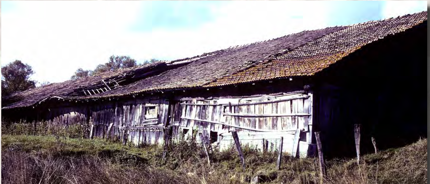
16. Le clos vertical des façades, s'il est possible de les nommer ainsi, est assuré par un simple voligeage.
