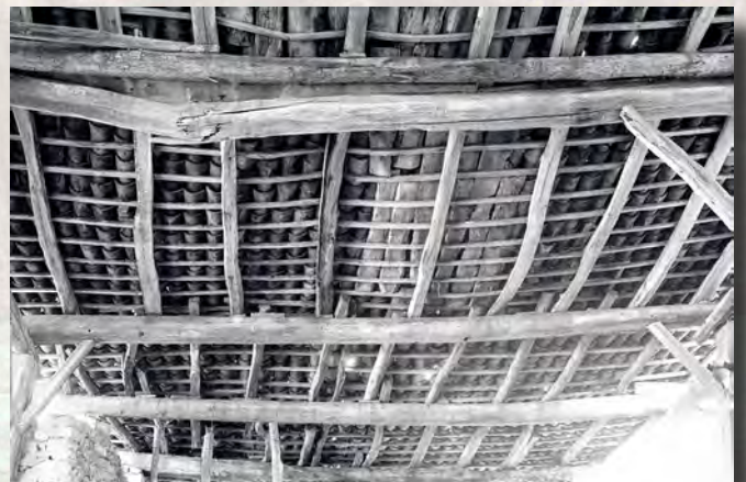
11. Une rupture de panne, sur le haut, certains chevrons ont légèrement fléchi ; un simple lattis ne pouvait assurer une bonne stabilité des tuiles.
