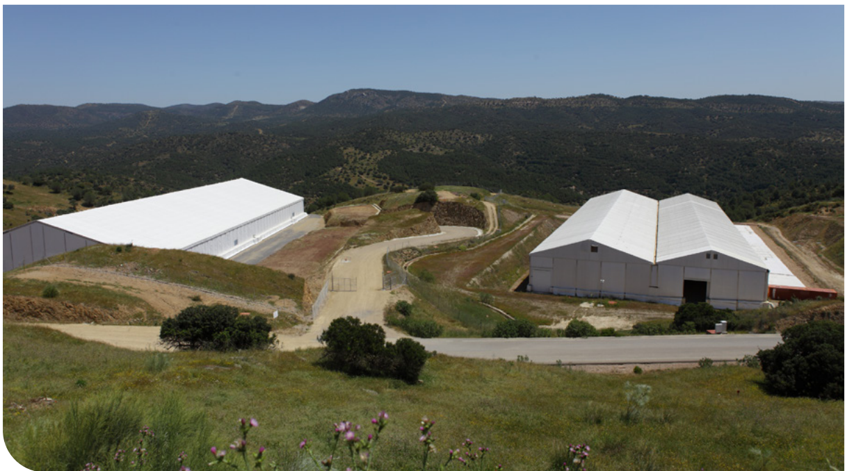
Figura 12. Instalación complementaria para el almacenamiento de RBBA
