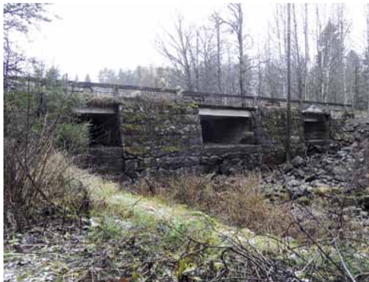
Arrakosken luonnonuoman yläpää on suljettu padolla, jonka yläpuolelta virtaama ohjataan maanalaisella putkella voimalaitokseen.
