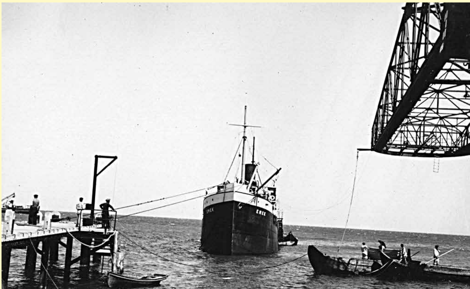
Abb. 206 Fallweise können die Frachter sogar am Landungssteg anlegen, dennoch muss die Beladung mit Hilfe des Krans und der Leichter erfolgen. Nur selten lässt sich der Name der Schiffe auf den Bildern entziffern, hier ist es möglich: „EMEK“. Weitere Informationen liegen aber nicht vor.
