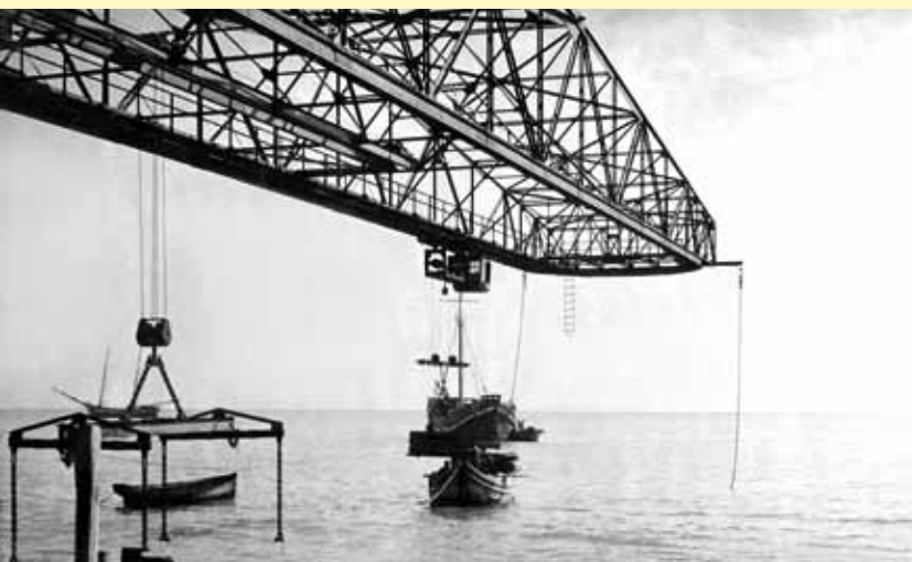
Abb. 196 Die Einschienenkatzen dienen zur Verladung kleinerer Lasten, das große Ladeschirr kann dagegen bis 10 t tragen. Mit dessen Hilfe werden auch die Motorboote und Leichter zu Wasser gelassen.
