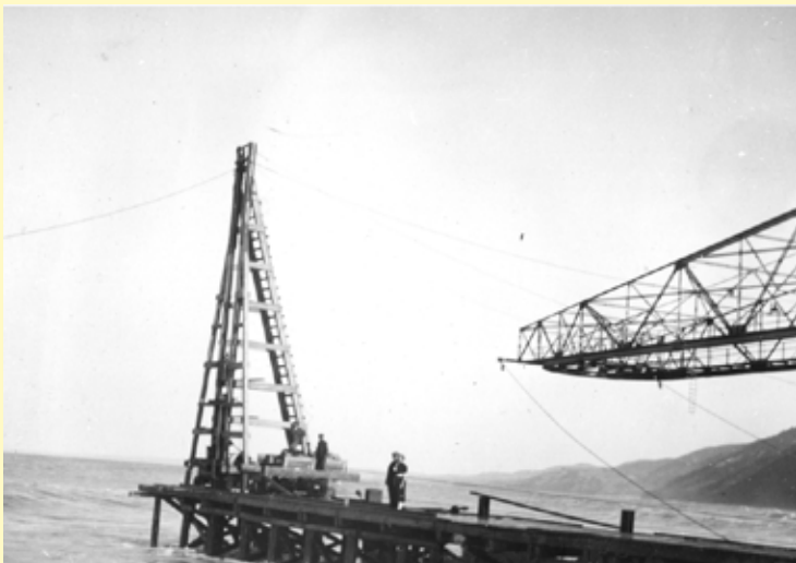
Abb. 199 Zur Ausbesserung des Bootsstegs kam fallweise eine Ramme zum Einsatz.
