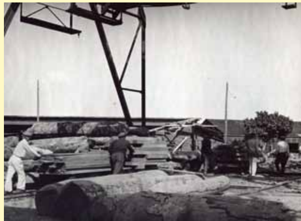
Abb. 194 Der Verschub der Bretter und anderen Waren erfolgte auf Rollwagen auch per Hand.
