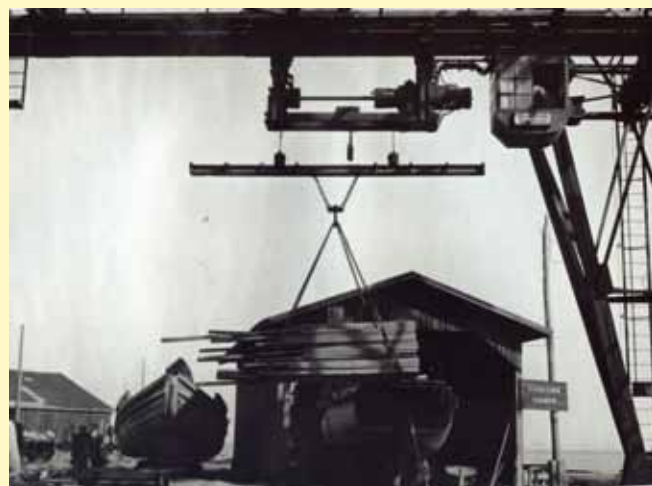
Abb. 197 Die Bootshalle neben dem Kran. Hier sind die Boote während Unwettern geschützt abgestellt und fallweise repariert werden.
