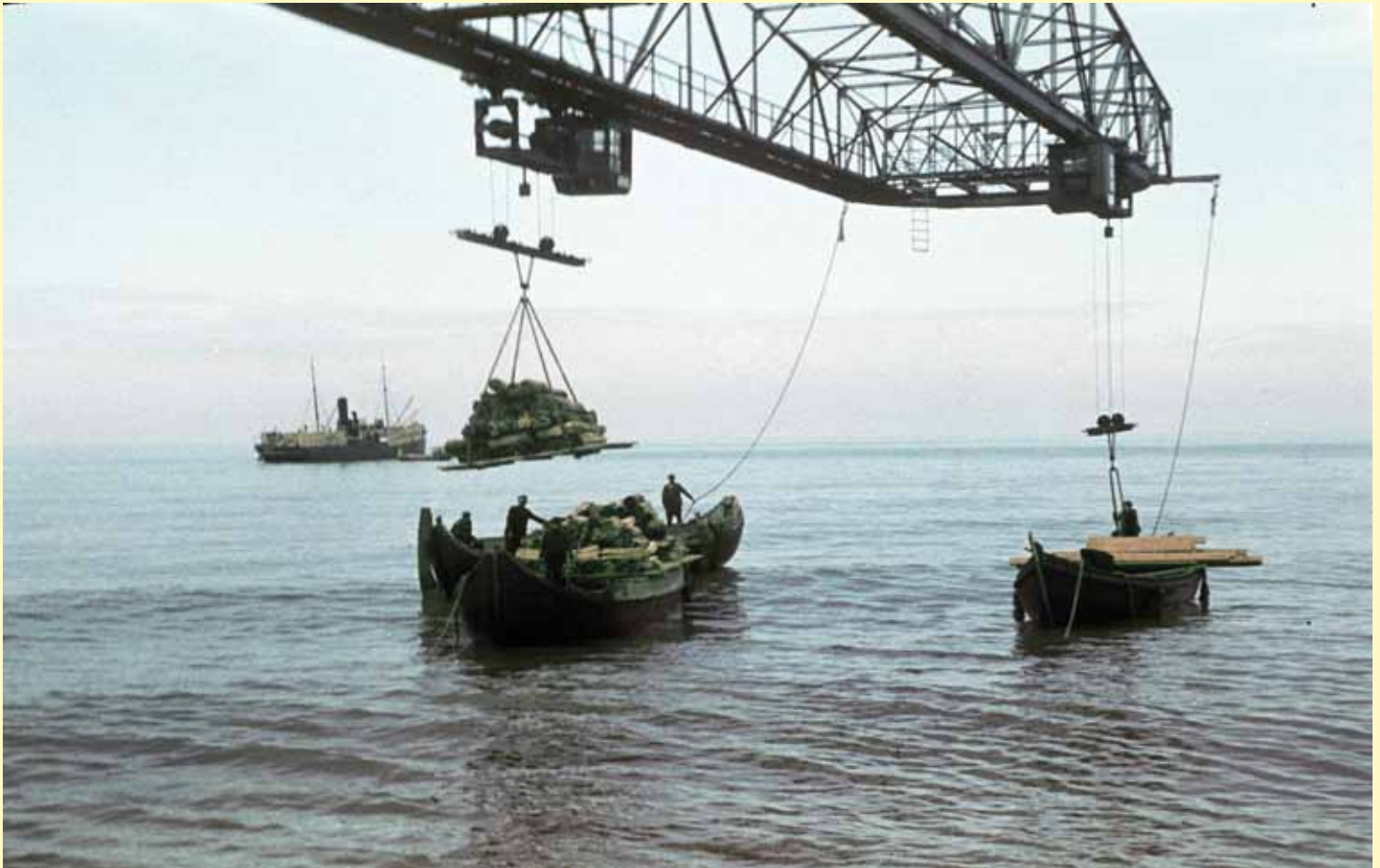
Abb. 201 Unter dem Ladekran müssen die Leichter in Position gebracht werden, damit die Ladung schnell und effektiv verstaut werden kann. Es sind zwei Einschienenkatzen vorhanden, mit deren Hilfe mehrere Leichter gleichzeitig beladen werden können.
