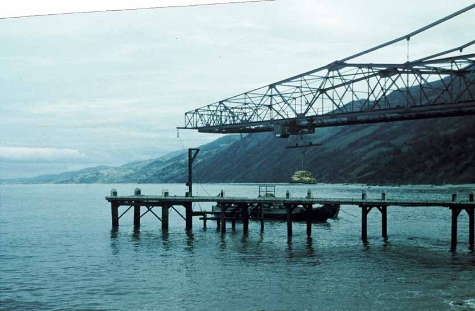
Abb. 198 Neben dem Kran ist ein Landungssteg angelegt, damit die zu Wasser gelassenen Boote auch trockenen Fußes erreicht werden können.
