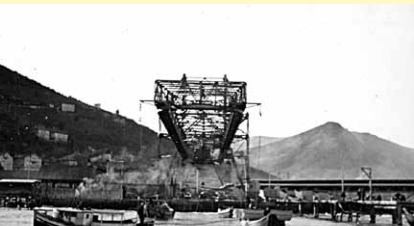
Abb. 193 Der Ladekran vom Meer aus gesehen. Die massive Fahrbahn der Hubkatzen ist vor dem filigranen Krangerüst gut zu erkennen. Wie das Bild beweist, erforderte die Verladung größerer Frachtmengen eine große Zahl an Leichtern.
