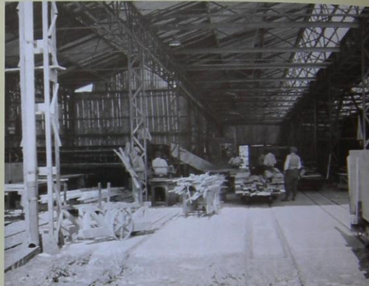
Abb. 152 Am Endabwurf des Quertransporteurs wird Verschnitt zur Weiterverarbeitung zu Latten oder in der Kistenfabrik 20 gesammelt.
