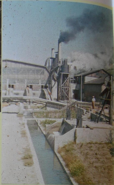
Abb. 143 -145 Zur Weiterverarbeitung werden die Blöche in das Kanalsystem 11 gerollt, mit dem Wasserstrom zum Klotzteich 12 transportiert und von dort per Kettentransporteur 13 in die Sägehalle geholt. Ein Kettentransporteur versorgt jeweils zwei Sägegatter.
