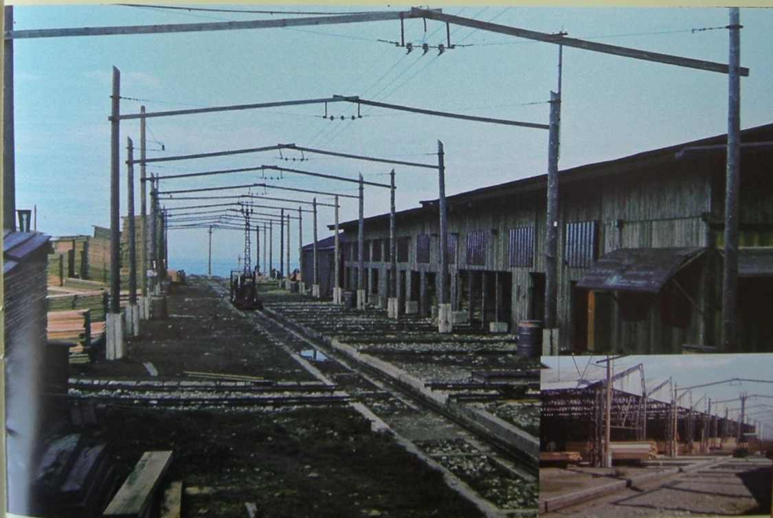
Abb. 154 - 155 Die elektrische Schiebepöhlne 16 dient zur Verteilung der Sortierwagen auf den Holzlagerplatz und zu den weiterverarbeitenden Werken.
