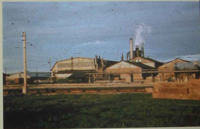
Abb. 140 Die Kettentransporture 6, der Holzlagerplatz 7 und die Weichholz-Sägehalle 14 von Süden aus gesehen.
