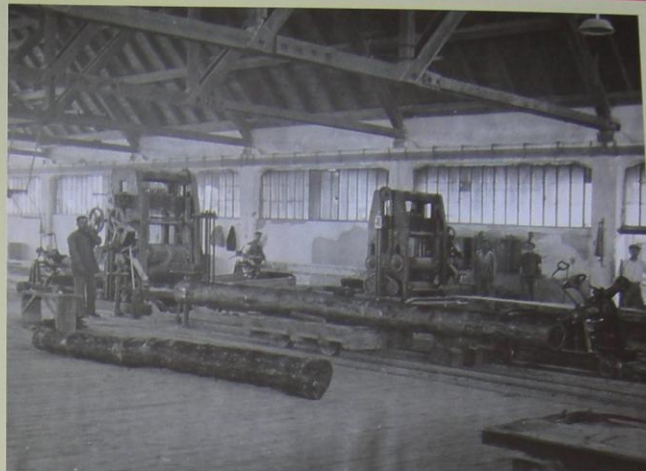
Abb. 146 Übersicht über die Sägehalle 14 mit den Gattersägen von 950 mm, 800 mm und 650 mm Arbeitsbreite.
