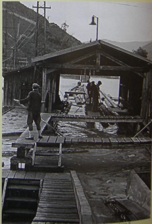
Abb. 136-138 Der Arbeitsgang in der Klotzstützanlage 5
