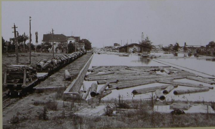
Abb. 134 Auf Gleis 2a steht ein Holzzug zur Entladung in Wasserbecken 3a bereit. Man beachte den am Zugende eingestellten Flachwagen mit kurzen Stempeln, die wohl als Brennholz Verwendung finden werden. Das Gebäude im Wasserbecken beherbergt die Klotzstutzanlage.
