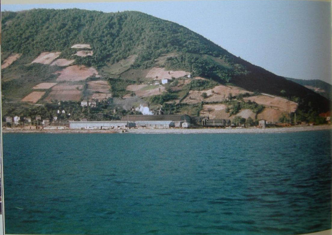
Abb. 132 Übersicht über die Anlage des Sägewerks von Ayancik vom Schwarzen Meer aus. Von rechts nach links sind am Rand gerade noch das Verwaltungsgebäude, der Endmast der Seilbahn sowie Werkstatt und Magazin zu erkennen. Das Zentrum wird von der Sägehalle und der davor liegenden Kistenfabrik eingenommen. Am linken Rand schließt sich der Holzlagerplatz an.
