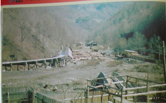
Abb. 84 Die Erbstation weist auch eine bescheidene Infrastruktur auf. Im Hintergrund ein Schuppen der Waldbahn, rechts ein Betriebsgebäude. Der Ort Sarayok selbst befindet sich aus Flutschutzgründen weiter oben am Hang, die Nachsilbe -ok bedeutet 'unten', somit ließe sich die Waldbahnstation auf Deutsch als 'Niedersarayok' benennen.
