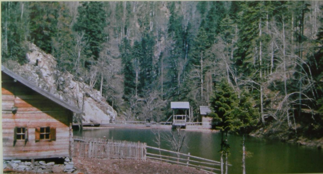
Abb. 75 Die Wasserriese nach Zindan/Saraycikalti benötigte zu ihrer Speisung zwei Staubecken, dieses große Rückhaltebecken und ein kleineres etwas weiter stromauf. Ob das Haus auch von den Waldarbeitern oder ausschließlich von Führungskräften genutzt wurde, bleibt fraglich.
