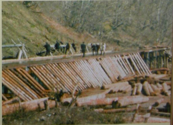
Abb. 83 Die Entladeanlage in Saraycikalti. Die Männer am Ausländerbcken bedienen Winden (Zapinen) zum Herausheben der Blöcke aus der Wasserriese [1].
