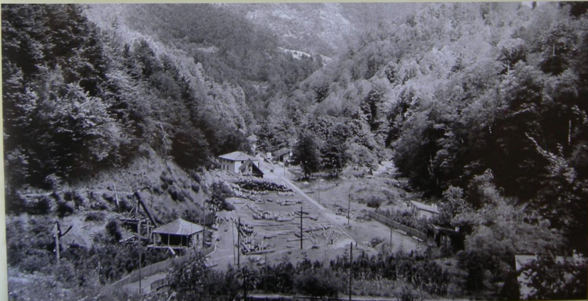
Abb. 87 Zindan/Saraycikalt Ende der vierziger Jahre. Einige neue Gebäude sind hinzugekommen; die Wasserriese dagegen ist verschwunden und wurde durch einen Streifweg ersetzt. Das kleine quadratische Gebäude im Vordergrund ist das Elektrizitätswerk und beherbergt den mit Wasserkraft angetriebenen Generator. Das Wasser selbst wird über die aufgeständerte Leitung herangeführt.
