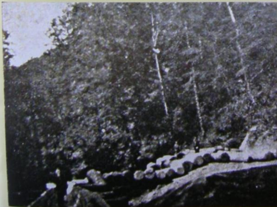
Abb. 82 Der Eintrag der Baumstämme in die Riese erfolgte mit einfachsten Mitteln; die Verladestellen im Inalti- und Kepeztal waren ähnlich aufgebaut. Vor Arbeitsaufnahme wurden die Wasserriesen genauestens auf Unebenheiten und Lecks geprüft.
