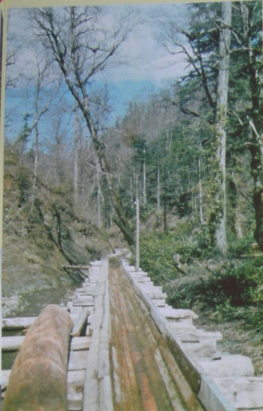
Abb. 77 Wasserriese im leeren Zustand. Gut ist der Aufbau aus geklinkerten Holzprofilen zu erkennen.
