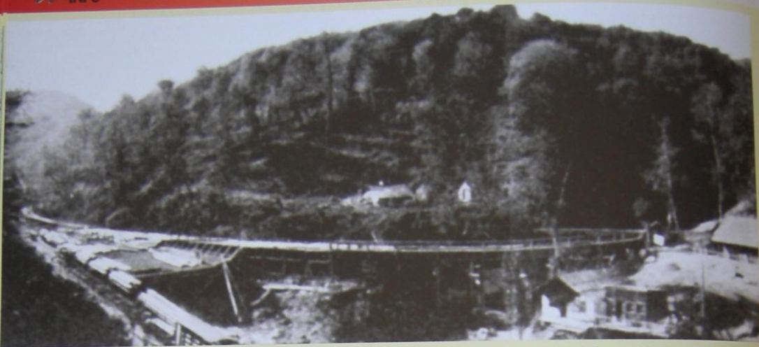
Abb. 90 Übersicht über den Umschlagplatz an der Endstation von Inalti. Links: Wasserriese, rechts Trockenriese mit Einsprung der Bloche in die Klaus.
