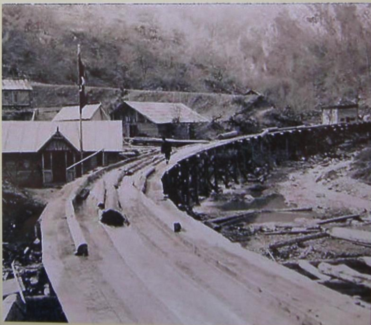
Abb. 89 Streifriese; auch hier werden zur Kraftersparnis Höhenunterschiede mit Einschnitten und Brücken ausgeglichen.
