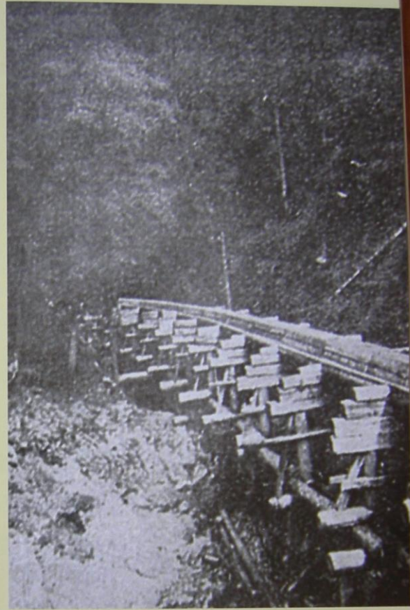
Abb. 81 Bei steileren Hängen wurden durchaus auch aufwendige Kunstbauwerke errichtet, um ein gleichmäßiges Gefälle zu gewährleisten.
