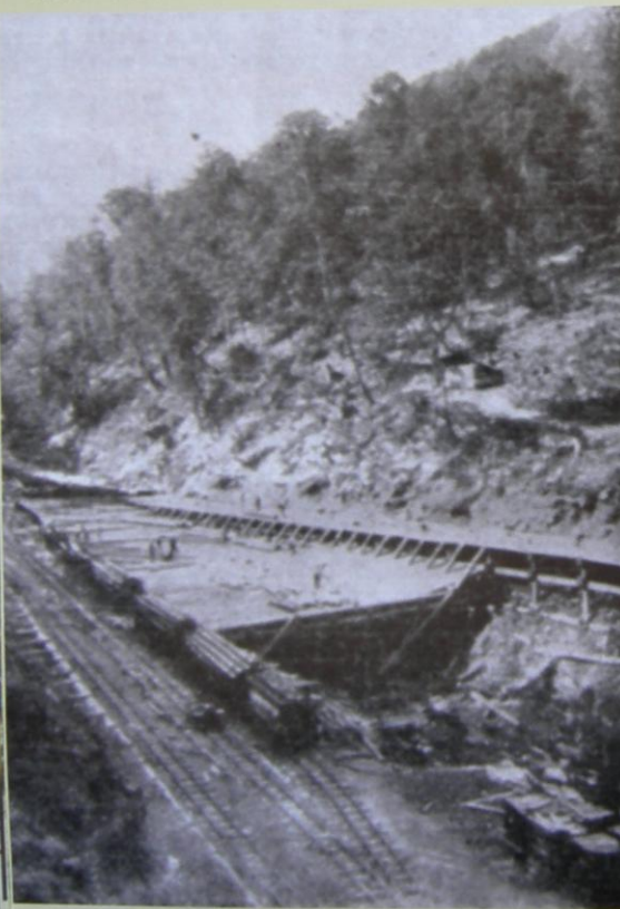
Abb. 91 Wasserbecken am Ende der Wasserriese in Inalti bei Ayancik. Links Ladestelle der Waldbahn. Länge des Wasserbeckens etwa 80 m. Von dort werden die Bloche auf die Rampe abgerollt.
