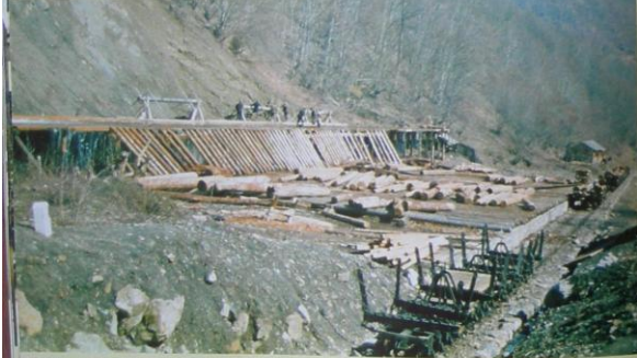
Abb. 85 Ende der Wasserriese von Babacay mit Auslässebecken, Abrülllager und Waldbahndestation Zindan/Sarayokan. Im Vordergrund sind Trucks von Fernstaal von 3 t Gewicht pro Paar und einer Tragkraft von 10 t zu erkennen. [2]
