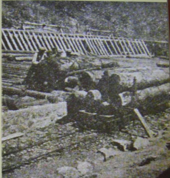
Abb. 86 Holzverladung auf Waldbahntrucks in Zindan. Im Hintergrund ist die Wasserriese zu erkennen.
