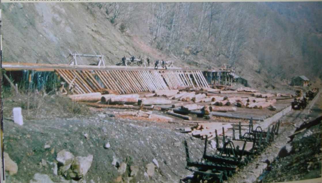
Abb. 85 Ende der Wasserriese von Babacay mit Ausländebecken, Abrolllager und Waldbahnenstation Zindan/Saraycikalti. Im Vordergrund sind Trucks von Ferrostal von 3 t Gewicht pro Paar und einer Tragkraft von 10 t zu erkennen. [2]
