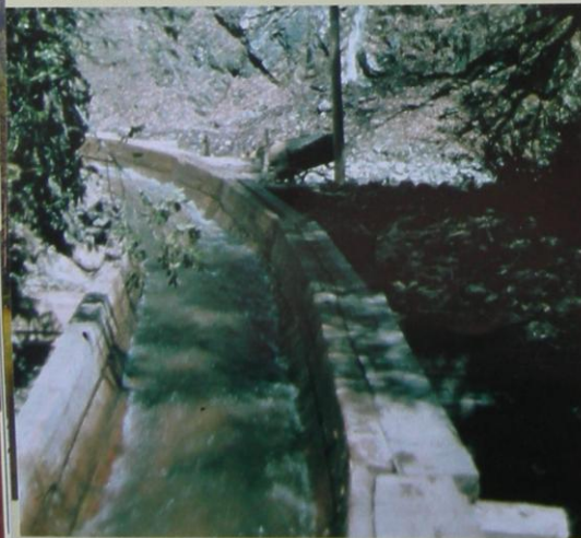
Abb. 79 Die Wasserriesen folgen möglichst dem Geländeprofil
