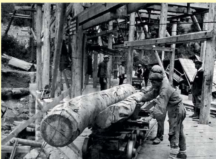
Abb. 28 Zur einfacheren Holzverladung stehen einige Trucks zur Verfügung; mit Muskelkraft werden die Stämme unter die Seilbahn verschoben.
