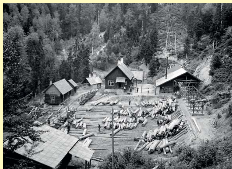
Abb. 30 Die Endstation der Pohligh-Seilbahn in Karadere ist erreicht. Gut ist die gesamte Anlage mit Holzentladung per Schwerkraft (rechts) und Bahnverladung (links) zu erkennen.
