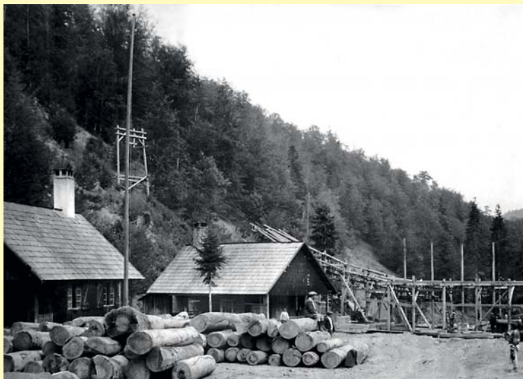
Abb. 26 Der linke Anschluß zu Abbildung 17 im ersten Teil zeigt den Beginn der Pohligh-Seilbahn mit der Verladestation in Yernişli.
