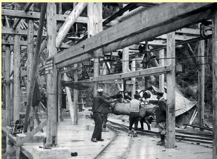
Abb. 29 Die Baumstämme hängen im Tragegeschirr. Betrachtet man Abb. 26-29 genauer, so fällt das unregelmäßige Geländeprofil ins Auge.
