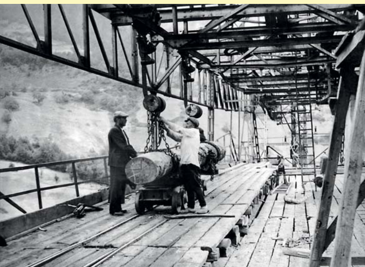
Abb. 46 Eine Aufnahme aus der Frühzeit des Betriebs: Ein Baumstamm wird für die Verladung auf die Seilbahn vorbereitet. Während die Gehänge befestigt werden, ruht er noch auf den Waldbahntrucks.
