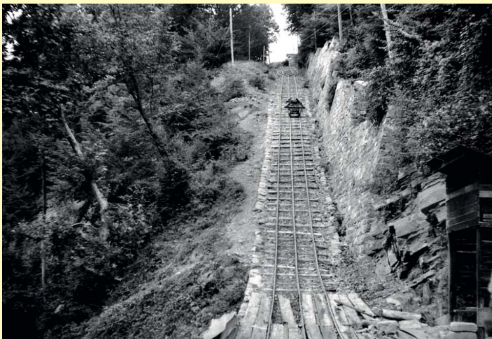
Abb. 49 Bremsberg, Ansicht von unten. Nachdem in der Anfangszeit hier Baumstämme zum Abtransport mit der Seilbahn hinauf transportiert wurden, erfolgte ab 1953 die Verladung von der oben liegenden Seilbahn hinunter zur Waldbahn.
