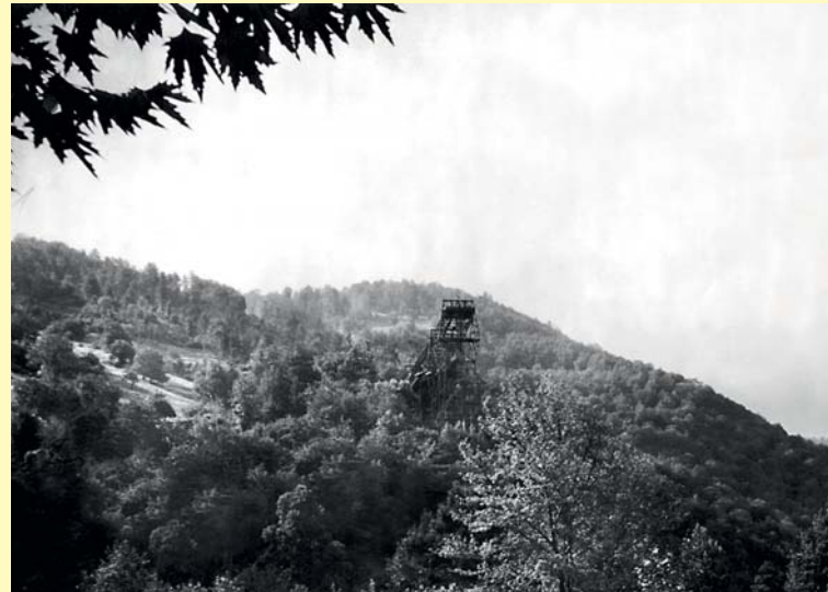
Abb. 44 Die Stahlkonstruktion der Winkelstation in Yenice ragt hoch über die Ebene auf.
