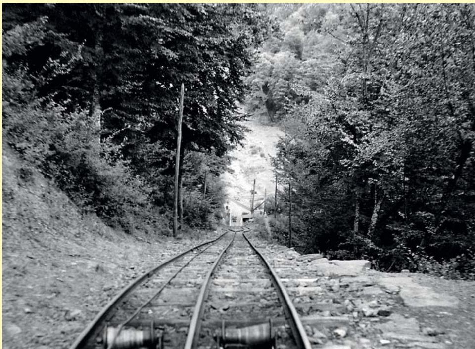
Abb. 48 Der Bremsberg in Yenice, Ansicht von oben. Gut sind die dreischienige Ausführung der Strecke und die vierschienige Ausweichstelle zu erkennen.
