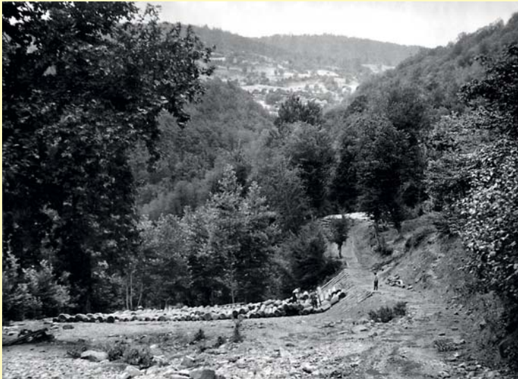
Abb. 34 Eine Ladestelle am Ende eines Streifweges. Es ist genügend Platz vorhanden, um eine große Anzahl von Stämmen bis zum Weitertransport zwischenzulagern. Die Verladung auf die Schmalspur wird durch das abfallende Geländeprofil erleichtert.
