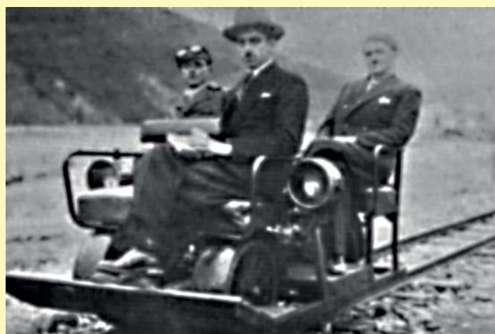
Abb. 23 Die Motordraisine kam auch für Streckenbereisungen der Bahnführung zum Einsatz.
