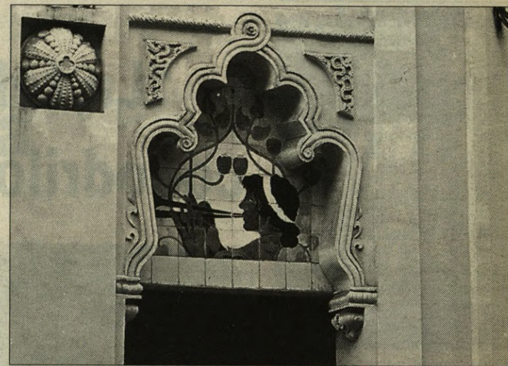
Detalle de fachada
