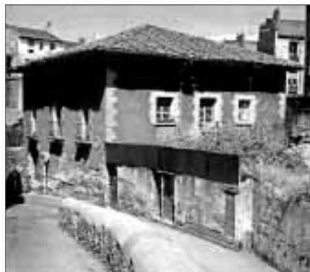
Estado actual del edificio donde estuvo ubicado El Amparo
