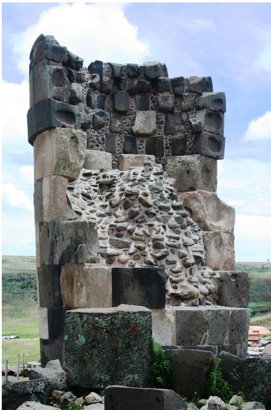
*Figura 4 Secção transversal de uma chullpa*
