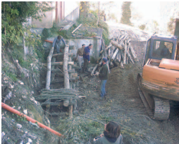
Foto 4: Palificata viva doppia in corso d'opera, novembre 2003. Foto di A. Cortese
