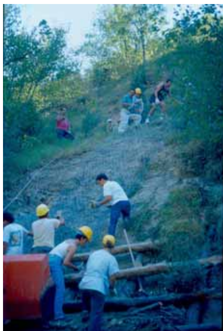
Foto 9: SP Tarugo luglio 2001 realizzazione rivestimento vegetativo - P. Giacchini
