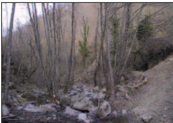
Foto 23.23: Corso d'acqua dopo l'intervento.
