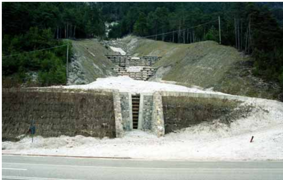
Rivestimento vegetativo versanti in rete metallica e biostuoia Valbruna (UD), 2004
