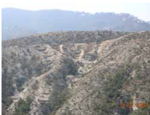
Foto 2: Lo stesso tratto di versante (Tosse, Spotorno) ad ultimazione dei lavori di consolidamento con serie di palificate in legname a doppia parete marzo 2004 - U.Bruschini
