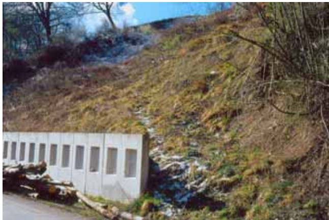
Foto 5: Strada provinciale Targo prima dei lavori, aprile 2003 - P.Giacchini
