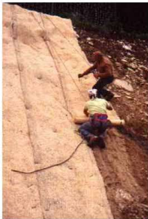
Messa in opera di biostuoia in trucioli di legno, Barcis (PN) Sauli
