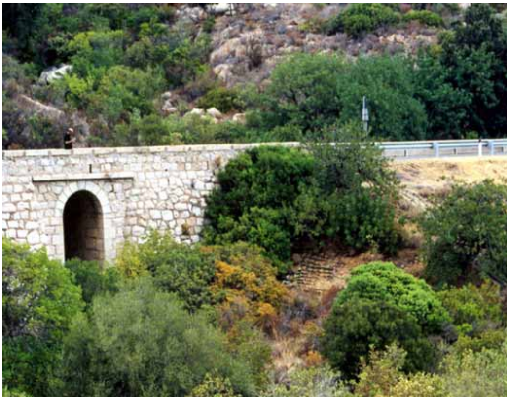
Geocelle a nido d'ape Strada per Flumendosa (CA), 2003
