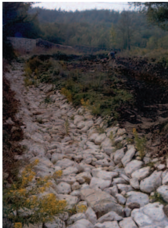
Foto 4: In opera del collettore in pietrame, ottobre 2003. Foto di A. D'Andrassi
