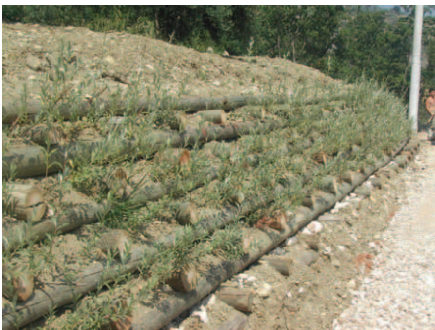
Foto 2: Palificata viva doppia in località Fontana del Pozzo, maggio 2003. Foto di C. Milanese
