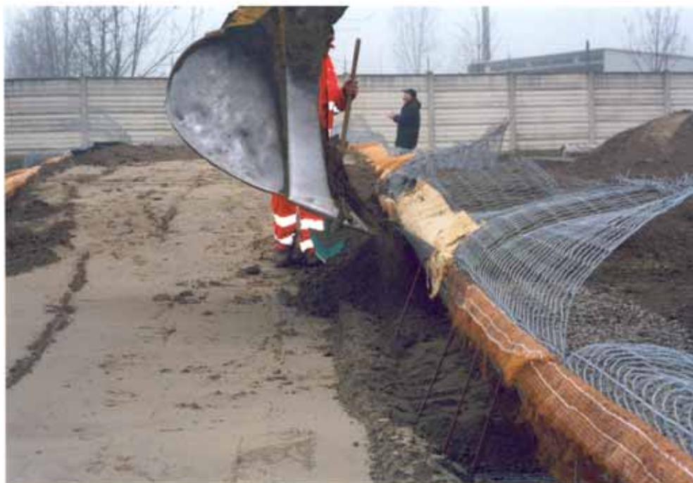
Terra rinforzata verde in fase di costruzione Pontecchio Marconi (BO), 2003
