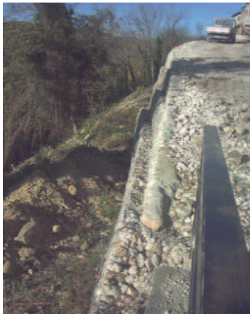
Foto 3: Gabbionata a sostegno della strada, novembre 2003. Foto di A. Cortese
