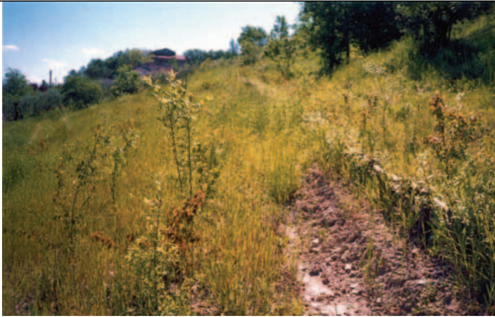
Foto 3: Palizzata viva realizzata con talee di Salix spp. e piante radicate a monte, maggio 2004. Foto di A. Cortese
