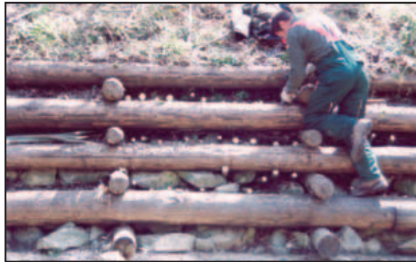
Foto 23.6: Particolare dell'inserimento delle talee
