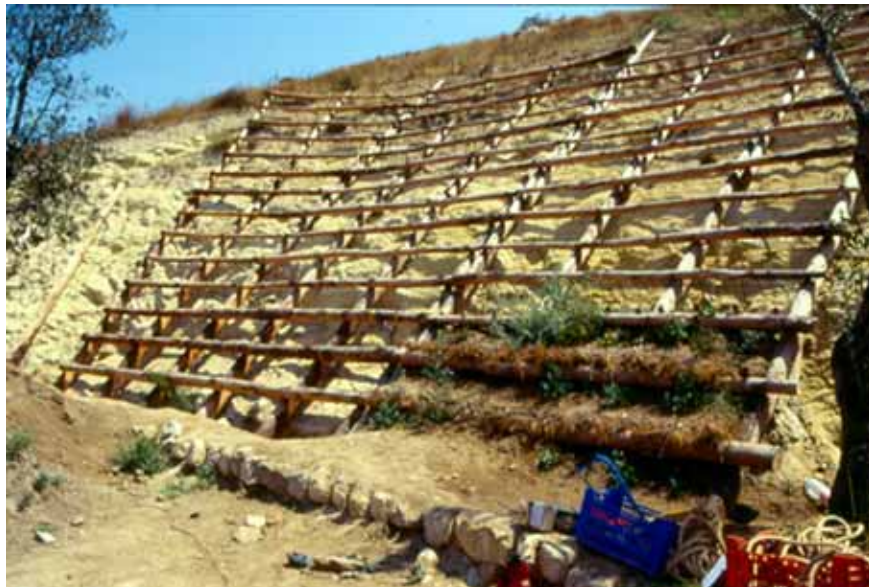
Grata viva in costruzione Colle S. Michele – Cagliari
