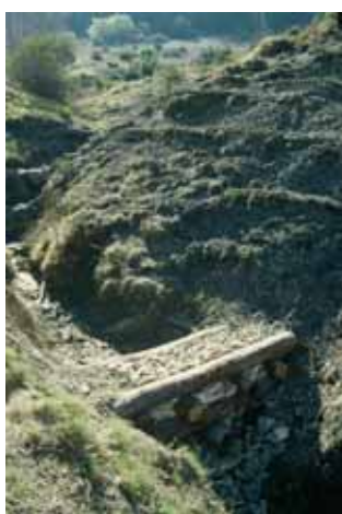
Foto 4 e 5: Opere trasversali sui fossi in erosione: sbarramenti in legno e pietrame: a fine lavori e dopo 4 anni – D. Dallari
