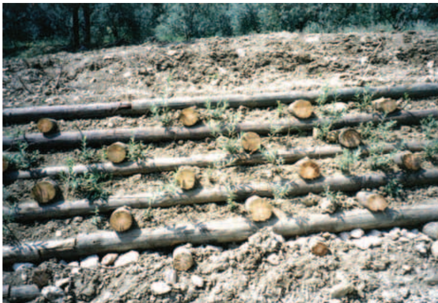
Foto 1: Vista frontale di una palificata viva doppia appena eseguita, maggio 2003. Foto di C. Milanese
