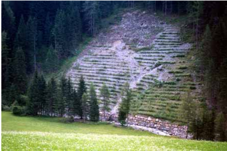
Stabilizzazione versante mediante formazione di cordonate vive Gisser , 2004
