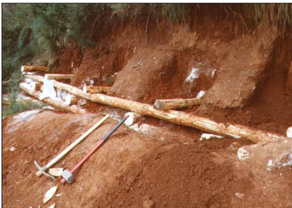
Foto 2: Posa in opera dei primi tronchi
