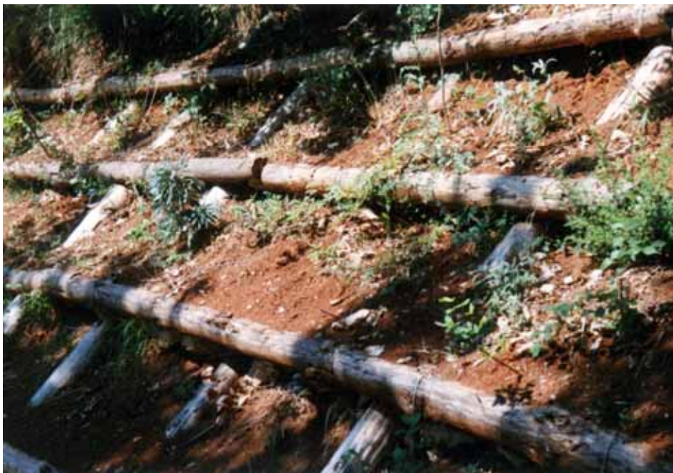
Foto 6: Riempimento con terreno vegetale
