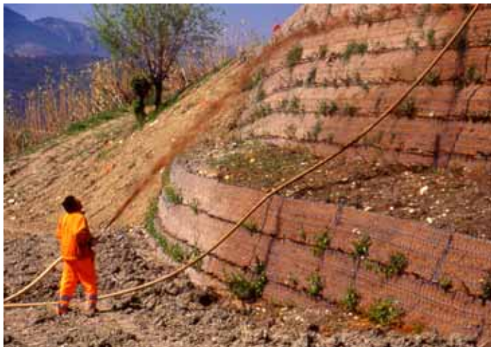
Idrosemina su terra rinforzata Atina (FR)
