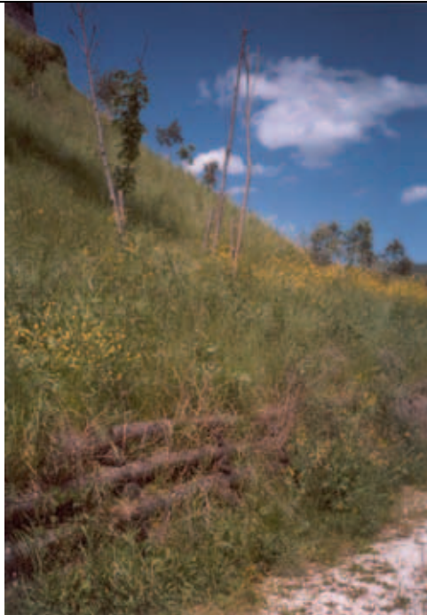
Foto 2: Palificata viva doppia con piantagione di specie arboree a monte della stessa, maggio 2004. Foto di A. D'Andrassi
