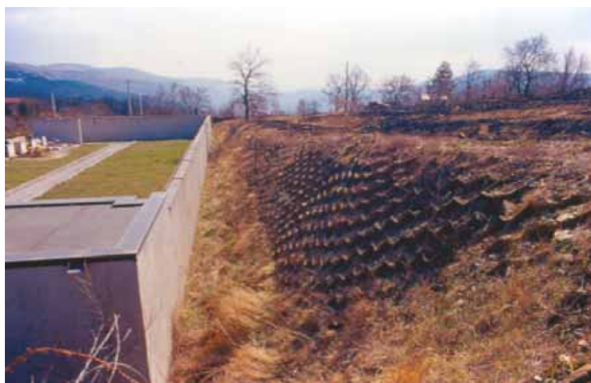
Geocelle a nido d'ape su rilevato Caresana (TS), 2003
