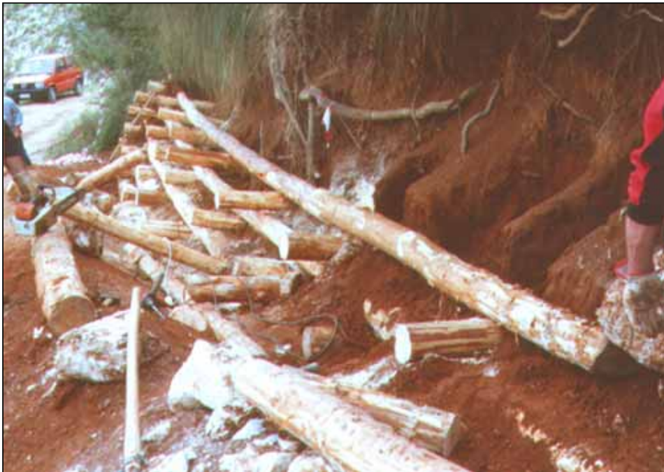
Foto 3: Fase intermedia di realizzazione
