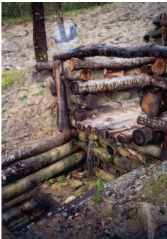
Foto 1: Canaletta in legname e pietrame, maggio 2004. Foto di A. Cortese
