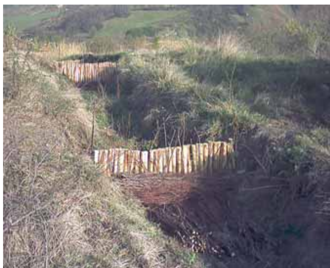
Foto 4: Palizzata per impluvi in erosione (aprile 2003) - Foto Archivi Dipartimento Territorio e Ambiente RSM
