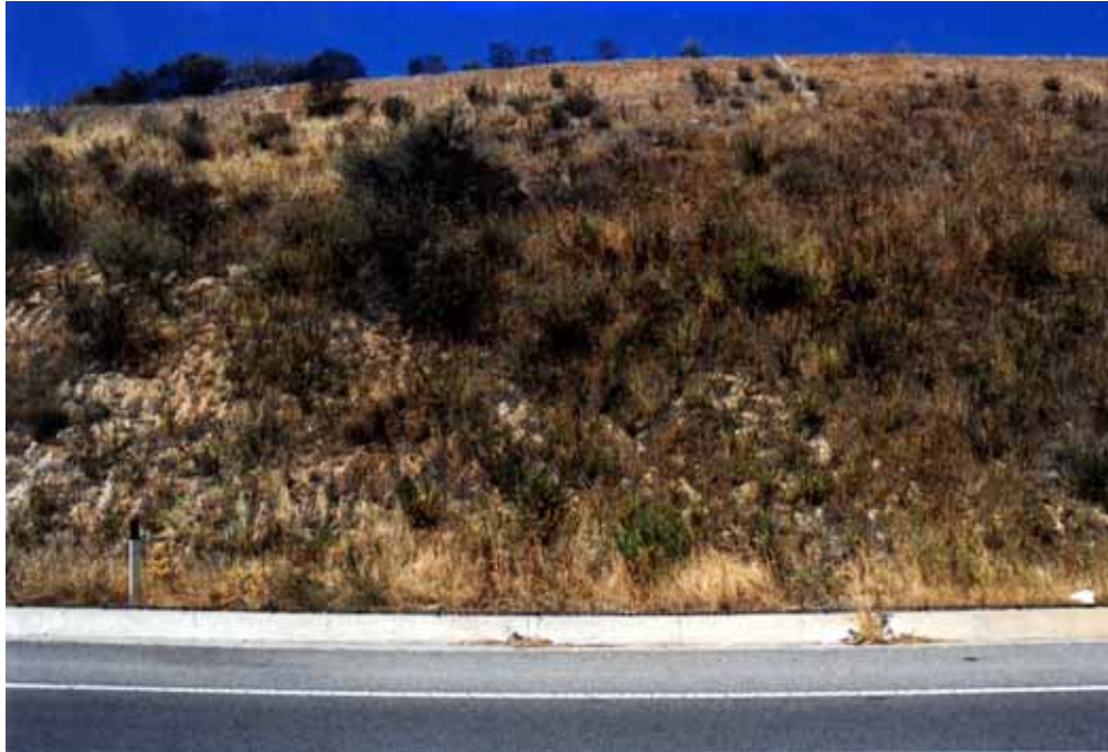
Rete metallica con funzione antierosiva Nuova SS195, Km per Pula (CA) - 2003
