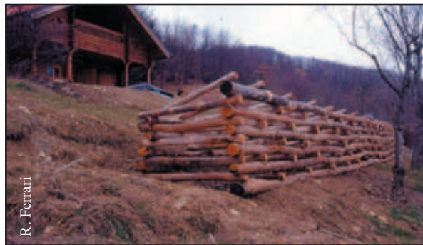
Foto 24.12: Mancato sincronismo costruttivo (palificata viva doppia): il successo dell'intervento è già compromesso
