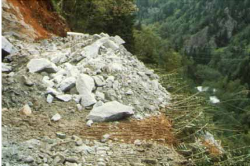
Cuneo filtrante in fase di realizzazione
