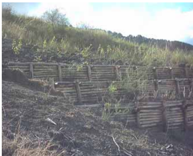
Foto 3: Briglia viva in legname impiegata per il consolidamento di una nicchia smottata (settembre 2003) - Foto Archivi Dipartimento Territorio e Ambiente RSM
