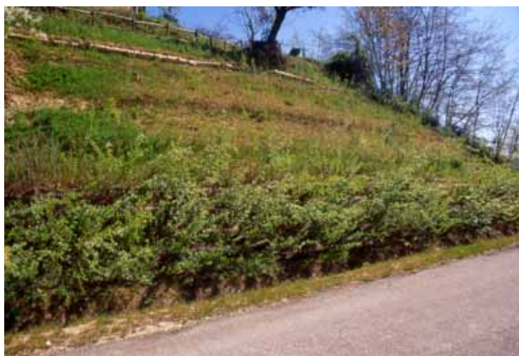
Palificata viva di versante dopo un anno dalla realizzazione Atina (FR), 2001
