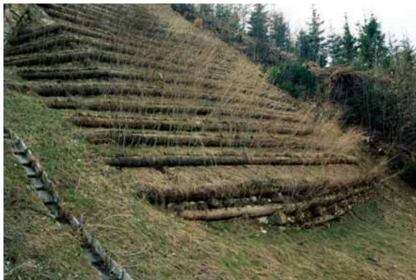
Grata viva su versante montano Loc. Ponte ad Arco – Tarvisio (UD), 2002
