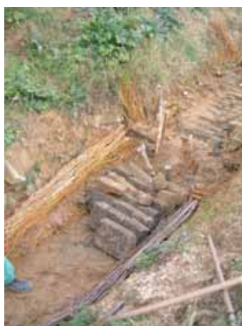
FOTO 16, 17: Protezione del compluvio principale con soglia in pietrame e legno con fascine vive e morte - D. Dallari
