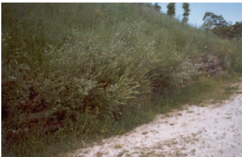
Foto 1: Palificata viva doppia ad un anno dalla realizzazione, maggio 2004. Foto di A. D'Andrassi
