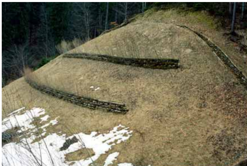
Palificate vive di versante Loc. Coccau (UD), 2004
