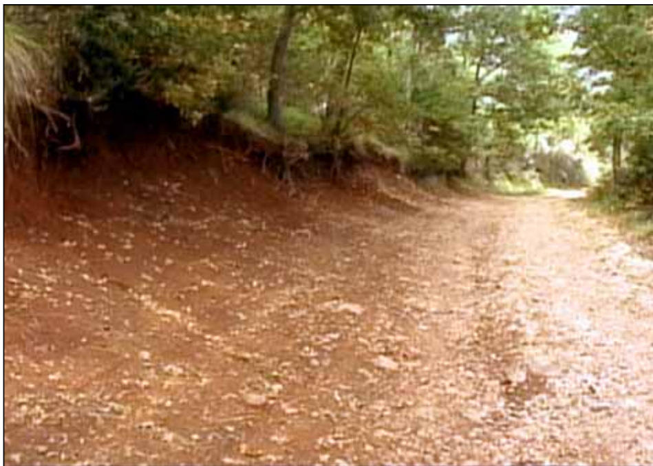
Foto 1: Stato dei luoghi ante operam
