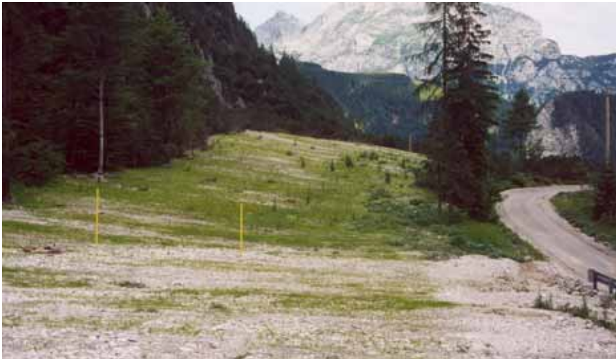
Idrosemina su ghiaie sterili su tracciato di metanodotto in zona montana Pontebba (UD), 2004
