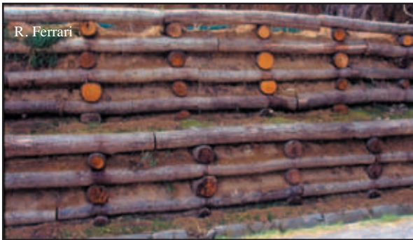
Foto 24.14: Inclinazione molto superiore agli standard della tipologia (palificata viva doppia) e totale mancanza della componente vegetale viva: un destino segnato
