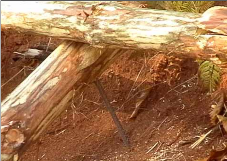
Foto 5: Dettaglio della chiodatura al terreno con barre di ferro ad aderenza migliorata
