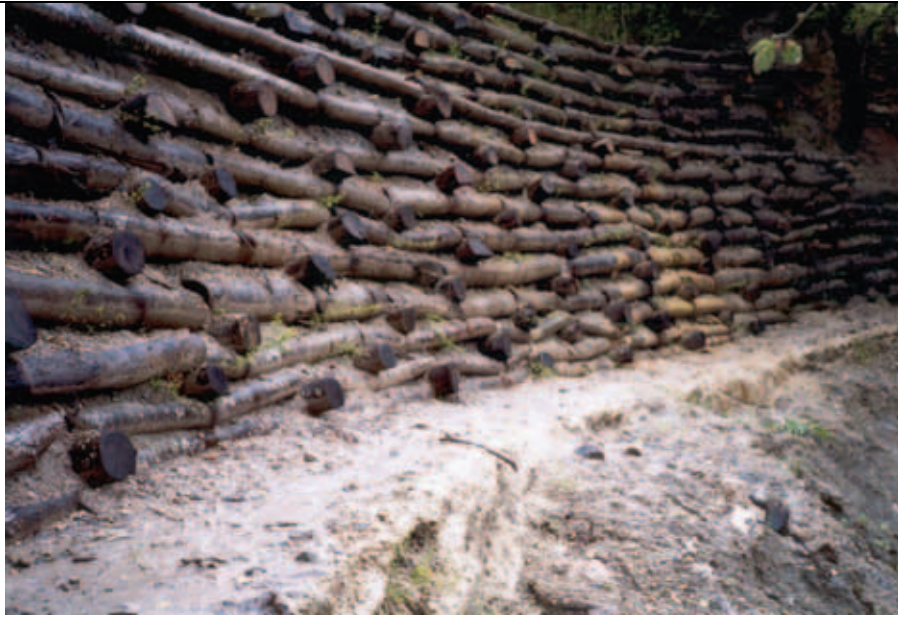
Foto 2: Palificata viva doppia, maggio 2004. Foto di A. Cortese
