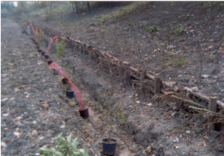
Foto 2: Palizzata viva con talee di Salix spp. E messa a dimora delle piante radicate a monte, ottobre 2003. Foto di A. D'Andrassi.
