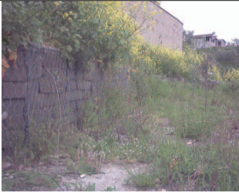
Foto 2: Piantagione sul fronte della gabbionata, aprile 2004. Foto di A. D'Andrassi.
