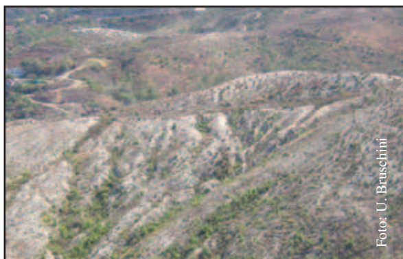
Foto 20.2: Versante soggetto ad erosione incanalata con formazione di calanchi, a 4 anni dall'evento - Loc. Tosse, bacino Rio Crovetto, Spotorno (SV)
