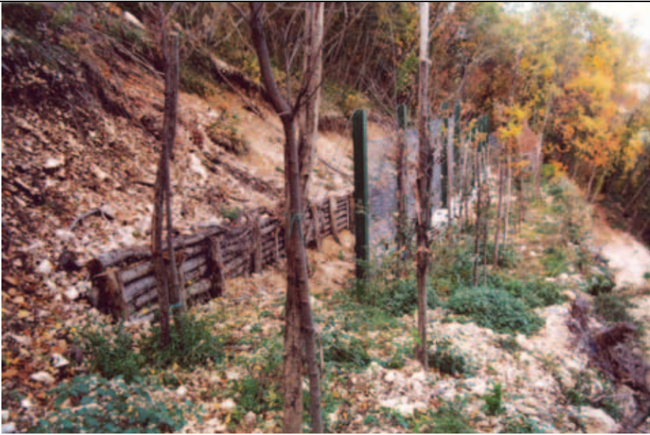
Foto 4: Piantagione a monte della palificata doppia, novembre 2003. Foto di A. Cortese
