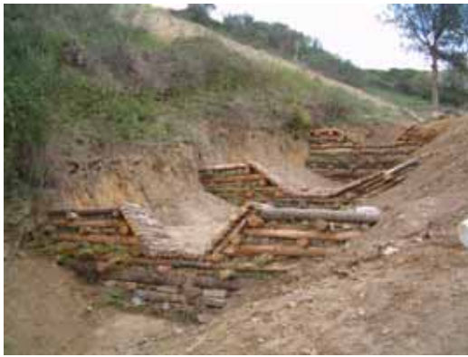
Foto 10, 11: Briglie in legno e pietrame, con inserimento di salici e piantine radicate subito dopo la realizzazione e dopo 8 mesi - D. Dallari
