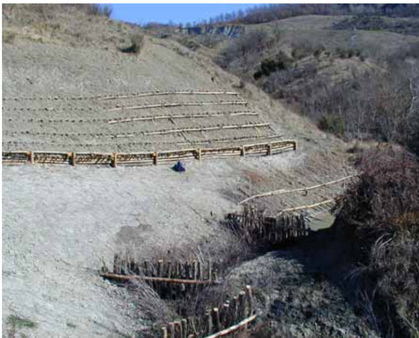
Foto 5: Grata, copertura diffusa e palizzate filtranti a lavori ultimati - Bernabei, Mazzoni, Pei
