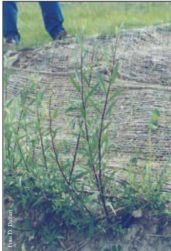
Foto 12.2.2: Talee di salice e piantine radicate inserite in sistemazioni a gradinata
