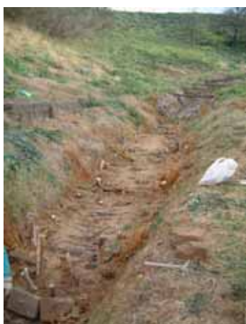
FOTO 16, 17: Protezione del compluvio principale con soglia in pietrame e legno con fascine vive e morte - D. Dallari
