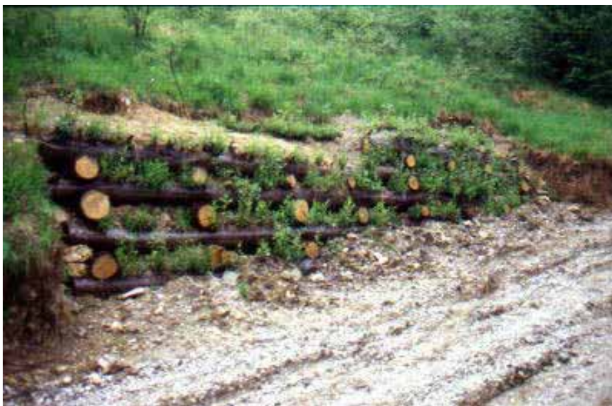
Palificata viva di sostegno Loc. Montenars (UD)
