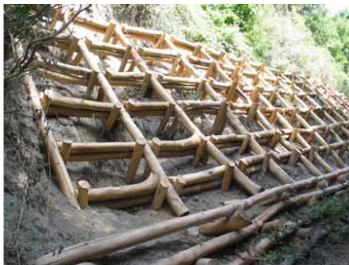
Foto 2: Palificata doppia con grata Vesuvio sec. Menegazzi con arbusti radicati; fase di costruzione (luglio 2003) - G. Menegazzi
