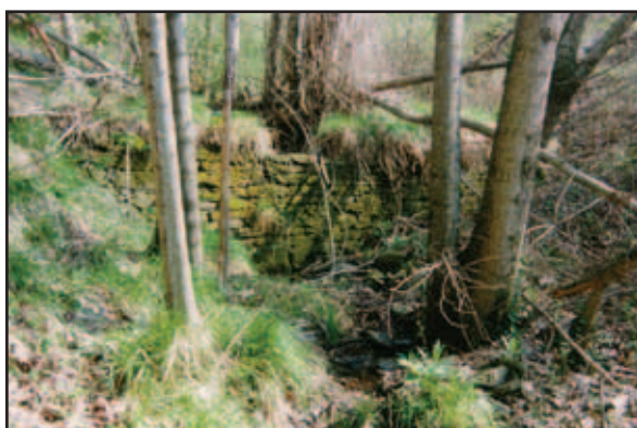
Foto 23.7 e 23.8: Presenza di vegetazione in alveo nelle vicinanze di opere idrauliche.
