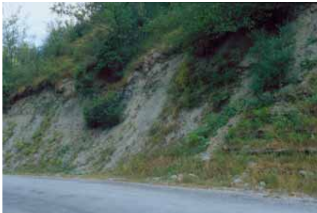
Foto 8: SP Tarugo prima dei lavori, luglio 2001 - P. Giacchini
