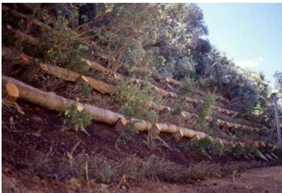
Grata viva doppia su scarpata post operam Punta Ala (GR)
