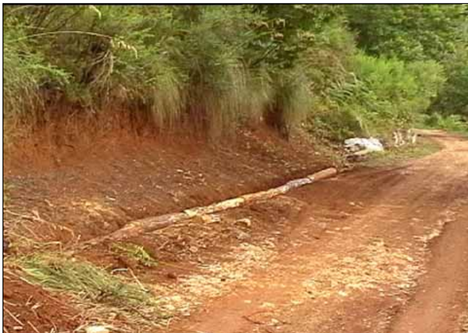
Foto 1: Inizio dei lavori (scavo della fondazione)
