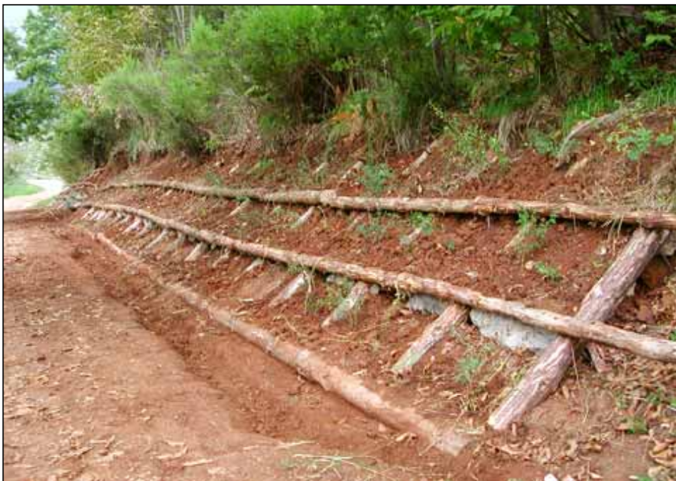
Foto 4: Vista prospettica dell'opera
