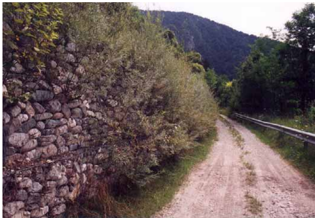
Gabbionata rinverditata Moggio Val Aupa (UD), 2002
