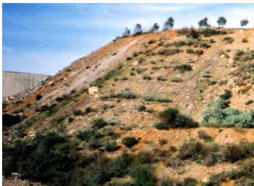
Stabilizzazione scarpate con gradonate vive di tamerici e arbusti di gariga mediterranea Campo Pisano (CA), 2003
