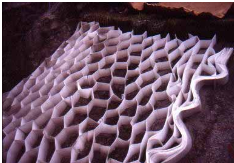
Stesura geocelle a nido d'ape
