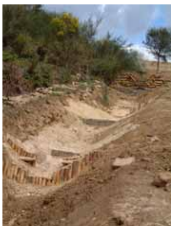
FOTO 18, 19: Opere trasversali quali briglie, soglie in gabbioni, palizzate doppie in legno realizzate per la protezione del compluvio principale nella zona a maggiore pendenza, alla fine degli interventi e dopo 8 mesi - D. Dallari
