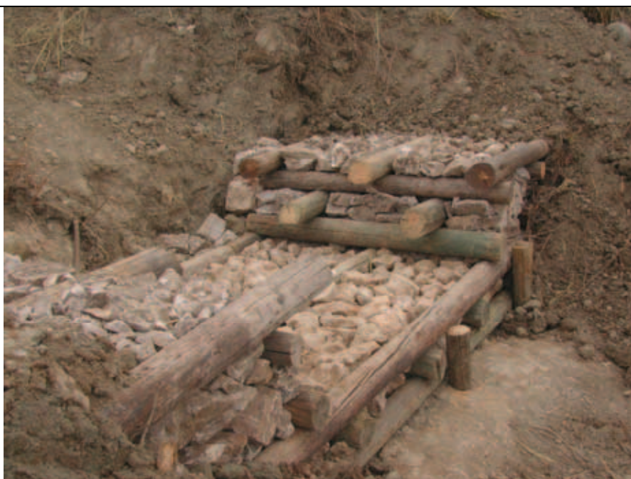
Foto 3: Briglia in legname e pietrame in località Aracoeli, aprile 2003. Foto di M. Amodio
