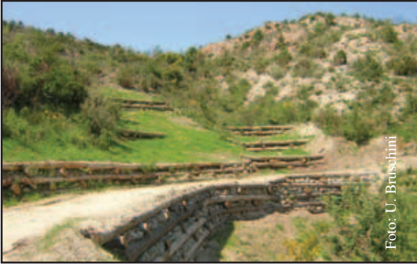
Foto 20.8: Una porzione di area percorsa dal fuoco, sistemata con impiego di palificate a doppia parete in legname di castagno ed idrosemina su terreno preparato con chips legnosi e compost, a circa 45 giorni dall'intervento - loc. Tosse, Spotorno (SV)
