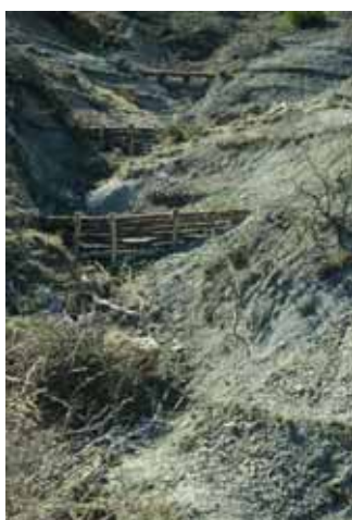
Foto 2 e 3: Opere trasversali sui fossi in erosione : palizzate in legno con ramaglia a fine lavori e dopo 3 anni - D. Dallari
