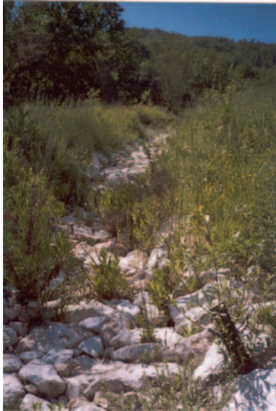
Foto 2: Post-operam della canaletta il pietrame rinverdita con talee di Salix spp.
