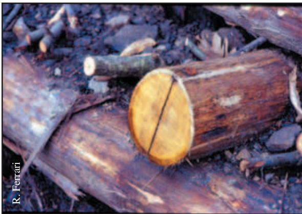
Foto 24.7: Modalità di assemblaggio errata mediante semplici chiodi battuti (palificata viva doppia): inevitabile spaccatura del legname con conseguente indebolimento generale della struttura ed accelerazione del processo di degrado del materiale
