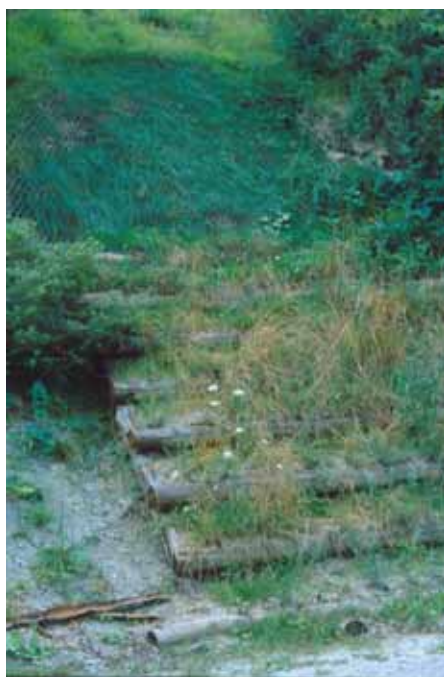
Foto 10: SP Tarugo agosto 2002 grata e rivestimento vegetativo - P. Giacchini
