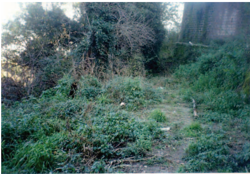
Foto 1: Ante-operam del versante da sistemare con gabbionate rinverdite e piantagione, marzo 2003. Foto di ing. Formichella
