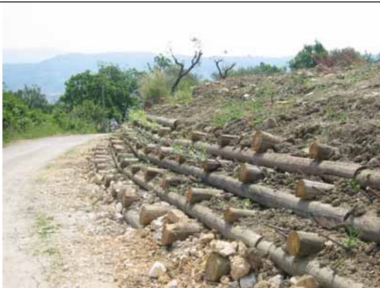
Palificata viva di versante da poco realizzata Spigno Saturnia (LT)
