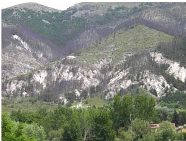
Foto 2: Le palizzate, unitamente alla piantagione degli arbusti autoctoni, hanno permesso il recupero della protezione antierosiva della vegetazione (novembre 2003) - Sacchetti, Liberatore
