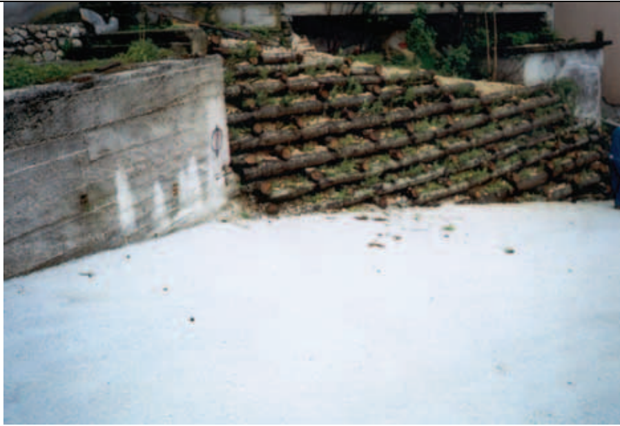
Foto 1: Stato post-operam della palificata viva doppia, maggio 2004. Foto di A. Cortese
