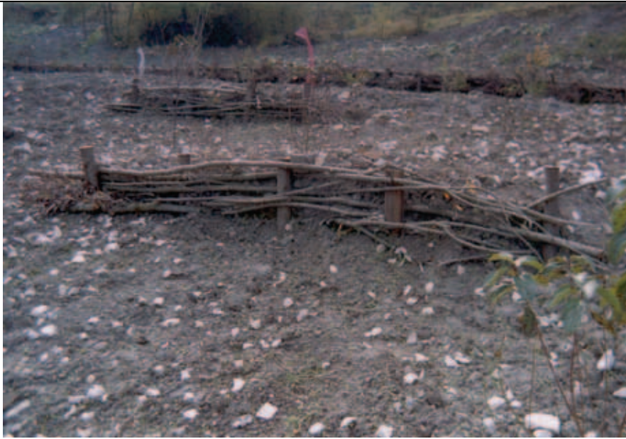
Foto 3: In opera di una viminata viva, ottobre 2003. Foto di A. D'Andrassi
