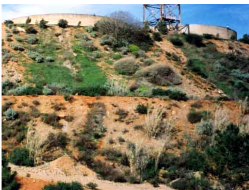
Stabilizzazione di scarpate mediante messa a dimora di arbusti della gariga mediterranea Campo Pisano (CA), 2003
