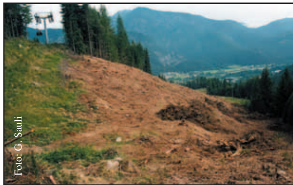
Foto 21.10, 21.11, 21.12: Aspetto di piste da sci di recente realizzazione su substrato calcareo (21.10: Piancavallo (PN) - G. Sauli 2004 e 21.11, - G. Peratoner 2002; 21.12, Prampero (UD) G. Sauli, 2004). In queste situazioni l'abbondanza di scheletro e la carenza di sostanza organica nel suolo sono da annoverare tra i fattori critici per l'inerbimento, affrontabile solo con scotici nella fase successiva al taglio della vegetazione e riporto di suoli organici sulle piste
