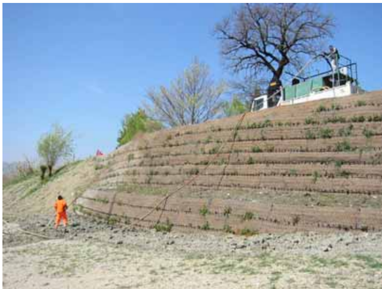
Foto 4: Idrosemina potenziata sulle terra rinforzata rinverdita (marzo 2002) - P. Cornelini
