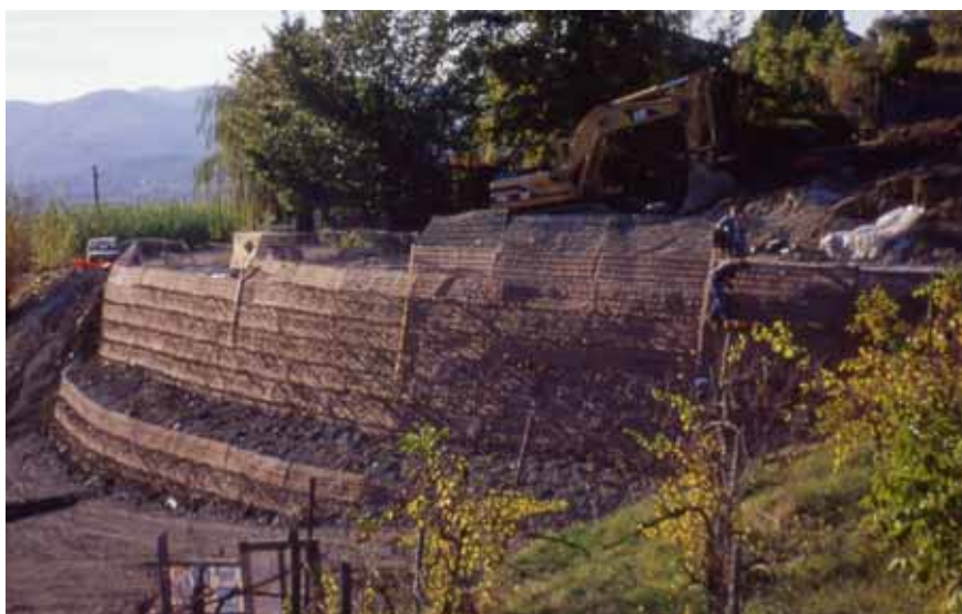
Terra rinforzata verde in fase di costruzione Atina (FR), 2002
