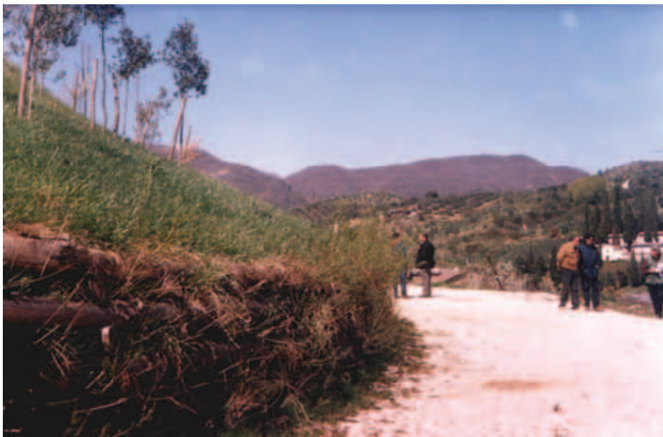
Foto 1: Palificata viva doppia appena ultimata con piantagione di alberi a monte della stessa, aprile 2003. Foto di S. Madonna
