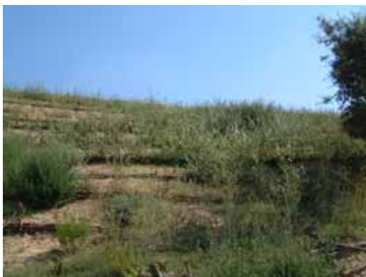
FOTO 15: Zona sistemata con gradonate, viminate e fascinate dopo 8 mesi - D. Dallari
