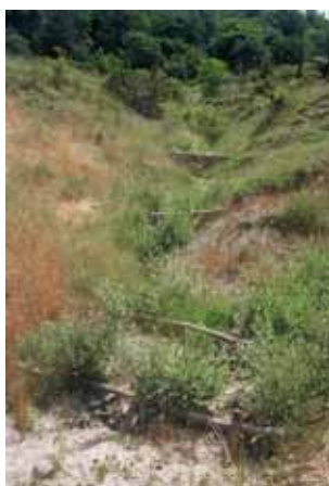
Foto 2 e 3: Opere trasversali sui fossi in erosione : palizzate in legno con ramaglia a fine lavori e dopo 3 anni - D. Dallari
