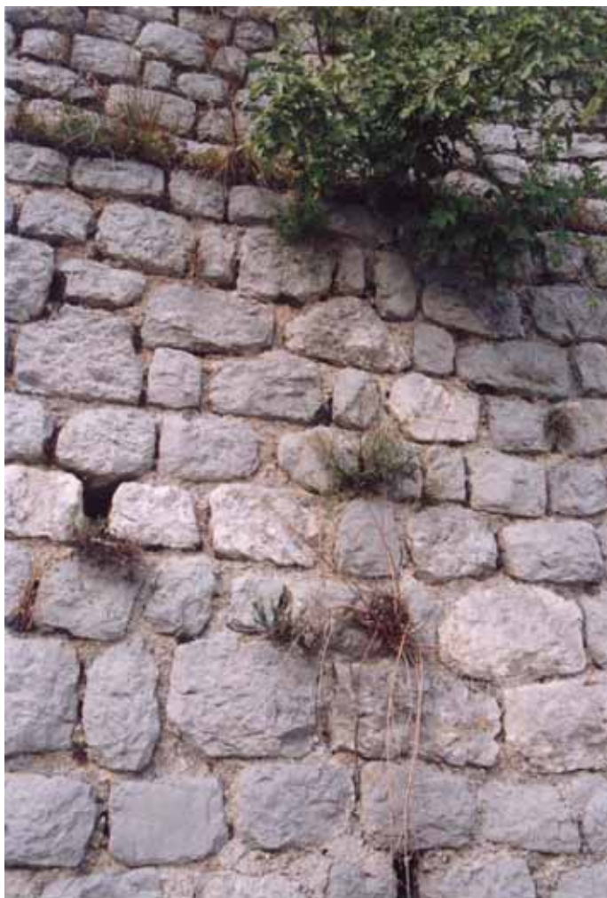
Muro in pietra con parziale cementatura Strada per monte S. Simeone (UD), 2003
