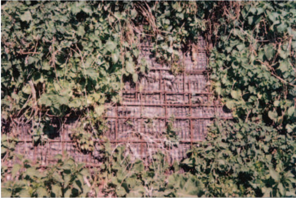
Foto 3: Particolare della terra armata con rinverdimento spontaneo, aprile 2003. Foto di S. Madonna
