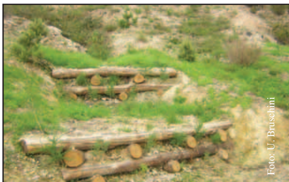
Foto 20.6: Avvio dei processi di ricostituzione della vegetazione, a 30 giorni dalla semina e dalla ripresa vegetativa degli arbusti posti a dimora nelle palificate in legname loc. Tosse, Spotorno (SV)
