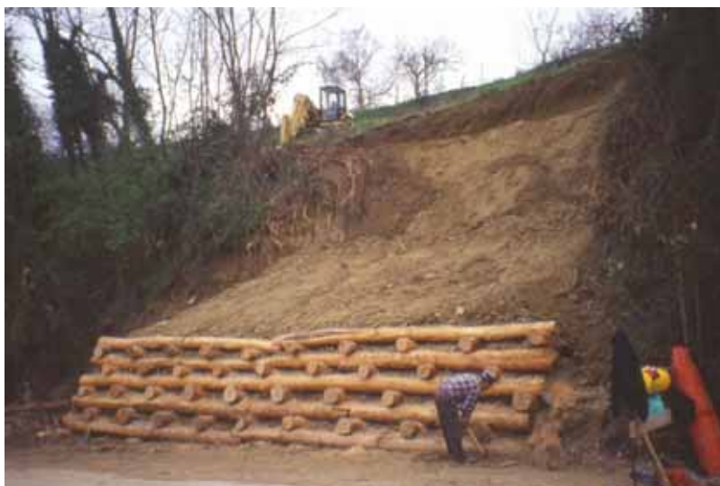
Foto 2: Interventi di sistemazione di un versante della frana 1 (marzo 2000) - P. Cornelini
