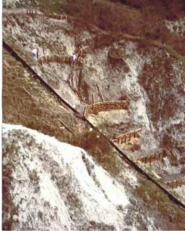
Foto 3: Impluvio secondario. Interventi di rialzamento del fondo, Febbraio 1999. - Bernabei, Mazzoni, Pei
