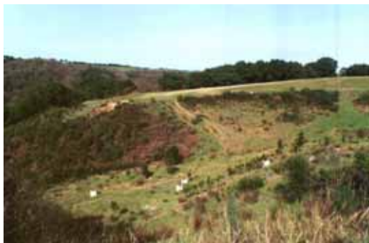
FOTO 1: Visione d'insieme di una zona dell'area d'intervento con degrado della copertura forestale e fenomeni erosivi di erosione incanalata - D. Dallari
