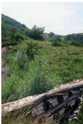
Foto 6 e 7: Opere combinate di consolidamento tipo palificate doppie in legno e pietrame con gradonate rinforzate protette con semina su coltre di paglia tenuta con juta: a fine lavori e dopo 4 anni – D. Dallari
