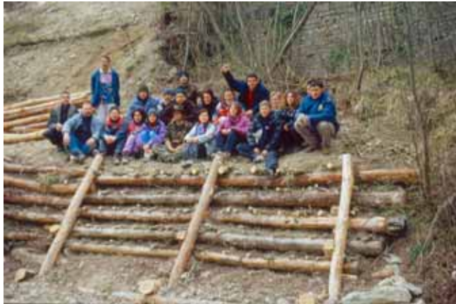
Foto 7: SP Tarugo aprile 2003 palificata Roma a fine lavori - P. Giacchini
