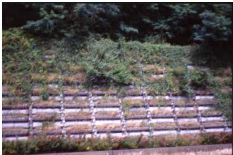
Muro cellulare rinverdito Autostrada dei Trafori (VB), 2001
