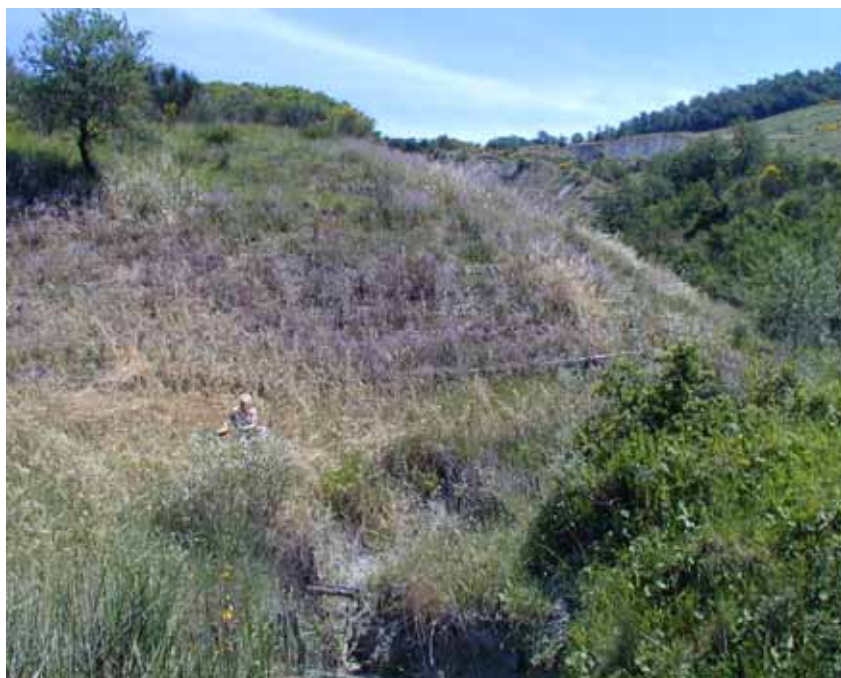
Foto 6: Grata, copertura diffusa e palizzate filtranti alla prima stagione vegetativa - Bernabei, Mazzoni, Pei
