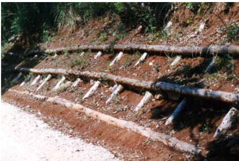
Foto 7: Vista della grata a opera completata
