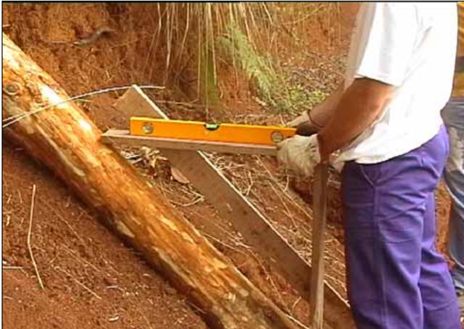
Foto 3: Verifica del corretto posizionamento dei tronchi verticali
