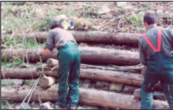
Foto 23.5: Recupero delle fallanze in una palificata viva di sostegno doppia
