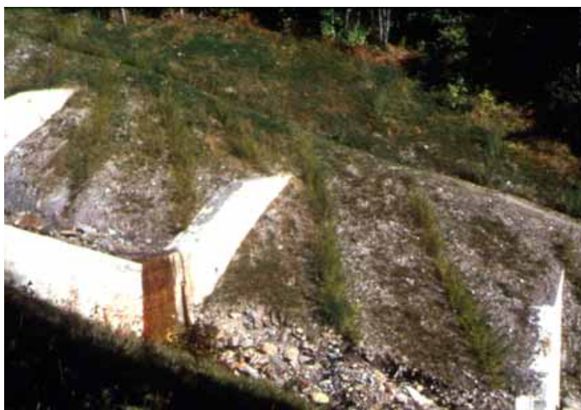
Fascine drenanti dopo sei mesi Vipiteno (BZ), 1990
