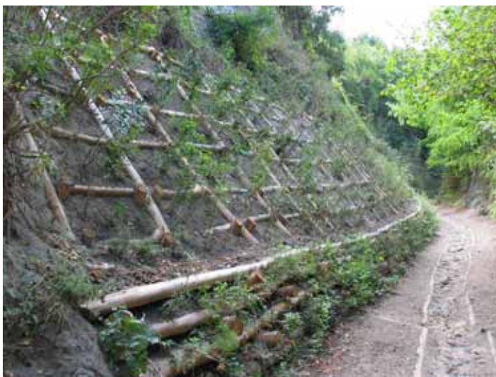
Foto 3: Palificata doppia con grata Vesuvio sec. Menegazzi con arbusti radicati; fine lavori settembre 2003 Monte Somma - G. Menegazzi
