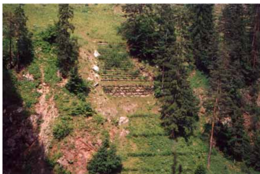
Grate viva di versante Loc. Ponte ad Arco – Tarvisio (UD), 2003
