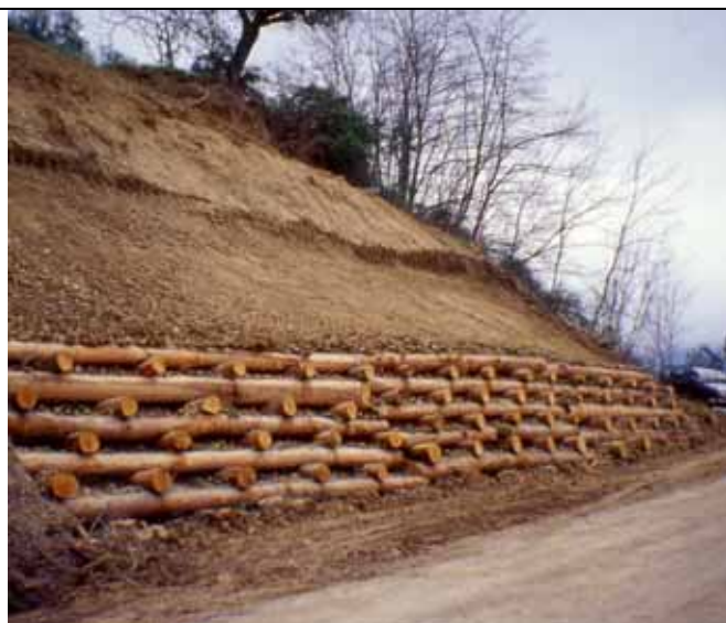
Palificata viva di versante appena realizzata Atina (FR), 2000
