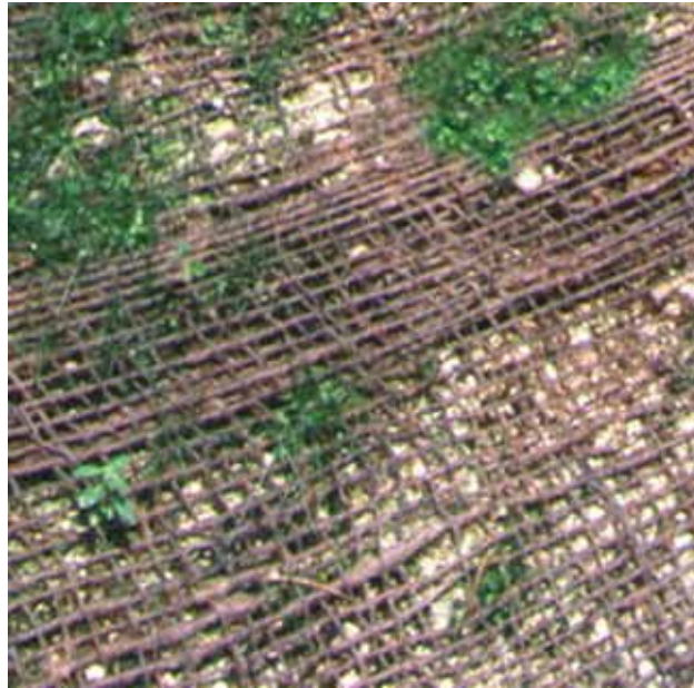
Particolare stuovia in juta
