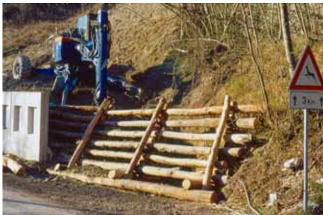
Foto 6: SP Tarugo struttura palificata Roma, aprile 2003 - P. Giacchini
