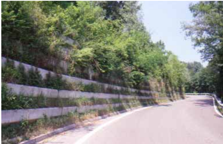
Muro cellulare rinverdito Sequals (PN), 2000
