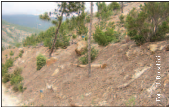
Foto 20.5: Copertura di terreno percorso dal fuoco con chips legnosi e compost, abbinato a palizzate vive in legname – loc. Voze, Noli (SV)
