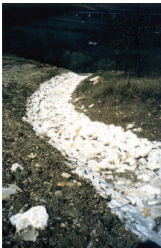
Foto 2: In operam del collettore in pietrame, marzo 2003. Foto di C. Milanese
