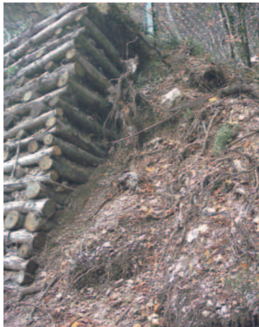
Foto 3: Particolare del raccordo opera versante, novembre 2003. Foto di C. Milanese
