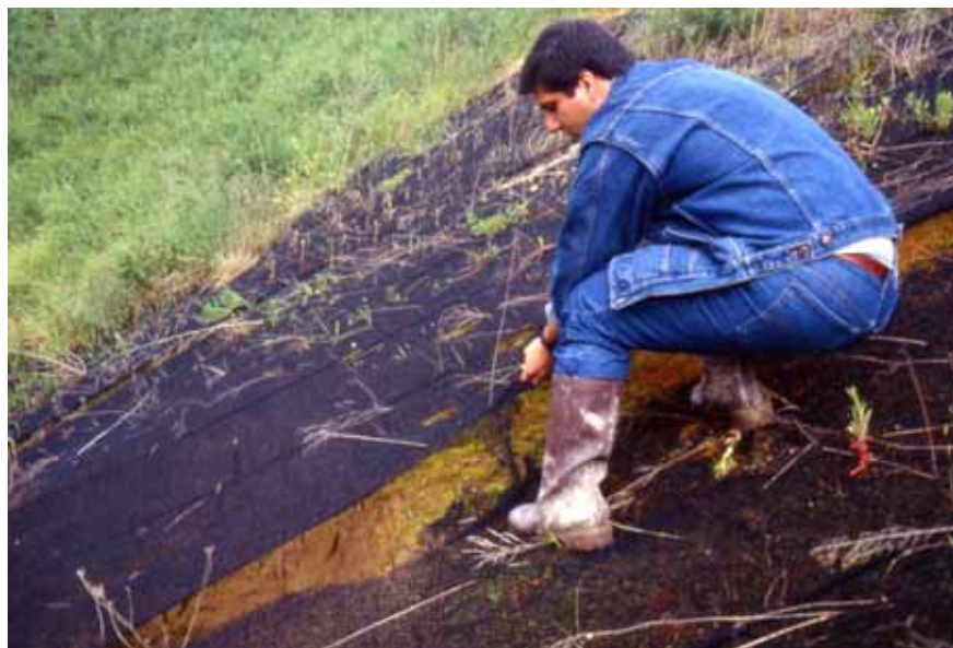
Stesura geostuoia tridimensionale sintetica Linea direttissima RM-FI, Valdarno 1991
