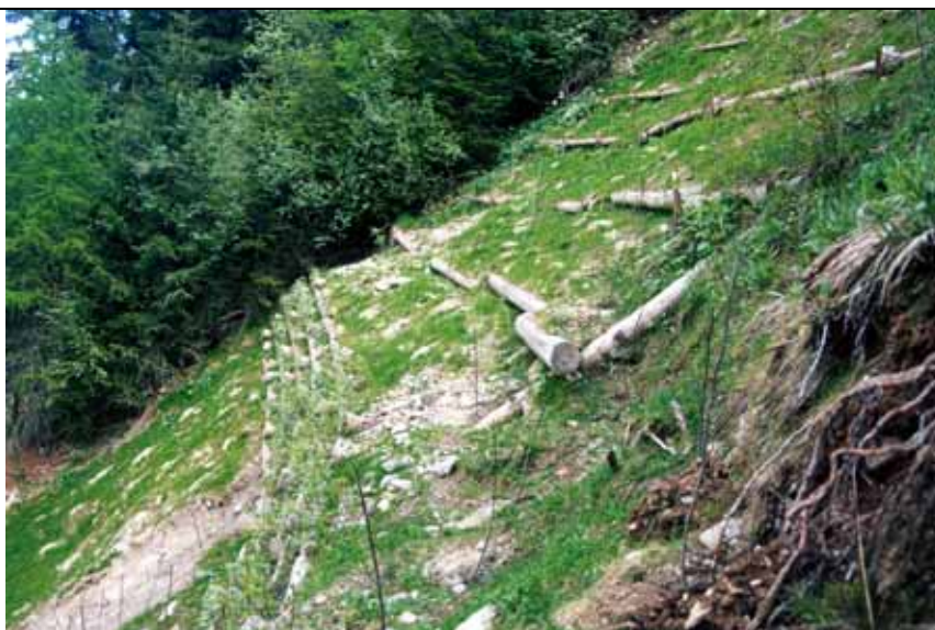
Grate viva di versante Strada per lo Stelvio (BZ), 2004
