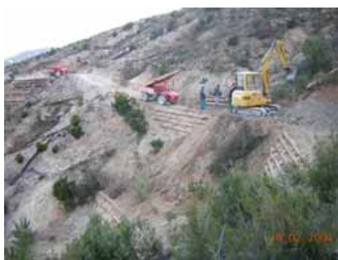
Foto 5: Impiego di mezzi meccanici leggeri per la realizzazione di opere di I.N., a margine di viabilità di servizio – febbraio 2004 - U.Bruschini
