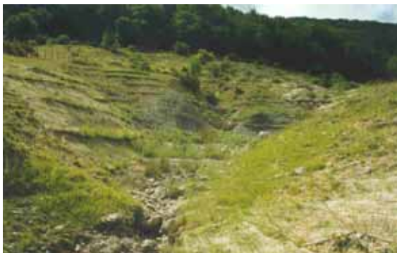
Foto 12, 13 e 14: Visione d'insieme di una zona d'intervento alla fine dei lavori, dopo 3 mesi e dopo 4 anni – D. Dallari
