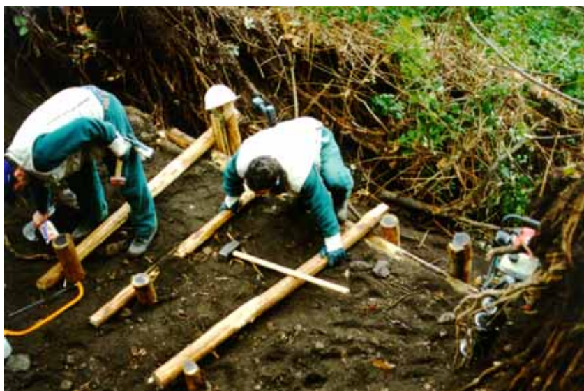
Foto 1: Operai L.S.U. in fase di realizzazione di una palificata Vesuvio sec. Menegazzi (ottobre 1999) - G. Menegazzi
