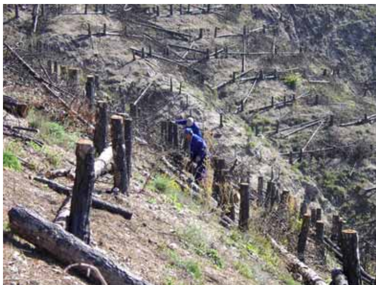
Foto 1: Lavori di realizzazione delle palizzate morte (ottobre 2002) - Sacchetti, Liberatore
