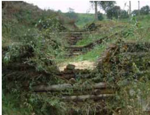
Foto 10, 11: Briglie in legno e pietrame, con inserimento di salici e piantine radicate subito dopo la realizzazione e dopo 8 mesi - D. Dallari
