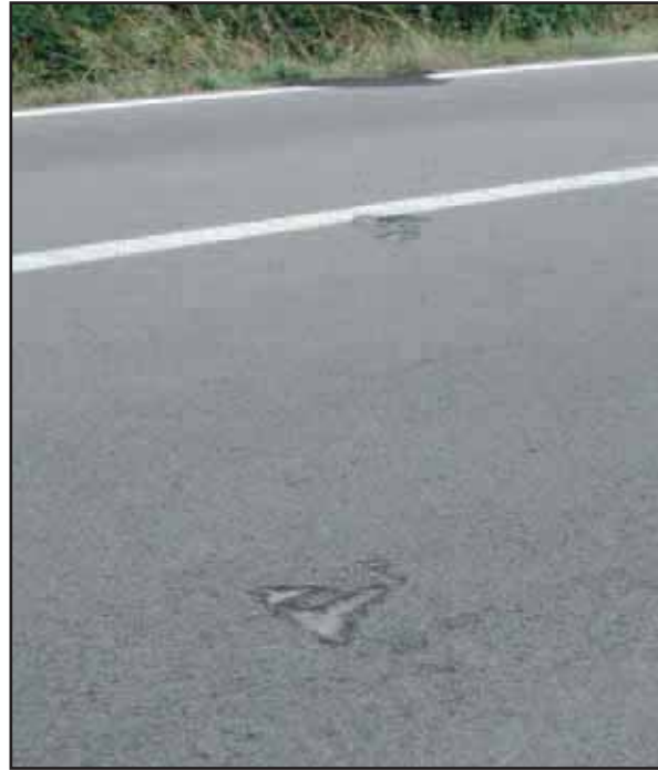
Foto 11.1, 11.2 e 11.3: Scarpata subverticale impostata su lave fratturate ed interessate da vegetazione arborea. Si può notare il punto di distacco di un masso di circa 1 mc che, dopo il distacco, è rotolato sul versante sottostante, rimbalzando sulla SS2 Cassia e terminando la corsa nel campo adiacente
