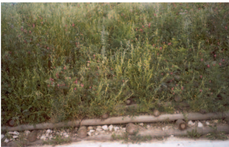
Foto 1: Vista frontale della palificata doppia ad un anno dalla realizzazione, maggio 2004. Foto di C. Milanese
