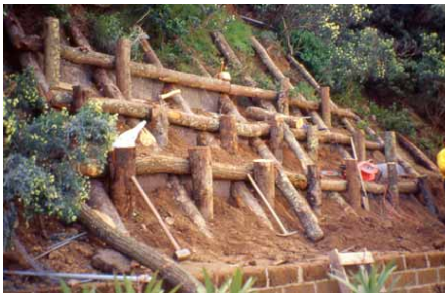
Grata viva doppia su scarpata in fase di realizzazione Punta Ala (GR), 2001
