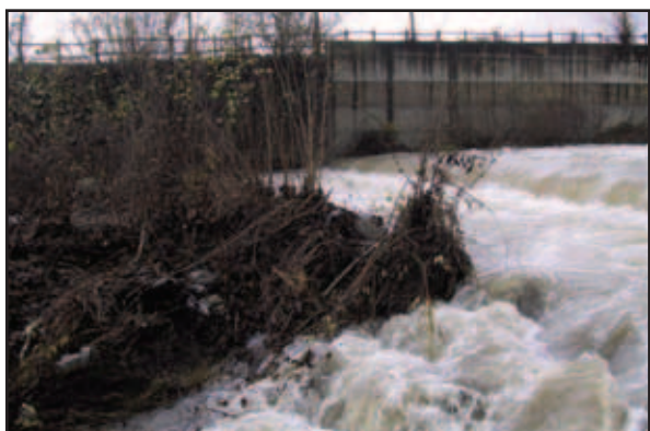
Foto 23.7 e 23.8: Presenza di vegetazione in alveo nelle vicinanze di opere idrauliche.
