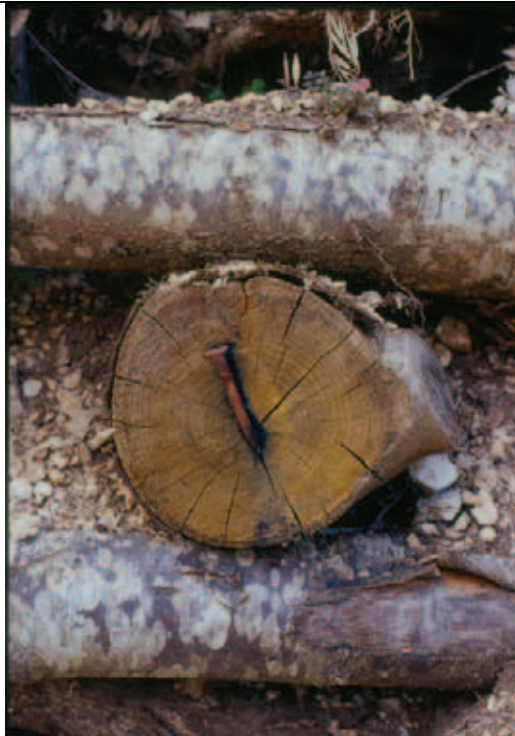
Foto2: Particolare della chiodatura della palificata, maggio 2003. Foto di A. D'Andrassi
