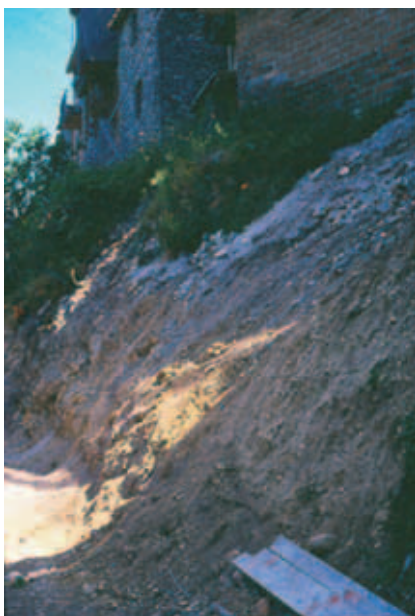
Foto 2: Ante operam della parte del versante da sistemare con la palificata viva doppia, maggio 2003. Foto di P. Gaglioppa
