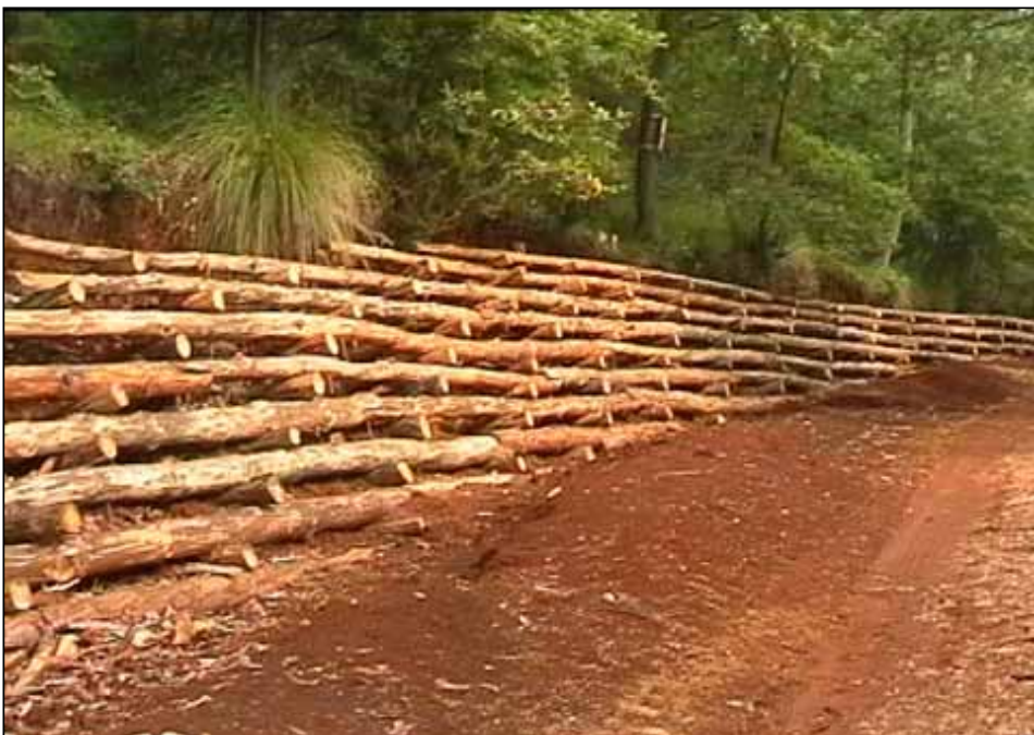
Foto 4: Vista prospettica dell'opera
