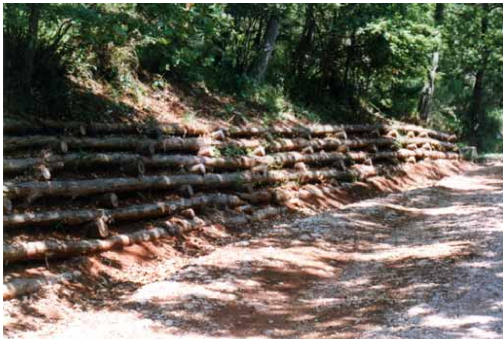
Foto 6: Palificata viva semplice a 3 mesi dalla realizzazione, Spigno Saturnia (LT) - giugno 2003
