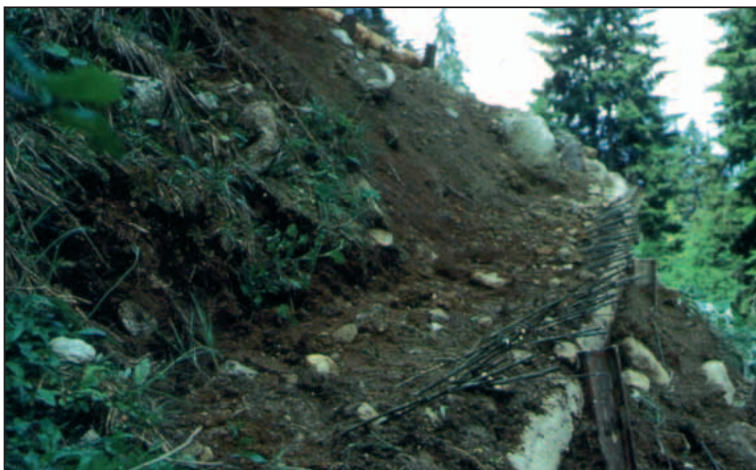
25) Cordonata viva con piloti a lavori appena terminati; Val Passiria (BZ) Foto: F. Florineth
