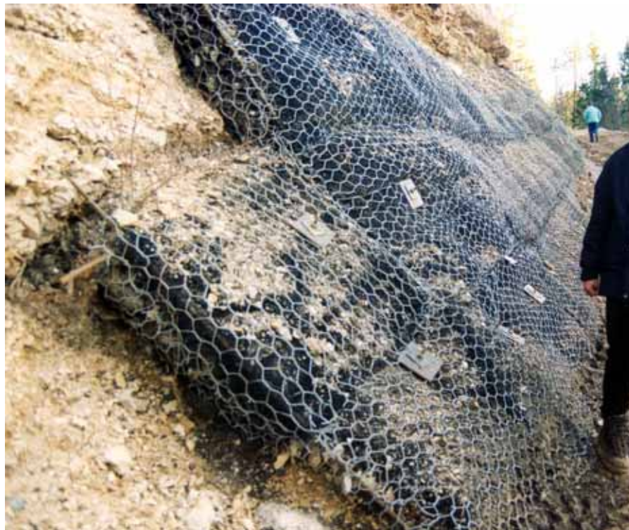
Rivestimento vegetativo a materasso Tarviso (UD), 2000
