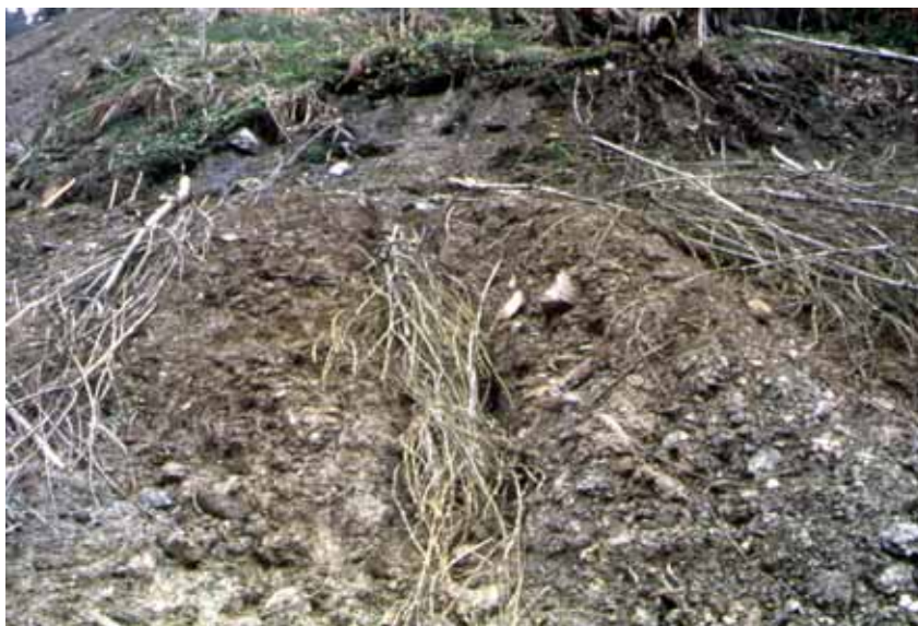
Messa a dimora fascine drenanti di salice Vipiteno (BZ), 1989
