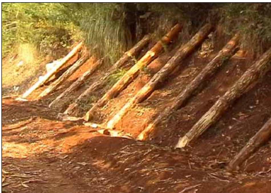
Foto 2: Posa in opera dei tronchi verticali
