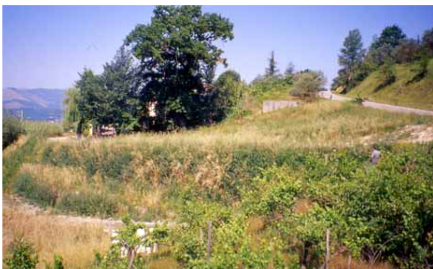
Terra rinforzata verde post operam Atina (FR), 2003
