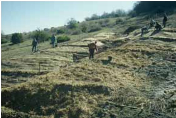
Foto 11: Fasi della semina con coltre protettiva di paglia e disposizione di rete di juta -D. Dallari
