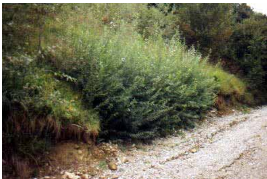
Palificata viva dopo un anno Loc. Montenars (UD)
