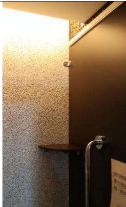
圖六 廁間內設置照明自動感光點滅裝置，以節省電源及如廁安全感。(來源：內政部建築研究所，2015)
