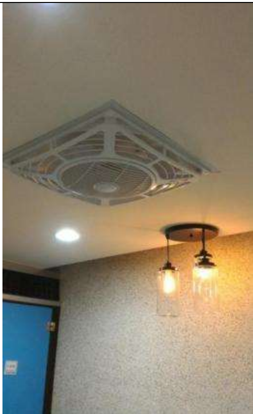
圖五 廁所內採機械換氣，減少廁所臭味。(來源：內政部建築研究所，2015)
