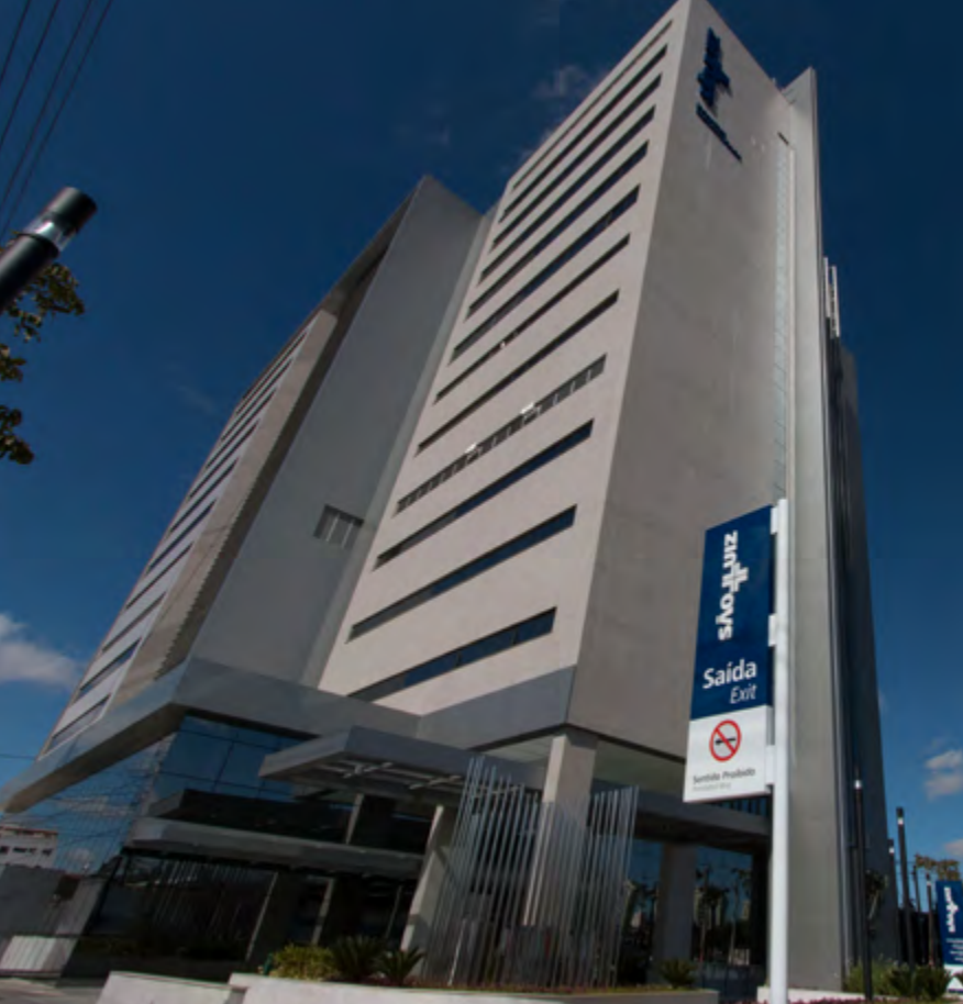
Hospital São Luiz – São Caetano. Adoção de tecnologias modernas e de melhores procedimentos com vistas à construção mais sustentável possível.
