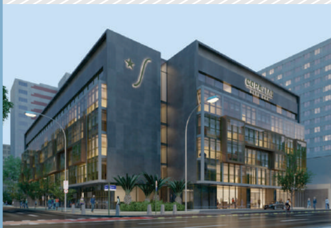
Hospital Copa Star, Copacabana - RJ Em construção
