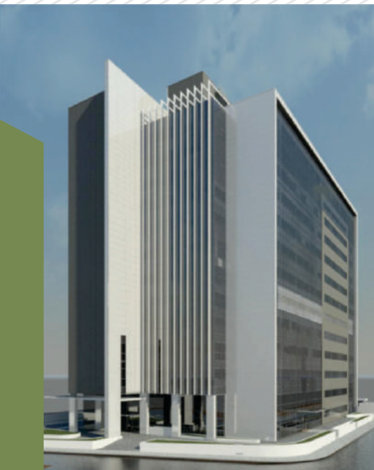
Hospital São Luiz, São Caetano, SP Em construção
