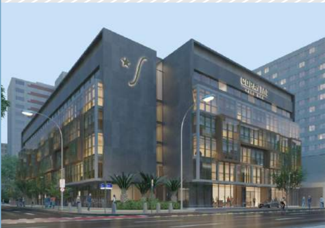
Hospital Copa Star, Copacabana - RJ Em construção
