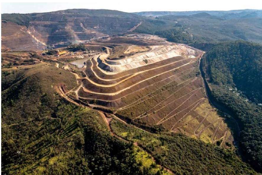
Vista da PDE Capão da Serra
