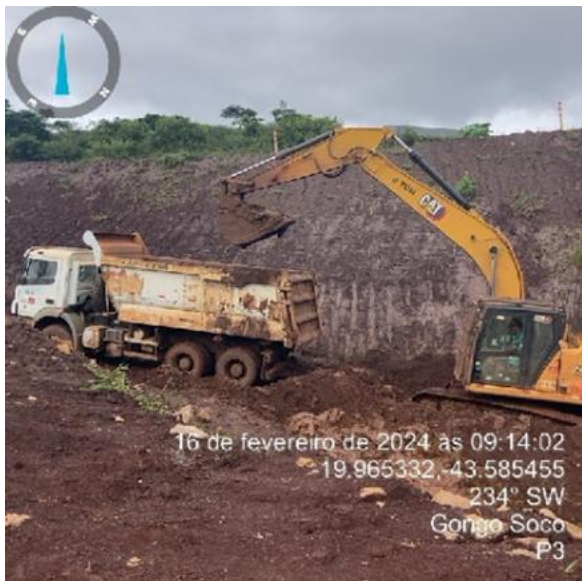
Foto 17: Limpeza do Sump P3. Fonte: Vale, 2024
