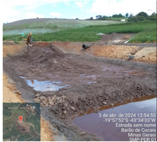
Foto 16: Limpeza do Sump da PDR. Fonte: Vale, 2024
