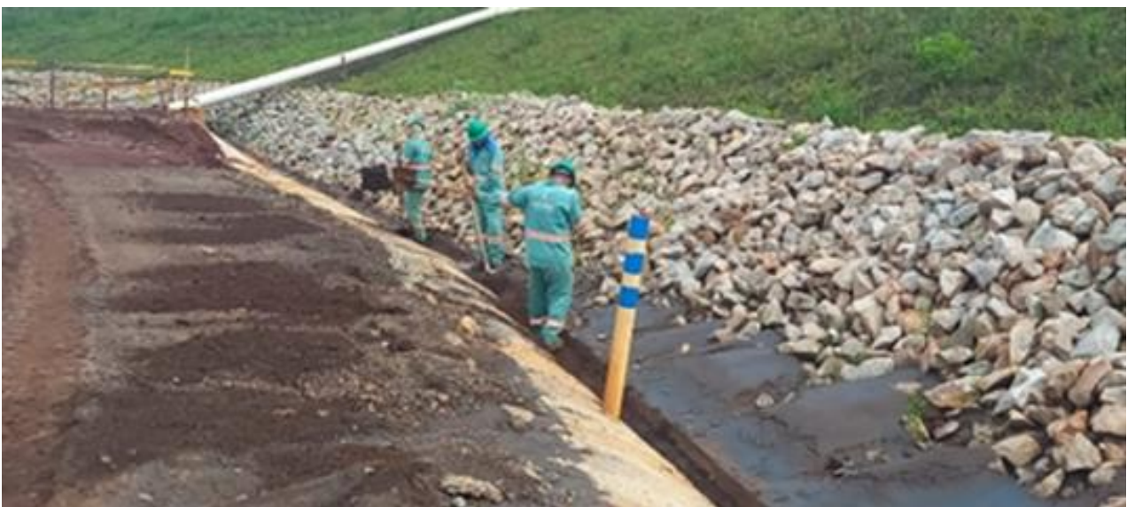
Foto 12: Execução de descida d'água na PDR. Fonte: Vale, 2024.
