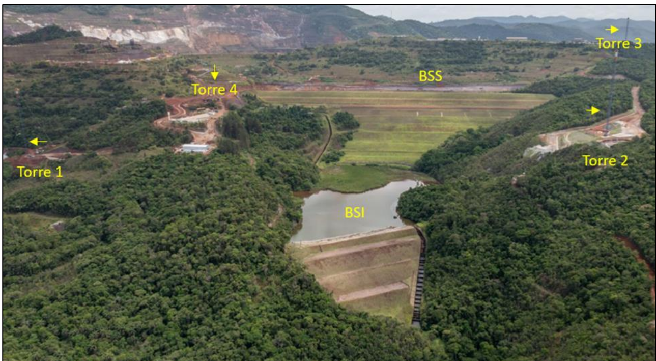
Foto 9: Aspecto geral da implantação das Torres do Lift Line. Fonte: Vale, 2024.
