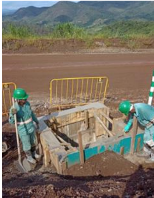
Foto 13: Execução de caixa de passagem PDR. Fonte: Vale, 2024.
