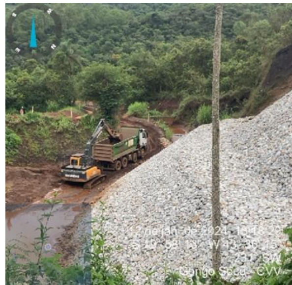
Foto 18: Limpeza do Sump Torre 01. Fonte: Vale, 2024
