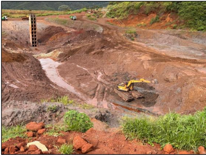
Foto 7: Avanço na escavação do canal principal, canal da tulipa (Vale, março/2024).
