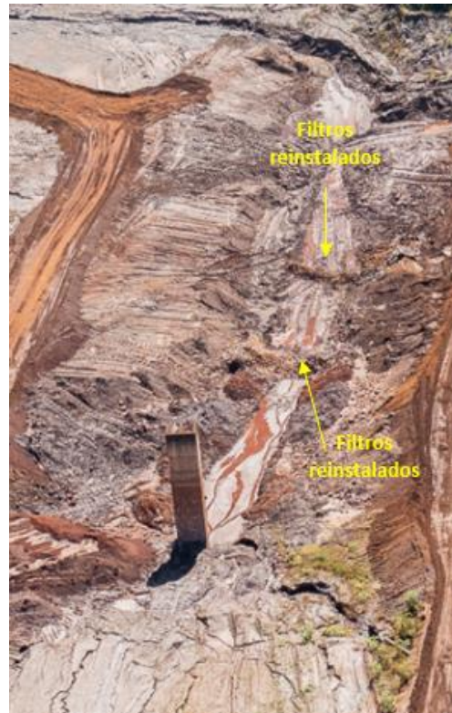
Foto 8: Reinstalação dos filtros de pedra a montante do canal da tulipa (Vale, março/2024).
