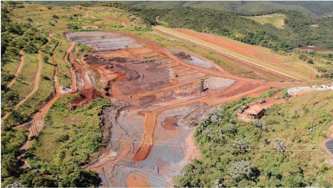
Foto 4. Vista reservatório da barragem sul superior (24/04/2024), escavação do platô.
