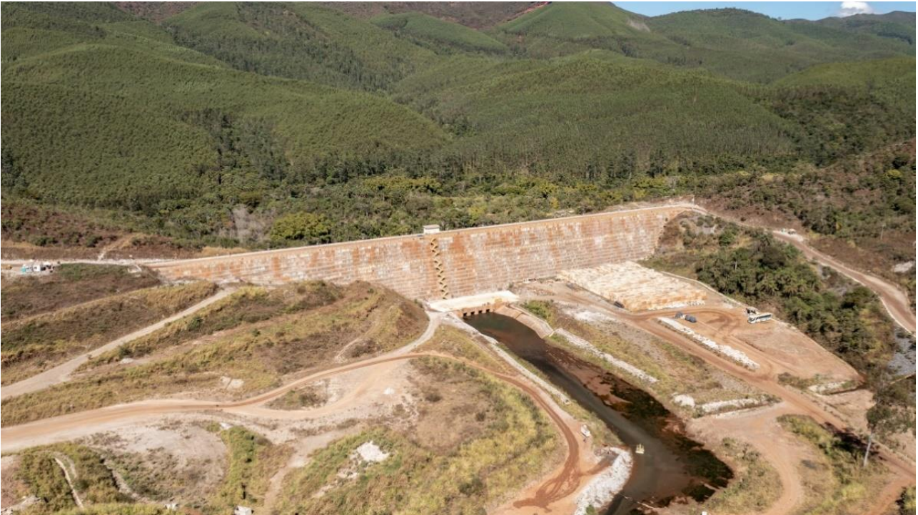
Foto 1. Estrutura de contenção a Jusante (ECJ) da Barragem Sul Superior.
