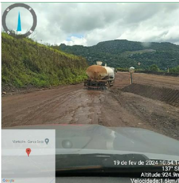
Foto 26: Umectação de vias na PDR (fevereiro/2024). Fonte: Vale, 2024.
