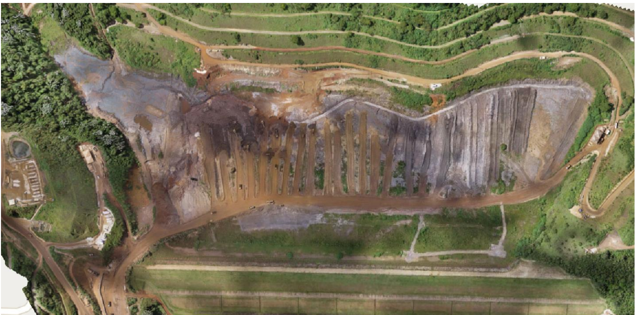
Figura 18: Visão geral – canal no reservatório de drenagens – sump – desvio e disciplina de águas – abril/2024.
