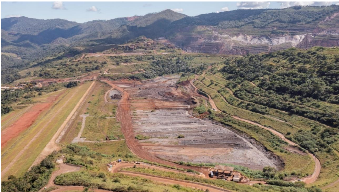
Foto 5. Vista ombreira esquerda da barragem Sul Superior – Remoção de rejeitos no reservatório (24/04/2024).
