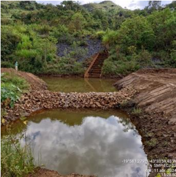
Foto 15: Vista do sump do ECJ2. Fonte: Vale, 2024
