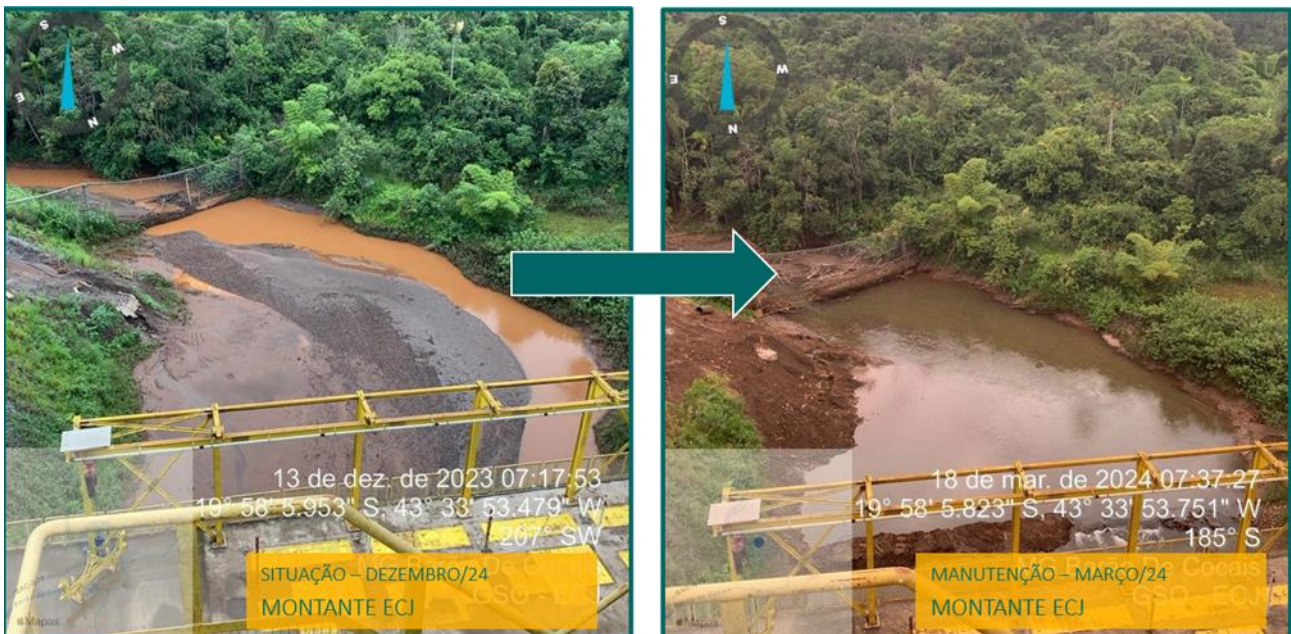
Foto 19: Desassoreamento do rio São João, à montante da ECJ. Fonte: Vale, 2024
