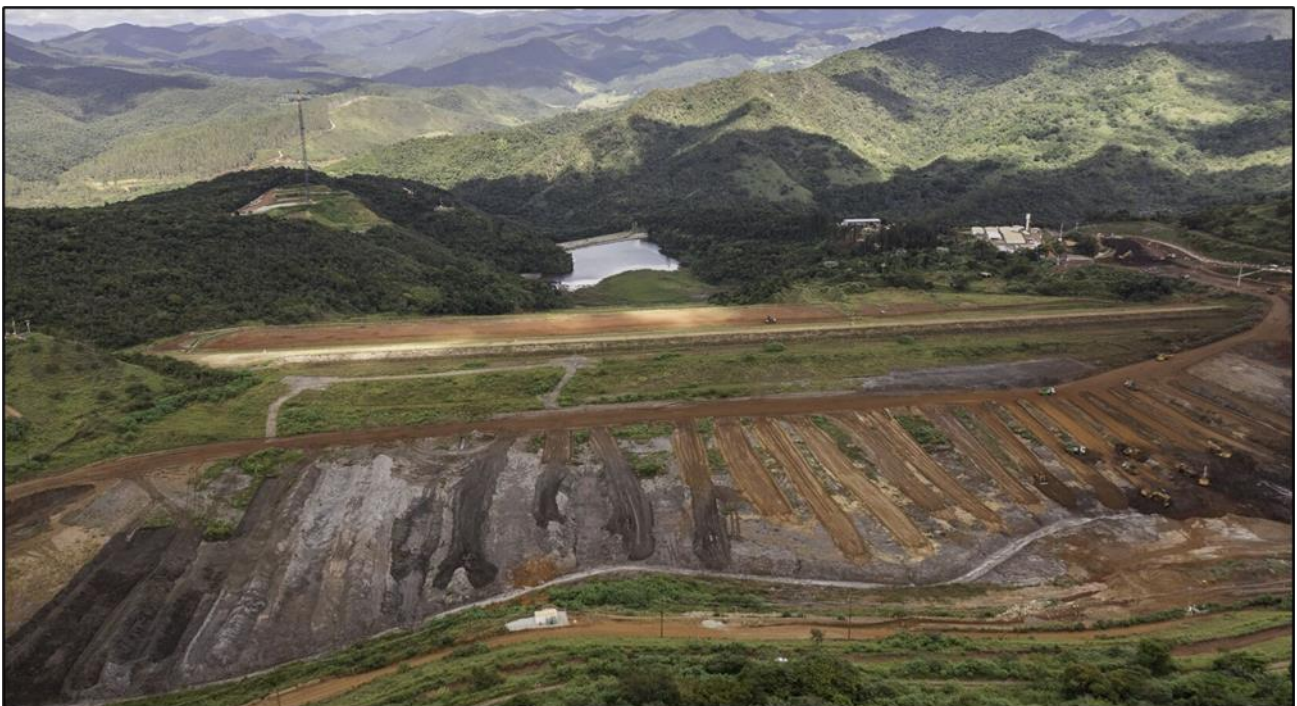
Foto 6. Aspecto geral do Reservatório da BSS: evolução na escavação dos canais principal e periférico no reservatório (março/2024). Fonte: Vale, 2024.
