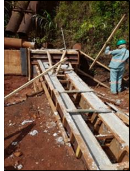
Foto 11: Concretagem de dispositivo de drenagem na Torre 04. Fonte: Vale, 2024.
