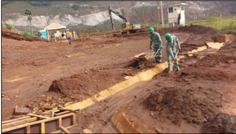
Foto 10: Limpeza da Canaleta Torre 01. Fonte: Vale, 2024.
