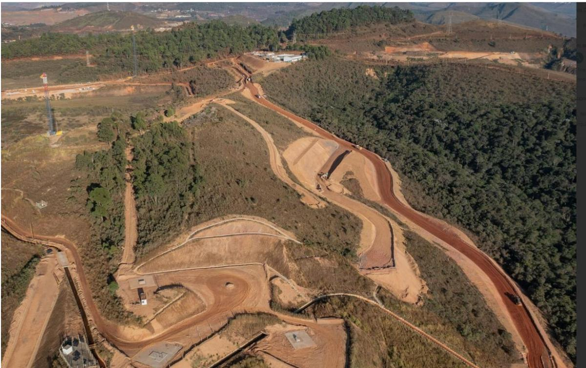
**Foto 9.** Obras de implantação do acesso construtivo na ombreira esquerda de Forquilha III (julho/24)
