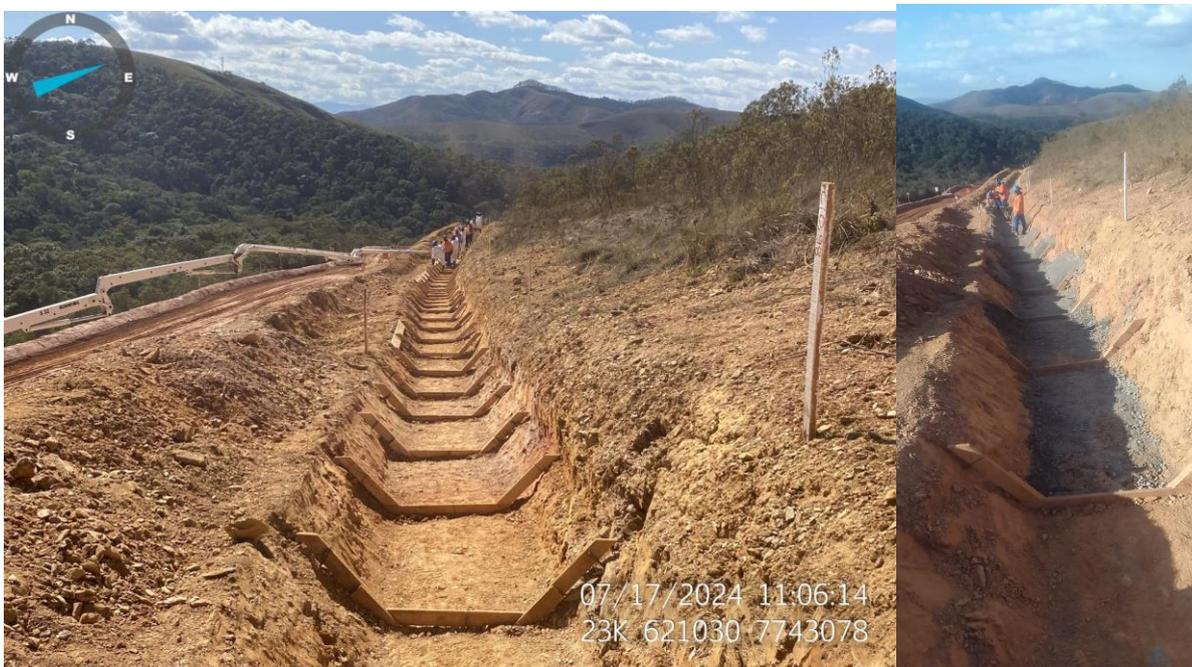
**Foto 44.** Construção de canaletas de drenagem nas bermas dos taludes do acesso operacional da ombreira. Fonte: Vale, 2024.
