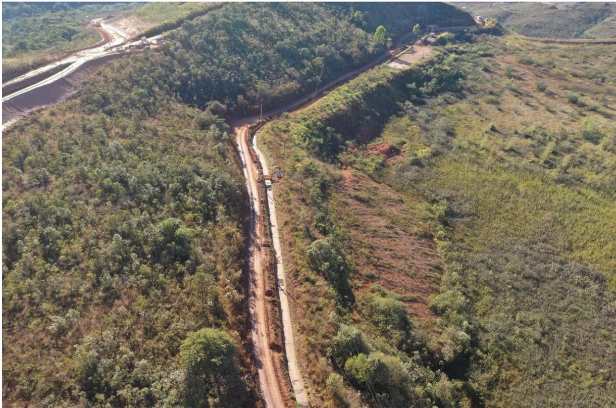
**Foto 36.** Roçada finalizada, limpeza manual finalizada e limpeza com equipamentos em andamento. (Julho/24).
