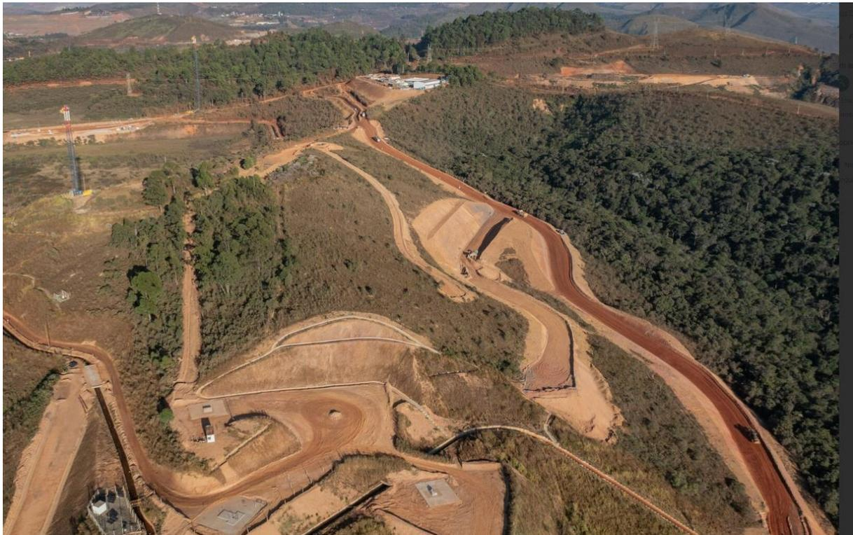
**Foto 32.** Obras de implantação do acesso construtivo na ombreira esquerda de Forquilha III (julho/24)
