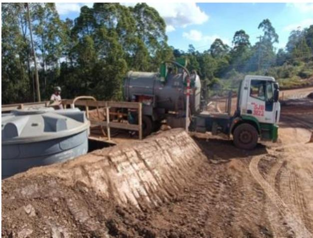
**Foto 52.** Sucção de efluente sanitário armazenado nos tanques sépticos (Fonte: Vale, maio de 2024).
