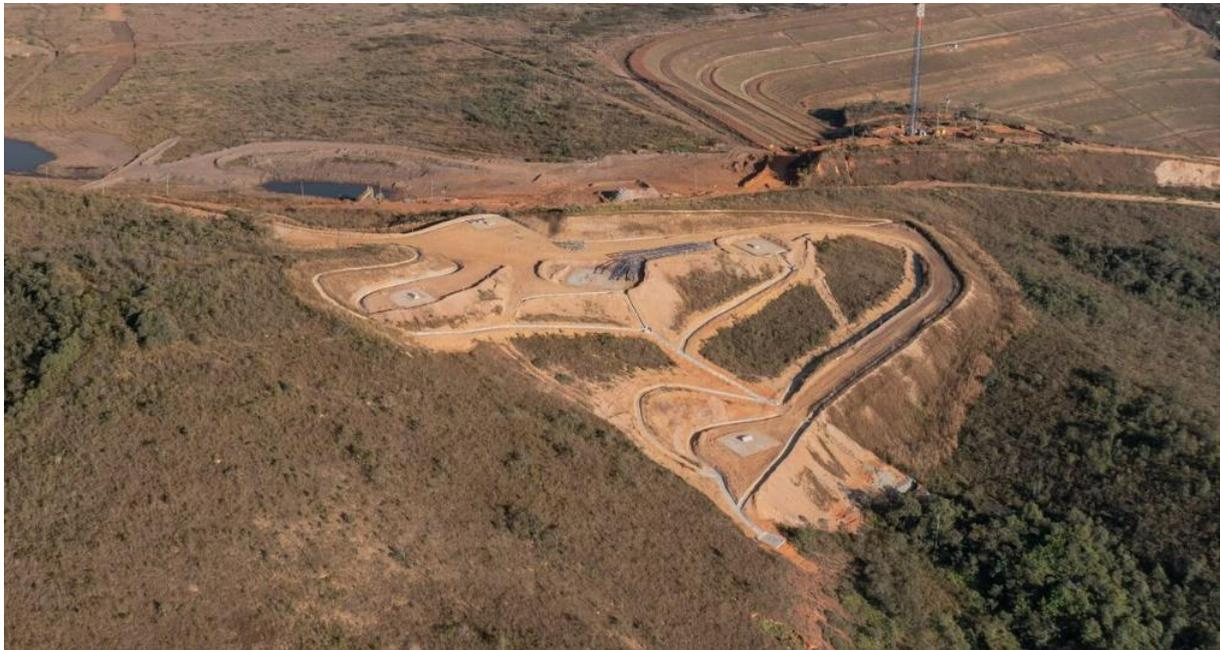
**Foto 1.** Obras de implantação das fundações do Lift Line fase 2 – Torre T3 – Ombreira Direita (Julho/24).
