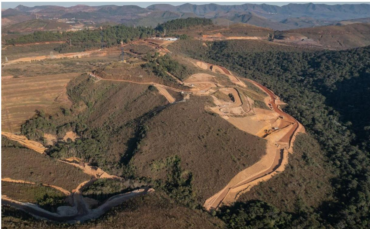
**Foto 33.** Obras de implantação do acesso construtivo na ombreira esquerda de Forquilha III (julho/24)
