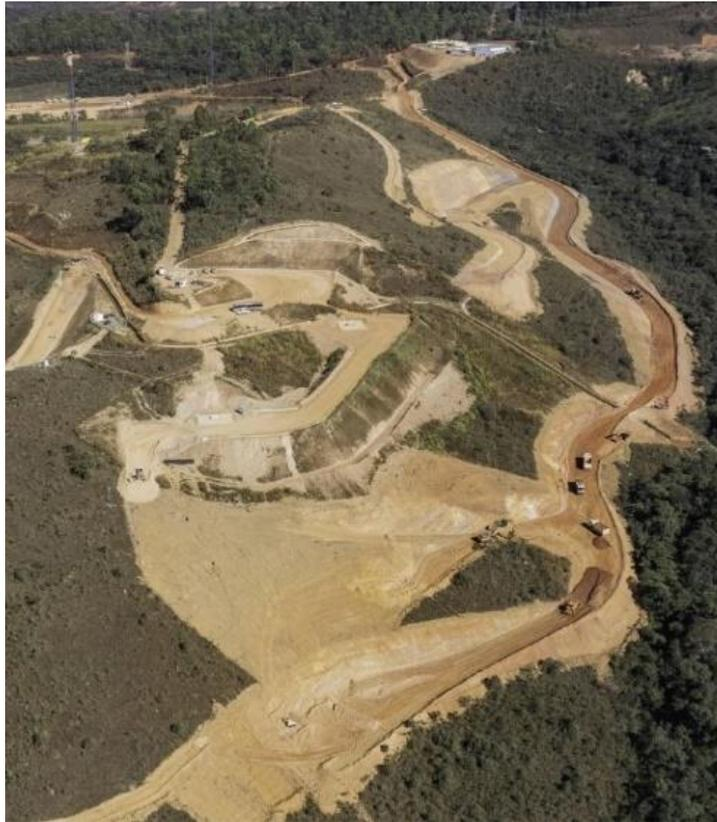
**Foto 43.** Execução da remoção de topsoil pela Construtora Barbosa Mello (fonte: Vale, 2024).
