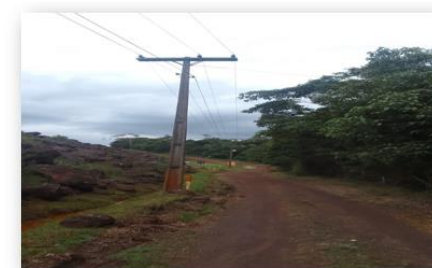
6 Remoção de postes de concreto
