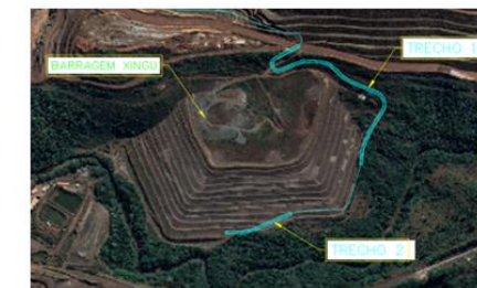
8 Acesso principal (adequação - BVP, 2022)
