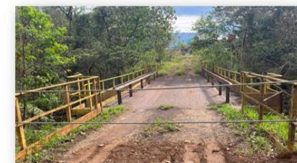
7 Ponte sobre o Rio Piracicaba
