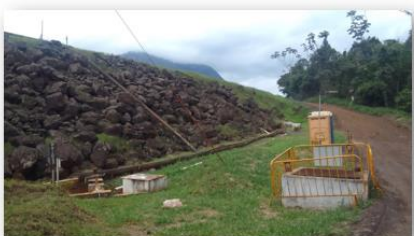
2 Saída medidor de vazão
