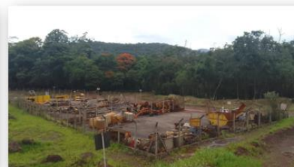
5 Remoção do pátio de estocagem
