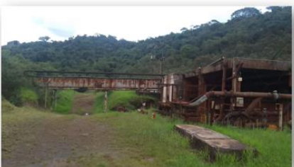
3 Desmontagem e demolição
