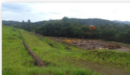
4 Desmontagem da tubulação
