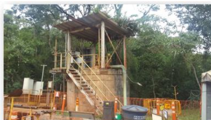
1 Desmontagem e demolição
