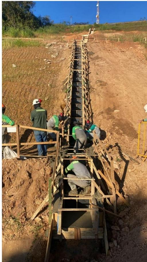
**Foto 22:** Execução de descida d'água
