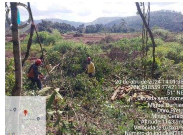
**Foto 19:** Execução de supressão com uso de motosserra
