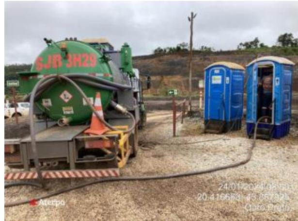
**Foto 33.** Limpeza e higienização dos banheiros químicos. Sucção de tanque sépticos no canteiro de obras. Fonte: Vale, 2024.
