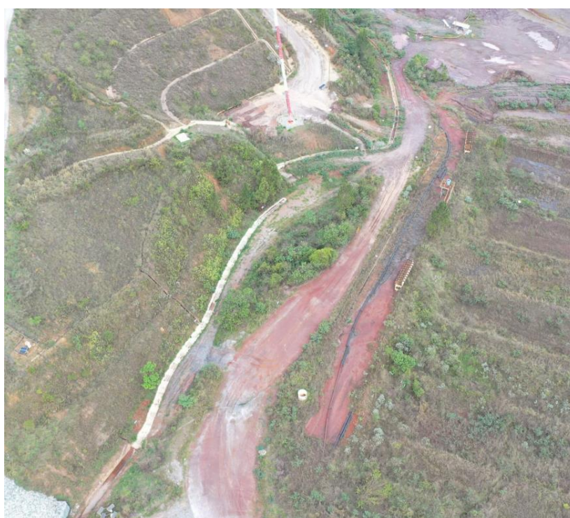
Figura 29 - Status da limpeza e desobstrução dos canais de cintura – Forquilha II (Outubro/24).
