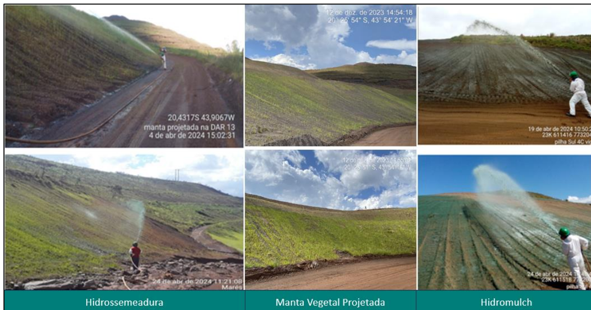
Figura 60 - Hidrossemeadura e Manta Vegetal Projetada, bem como Hidromulch. Fonte: Vale, 2024.
