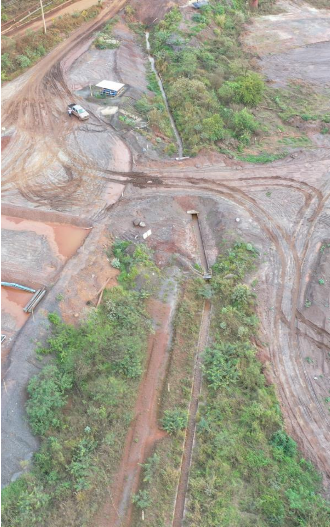
Figura 31 - Status da limpeza e desobstrução dos canais de cintura – Forquilha II (Outubro/24).
