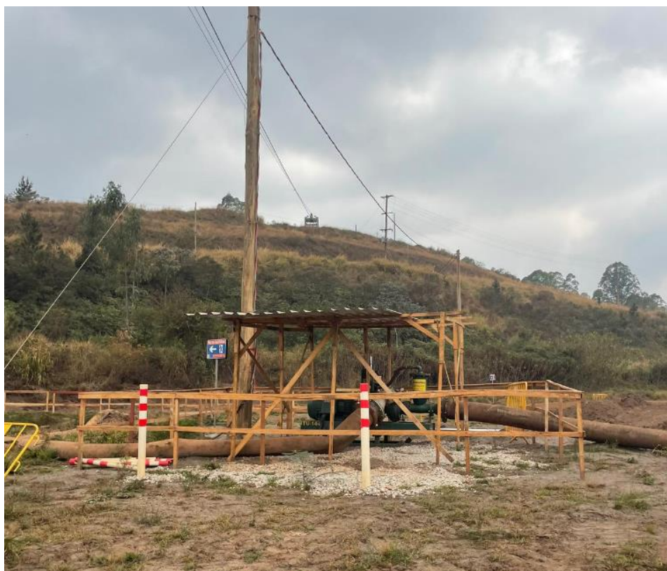
Figura 16 - Melhorias na praça de posicionamento das bombas de Forquilha II – Recomendação F2-0154 (Outubro/24).
