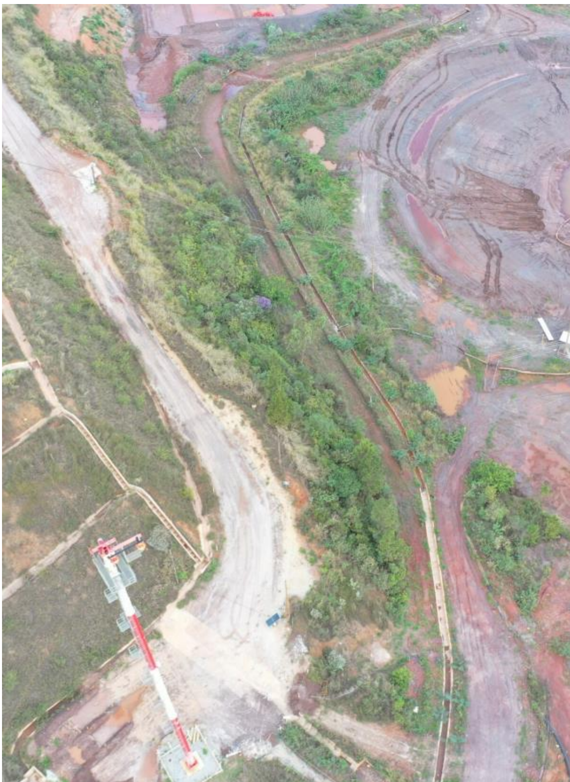
Figura 30 - Status da limpeza e desobstrução dos canais de cintura – Forquilha II (Outubro/24).
