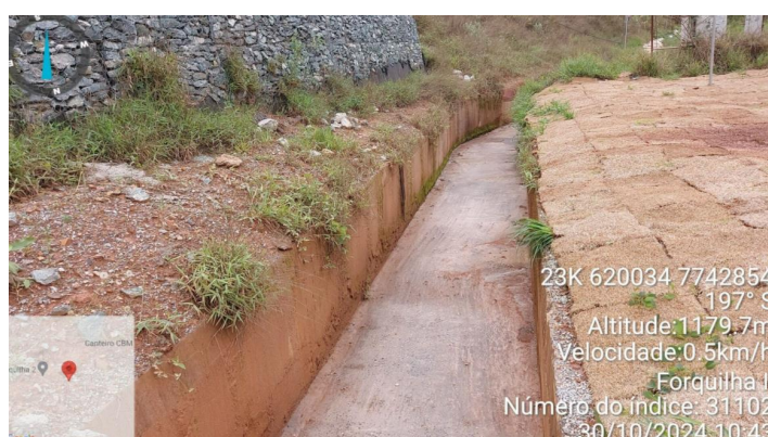
Figura 28 - Status da limpeza e desobstrução dos canais de cintura – Forquilha II (Outubro/24).
