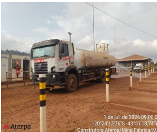
Figura 52 - Atividades de aspersão I. Fonte: Vale, julho, 2024.
