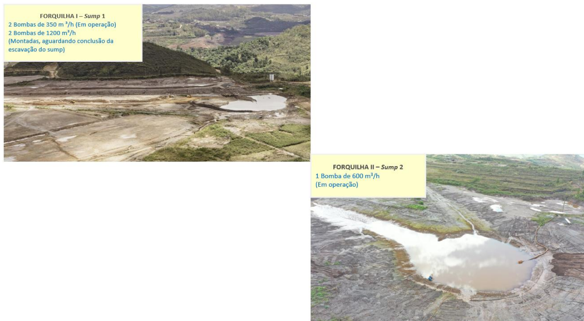
Figura 23 - Sistemas de bombeamento de Forquilha I e II – Em operação (Outubro/24).
