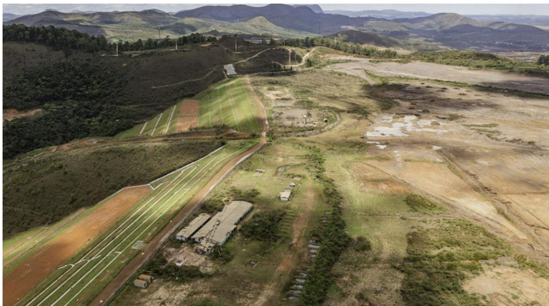
Figura 26 - Visão geral das infraestruturas a serem removidas (Outubro/24).
