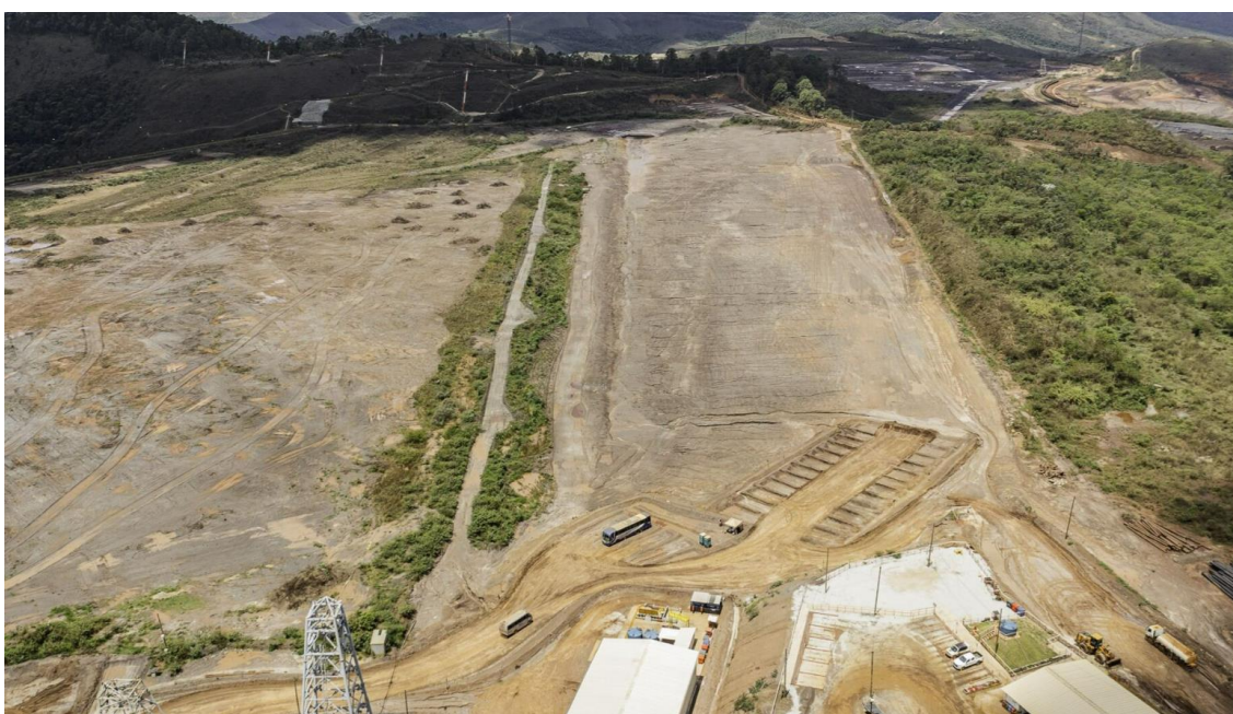
Figura 35 - Forquilha II – Canais e Sump do PPC 24/25 e Dique da Adutora (Outubro/24).
