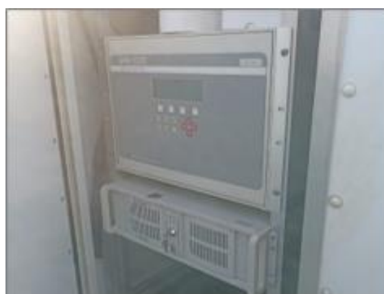
Figura 69 - Estação de Monitoramento de Qualidade do Ar de Mota. Fonte: Vale, agosto 2023.
