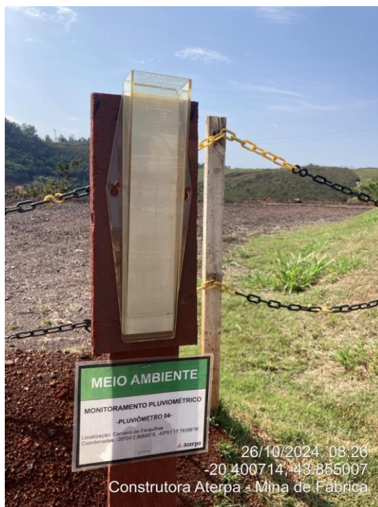
Figura 64 - Pluviômetro do canteiro de obras da construtora Aterpa (Canteiro Forquilha). Vale, 2024.
