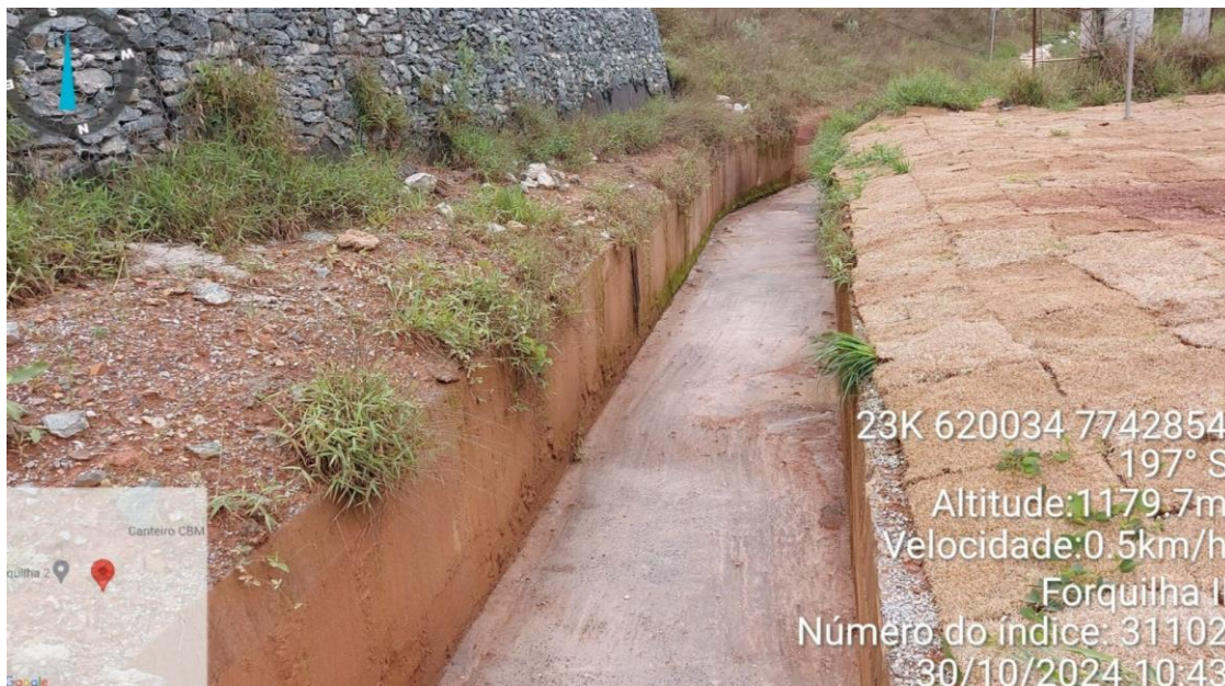
Figura 39 - Status da limpeza e desobstrução dos canais de cintura – Forquilha II (Outubro/24)
