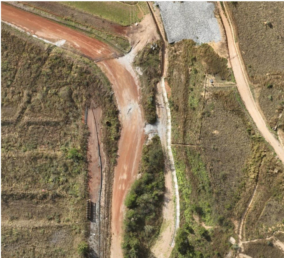
Figura 43 - Status da limpeza e desobstrução dos canais de cintura – Forquilha II (Outubro/24)
