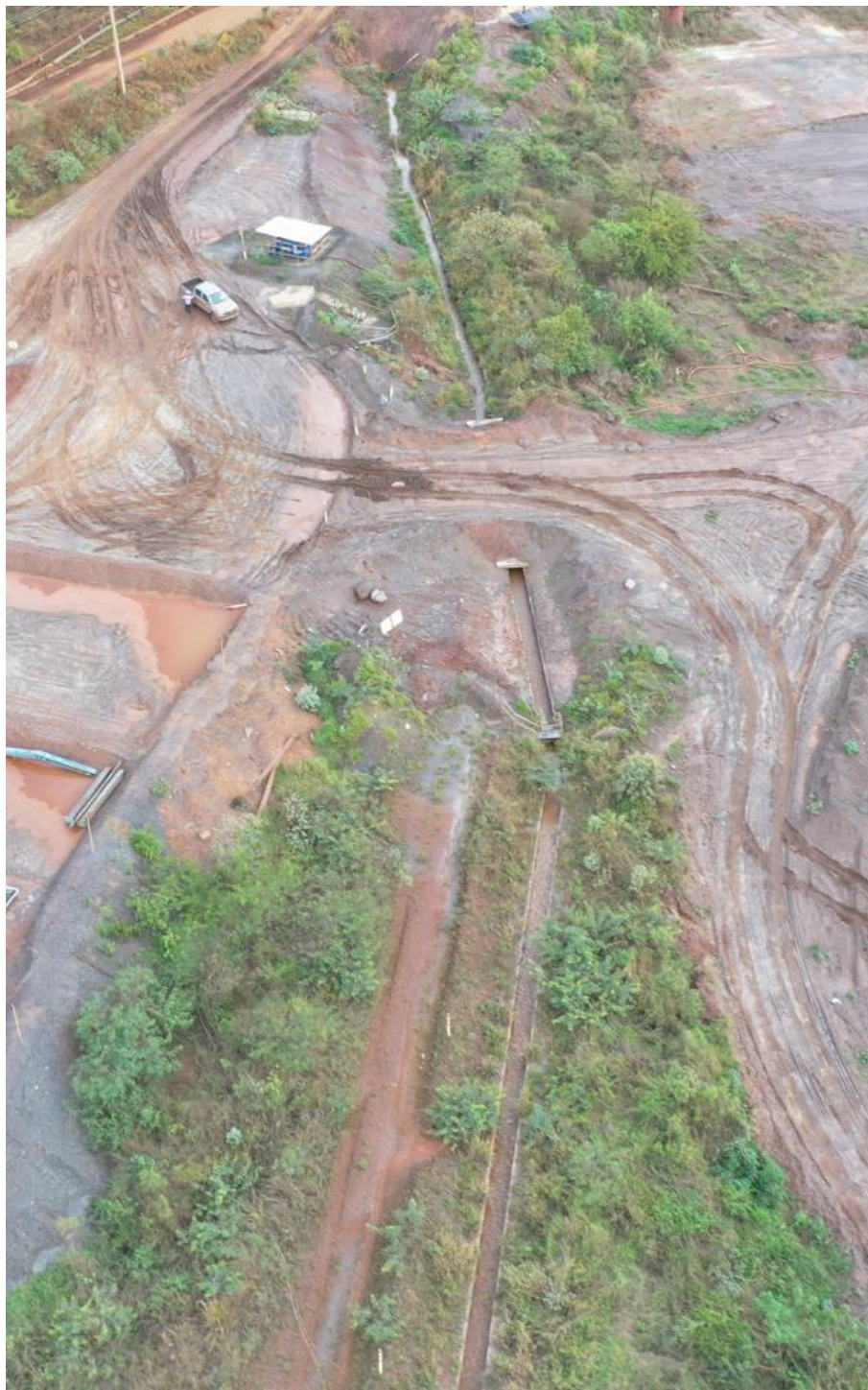
Figura 38 - Forquilha II – Correção de drenagem danificada – margem direita do reservatório - recomendação F2-0182 (Outubro/24).
