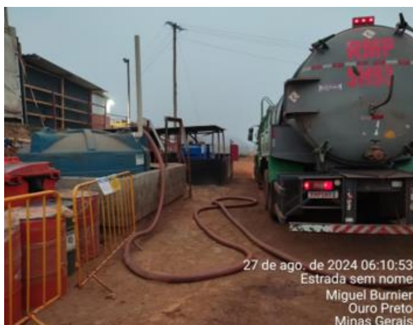
Figura 93 - Limpeza tanque séptico canteiro central Forquilha agosto de 2024.
