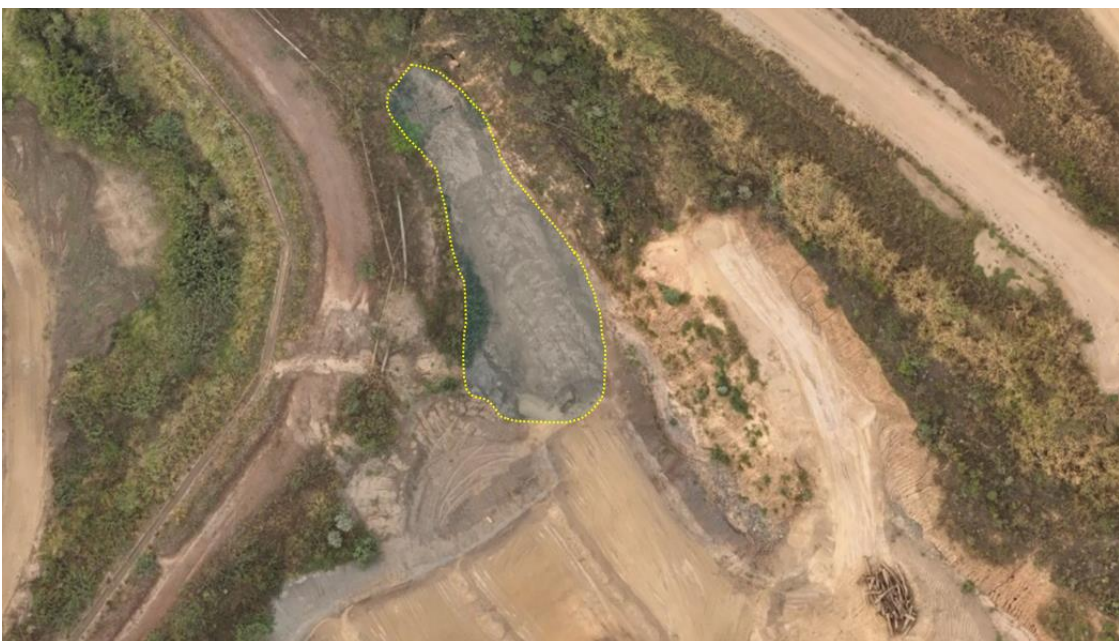
Figura 37 - Forquilha II – Correção de drenagem e área alagada – margem direita do reservatório - recomendação F2-0119 (Outubro/24).
