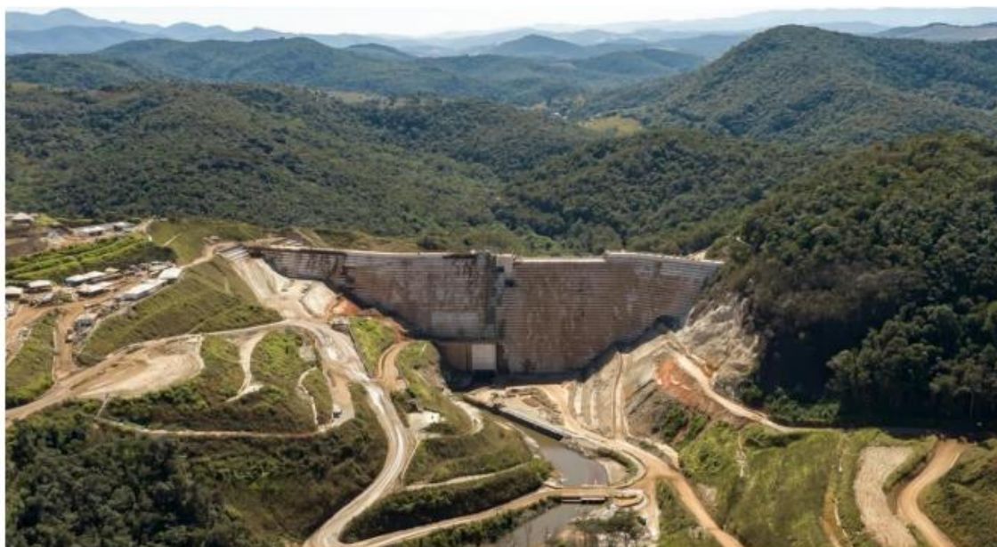
Figura 112 - Estrutura de Contenção a Jusante Fábrica. Fonte: Vale, 2022.
