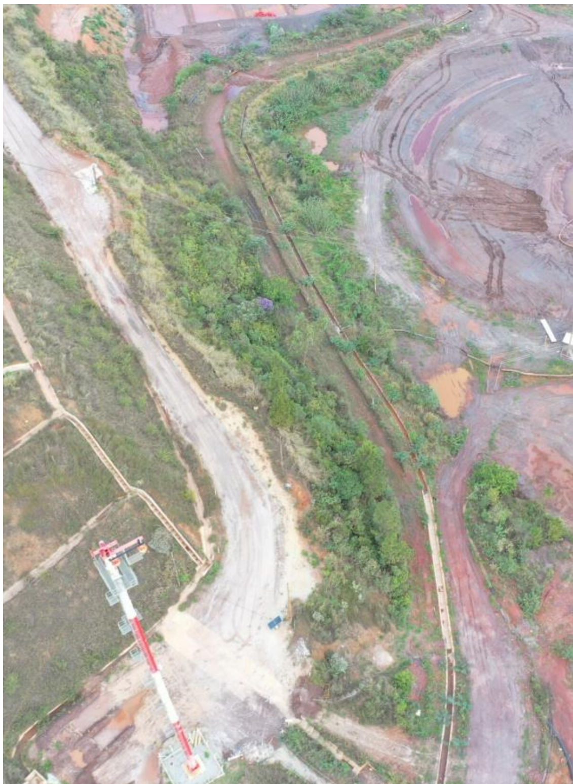
Figura 41 - Status da limpeza e desobstrução dos canais de cintura – Forquilha II (Outubro/24)
