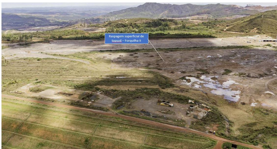
Figura 17 - Raspagem superficial no reservatório de Forquilha II (Outubro/24)
