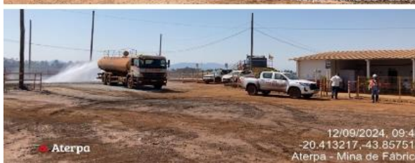
Figura 56 - Aspersão frentes de obras da contrata Aterpa (canteiro DB). Fonte: Vale, setembro, 2024.
