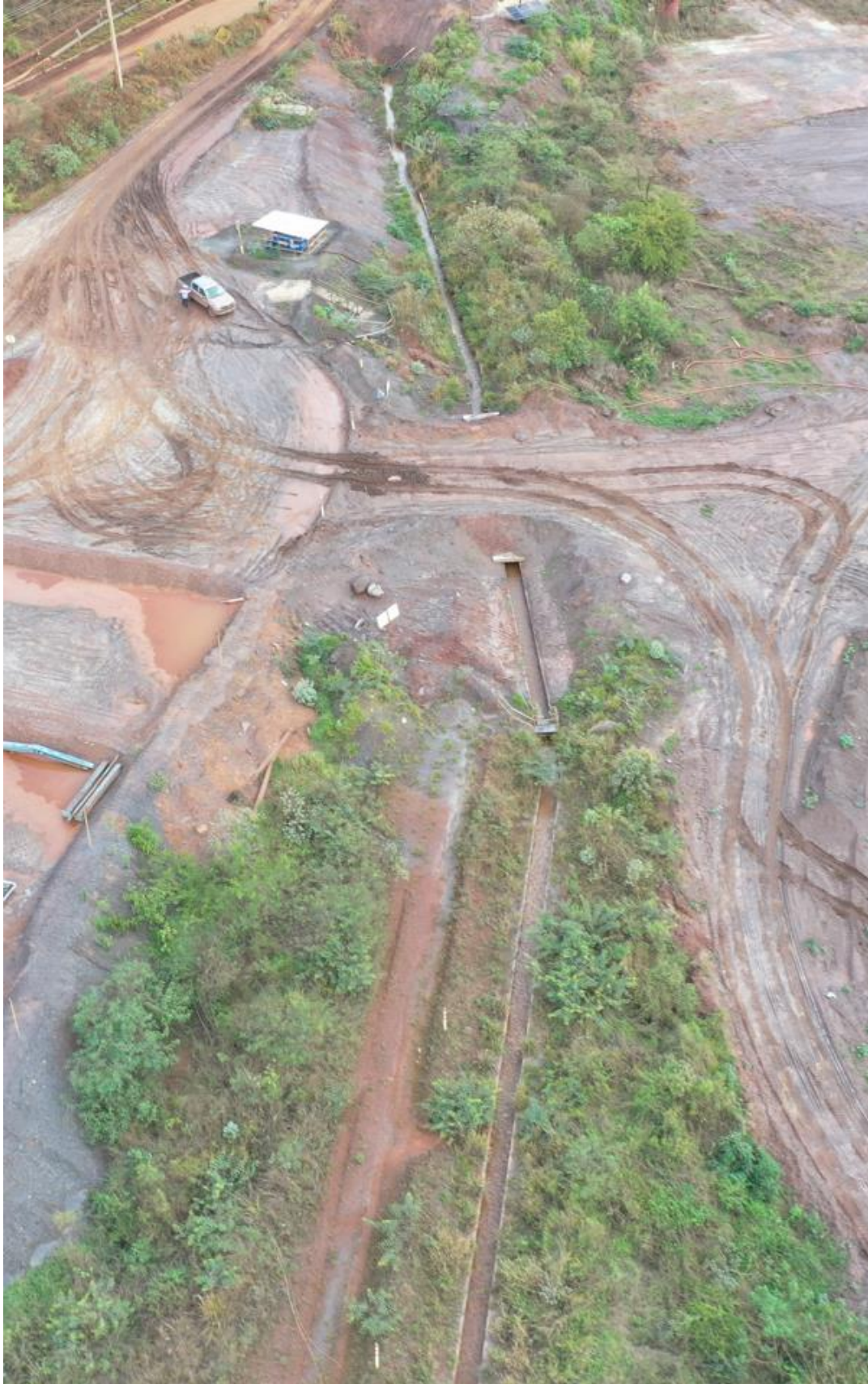
Figura 42 - Status da limpeza e desobstrução dos canais de cintura – Forquilha II (Outubro/24)
