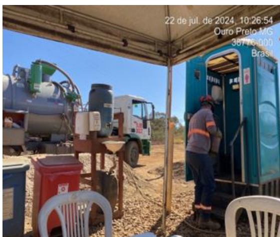
Figura 91 - Limpeza de banheiros químicos por caminhão sucção. Vale, julho 2024.
