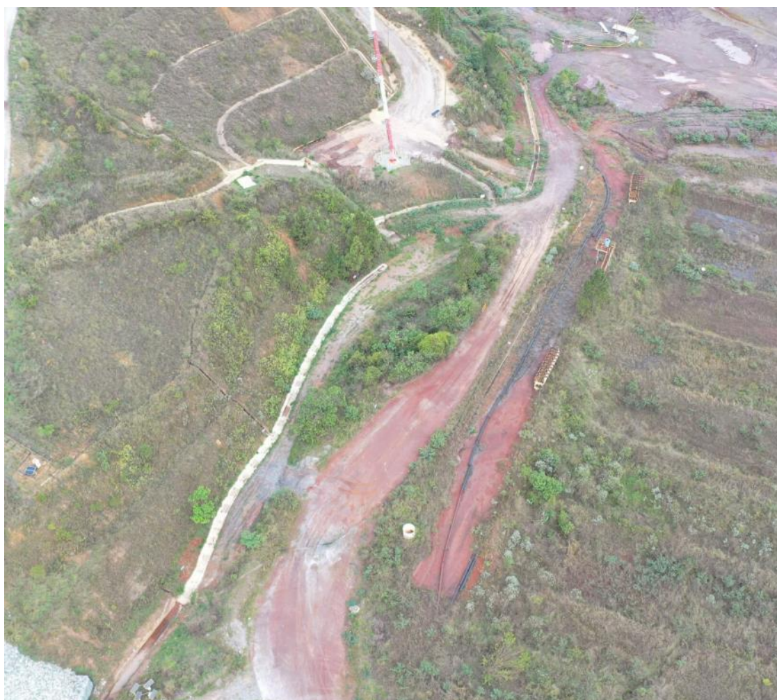
Figura 40 - Status da limpeza e desobstrução dos canais de cintura – Forquilha II (Outubro/24)
