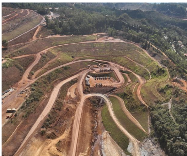
Figura 23 - Vista da PDE-X após processo de revegetação bem estabelecido - período de seca. (Fonte: Vale, 15 de julho de 2024)
