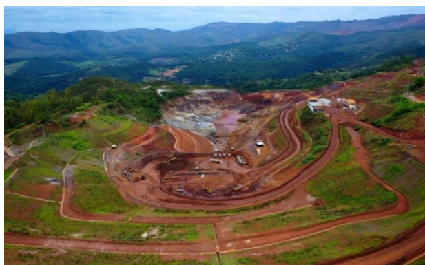
Figura 20 - Vista da PDE-X após processo de revegetação bem estabelecido das ombreiras da barragem. (Fonte: Vale, janeiro de 2024)
