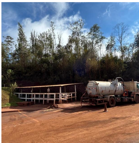
Figura 50 - Higienização do tanque estanque. (Fonte: Vale, outubro de 2024).
