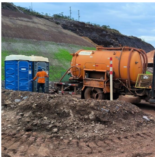
Figura 49 - Higienização de banheiros hidráulicos. (Fonte: Vale, outubro de 2024).
