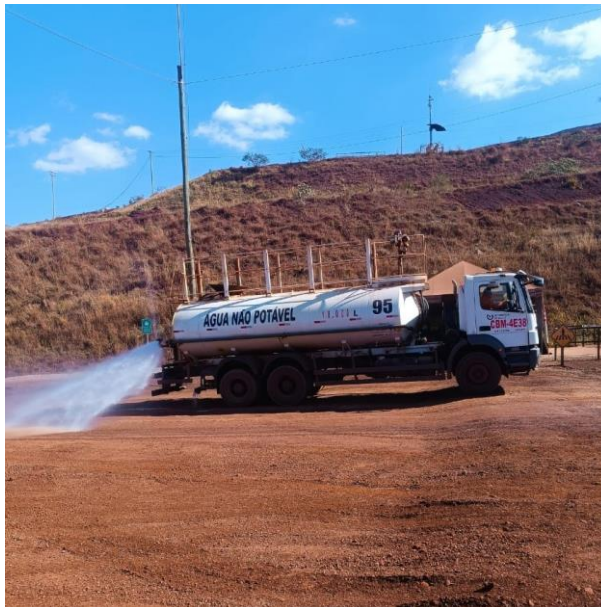
Figura 27 - Umedecção nos acessos a baía 2. (Fonte: Vale, outubro de 2024).
