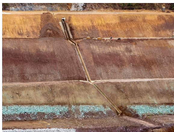
Figura 10 - Vista drenagens ombreira esquerda. - Obras de execução do PRAD. (Fonte: Vale, outubro de 2024).
