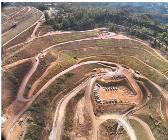
Figura 25 - Vista da PDE-X após processo de revegetação bem estabelecido após período de seca. (Fonte: Vale, outubro de 2024)
