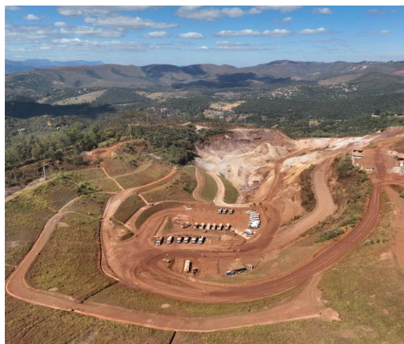
Figura 24 - Vista da PDE-X após processo de revegetação bem estabelecido das ombreiras da barragem - período de seca. (Fonte: Vale, 15 de julho de 2024)
