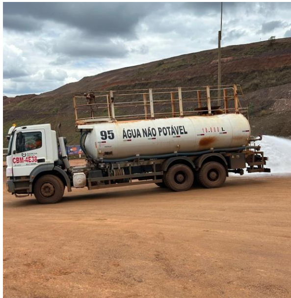
Figura 28 - Umedecção nos acessos ao canteiro. (Fonte: Vale, outubro de 2024).
