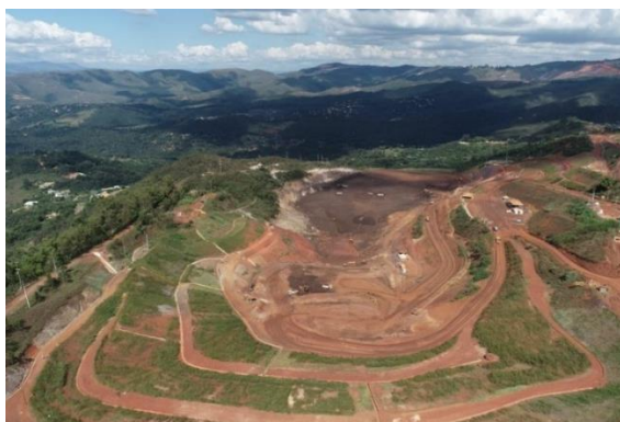
Figura 19 - Vista da PDE-X após processo de revegetação bem estabelecido das ombreiras da barragem. (Fonte: Vale, outubro de 2023)
