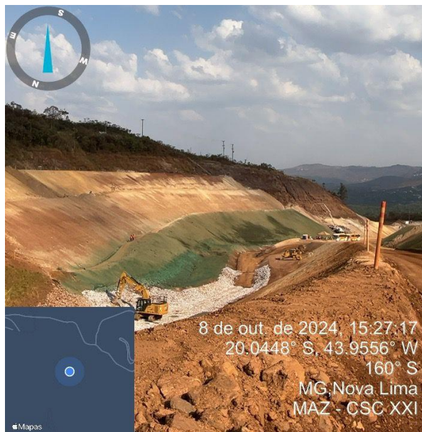
Figura 12 - Aplicação de MVP na ombreira esquerda. (Fonte: Vale, outubro de 2024).
