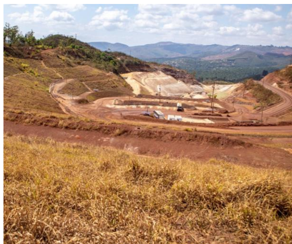
Figura 26 - Vista da PDE-X após processo de revegetação bem estabelecido das ombreiras da barragem após período de seca. (Fonte: Vale, setembro de 2024)
