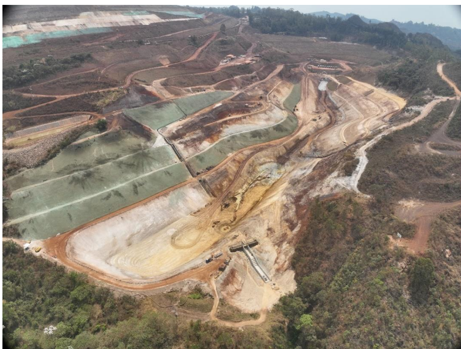
Figura 6 - Execução do PRAD. (Fonte: Vale, outubro 2024).
