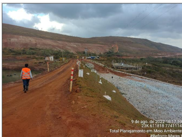
Figura 54. À direita observa-se a área de supressão da vegetação, já com a cobertura de brita. A esquerda a lâmina d'água da barragem Marés I.
