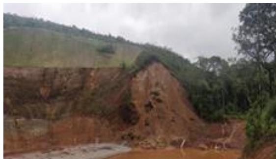
Figura 4-2 Vista do deslizamento provocado pelas chuvas de janeiro/2022
