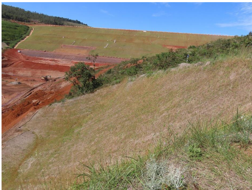
Figura 4-3 - Vista do talude revegetado
