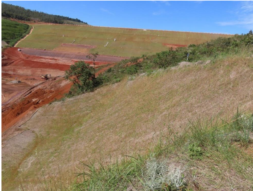
Figura 6-41 - Área de talude revegetado coberto com manta biológica.
