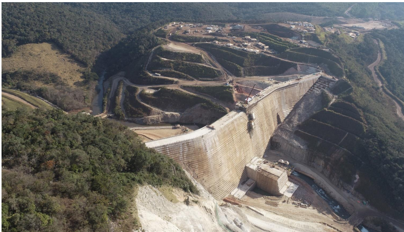
Figura 4.7 – Vista de jusante da ECJ Mina de Fábrica, com detalhe do reforço dos blocos 9 e 10 (julho/2021)
