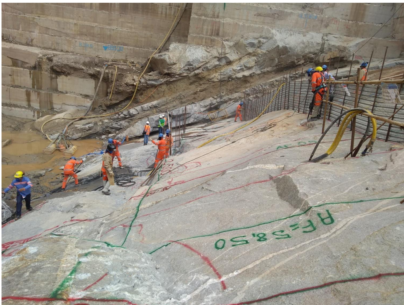
Figura 4.6 – Vista das juntas com preenchimento de até 2,0 m de material com predominância areno-siltosa e baixa coesão, sob blocos 9 e 10, antes da execução do reforço de jusante.
