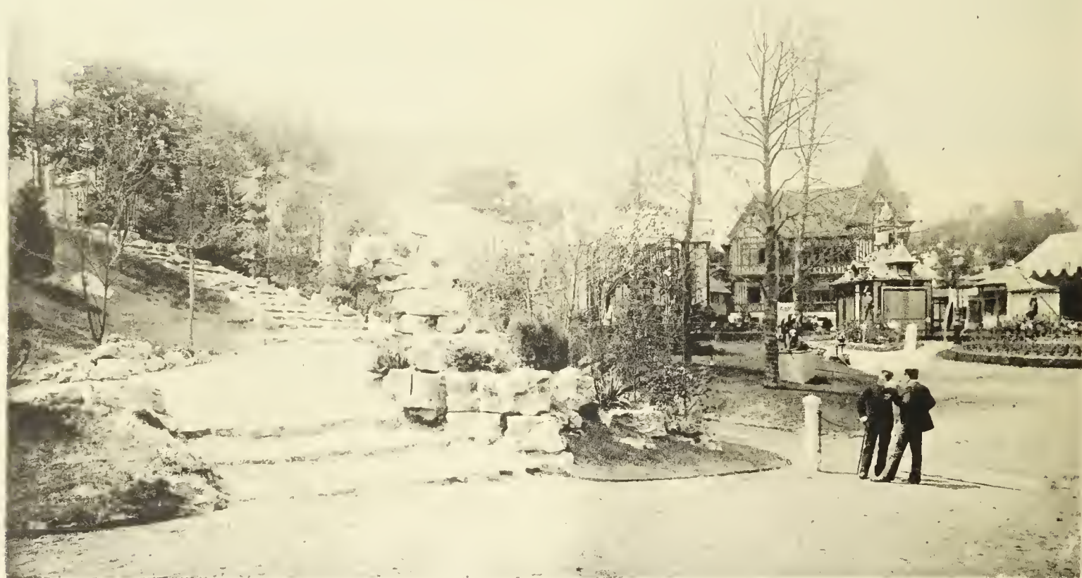
L'Escalier montant à la Terrasse
