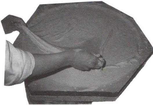
Fig. 6.20 : Mise en place du tissu de verre trempé dans le plâtre adjuvanté
