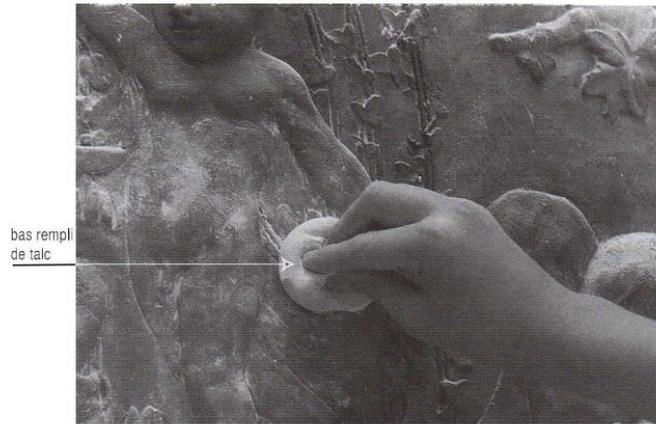
Fig. 5.54 : Talquer le modèle
