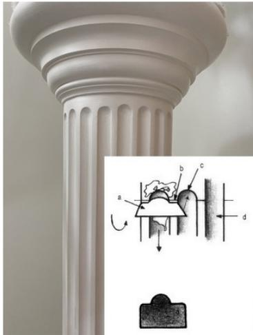
Fig. 4.91 : Traînage d'un arrondi de cannelure
