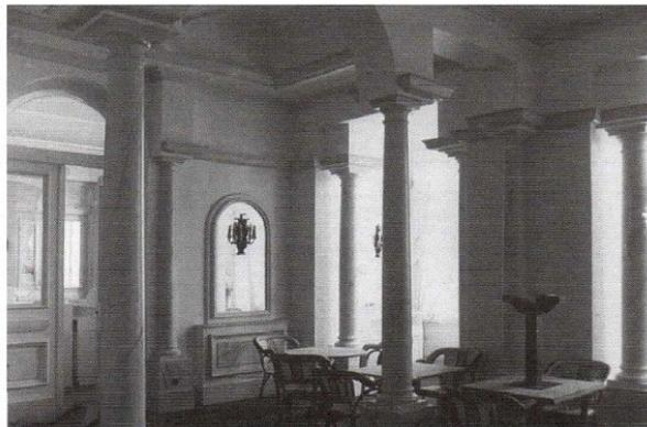
*Fig. 7.25 : Plafonds, corniches, contre-cloisons, arcs et colonnes en staff dans la salle à manger d'un hôtel*
