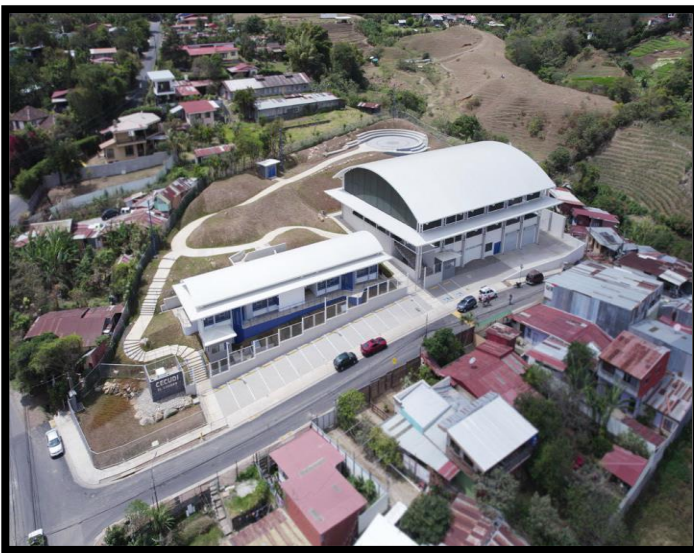
Construcción CECUDI Barrio El Carmen
