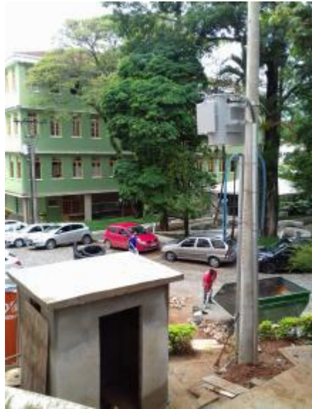
Cabos de baixa e média tensão lançados.
