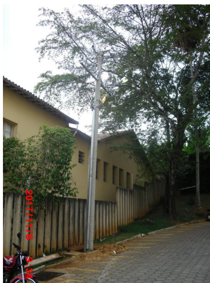
Poste substituído e com a nova montagem, localizado próximo ao antigo prédio DEMEC.
