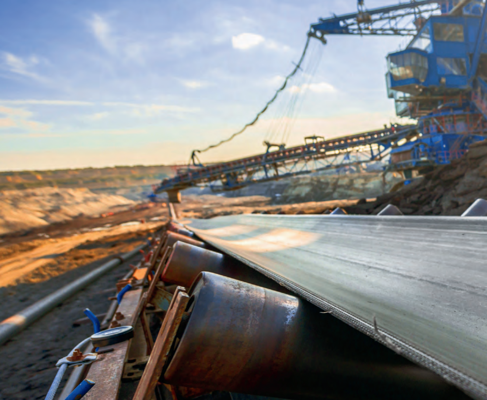
John Dronette, Siemens
