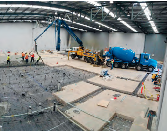
Concrete slab pour at brownfield site.
